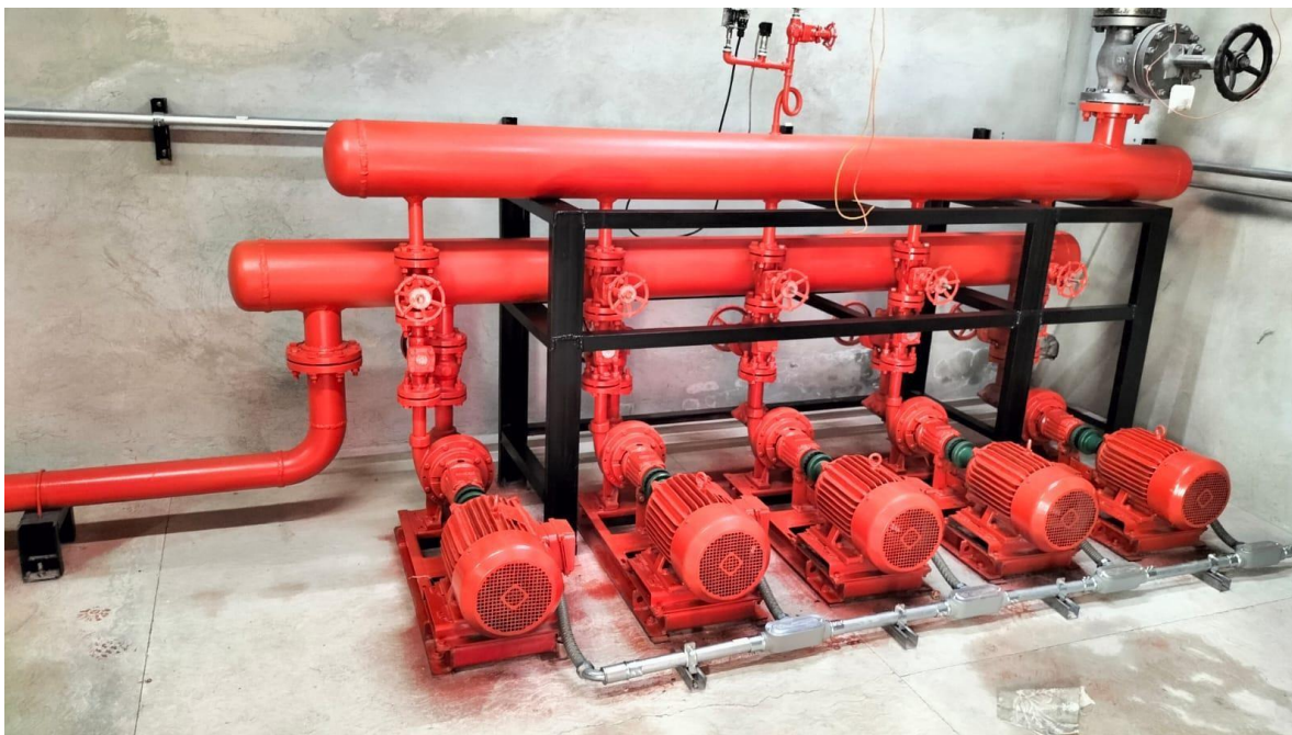
Ilustración 94: Sistema hidráulico. Obtenido de Muñoz Reyes Jorge Alberto y Orta Reyes. Jesús Enrique, (28 diciembre 2022).
