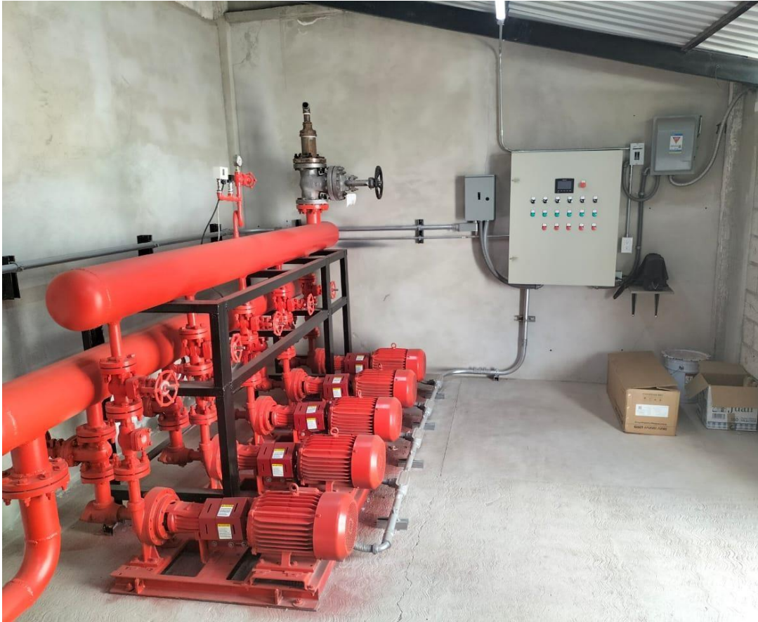
Ilustración 102: Tablero de control y Sistema hidráulico. Obtenido de Muñoz Reyes Jorge Alberto y Orta Reyes. Jesús Enrique, (15 enero 2023).
