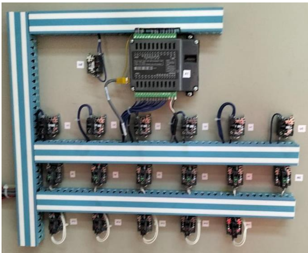
Ilustración 82: Construcción de los interruptores de las bombas. Obtenido de Muñoz Reyes Jorge Alberto y Orta Reyes. Jesús Enrique, (25 noviembre 2022).
