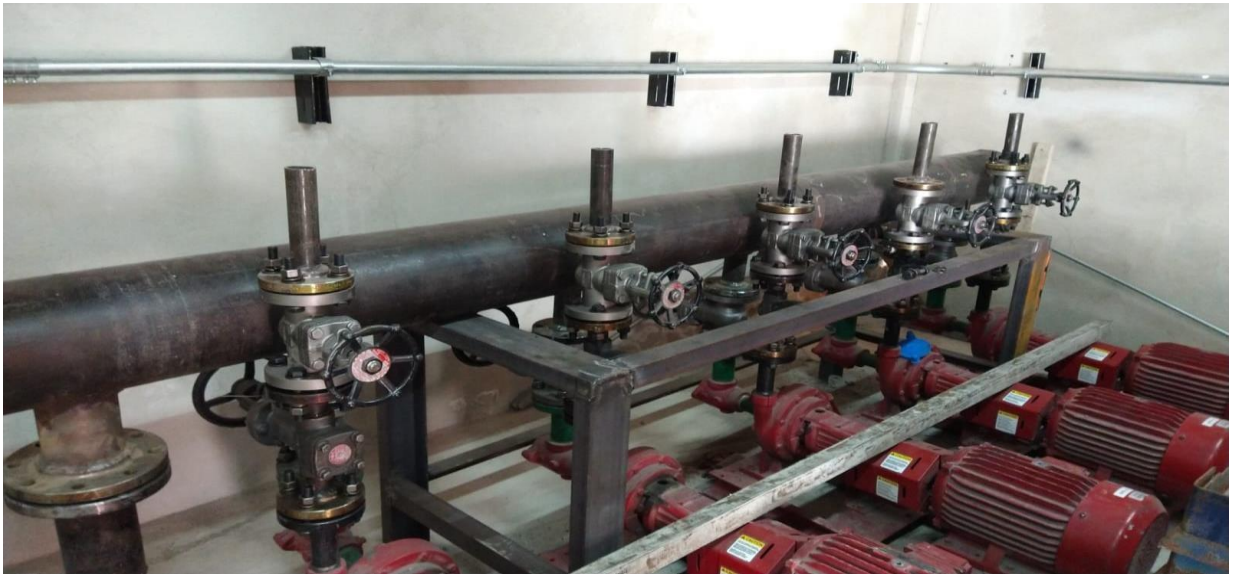
Ilustración 61: Instalación del sistema hidráulico con las bombas proporcionados por la empresa. Obtenido de Muñoz Reyes Jorge Alberto y Orta Reyes Jesús Enrique, (30 agosto 2022).
