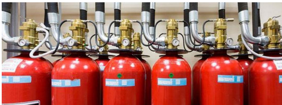
Ilustración 34: Sistema de por agentes gaseosos, obtenido de (Prefire, 16 noviembre 2022)
