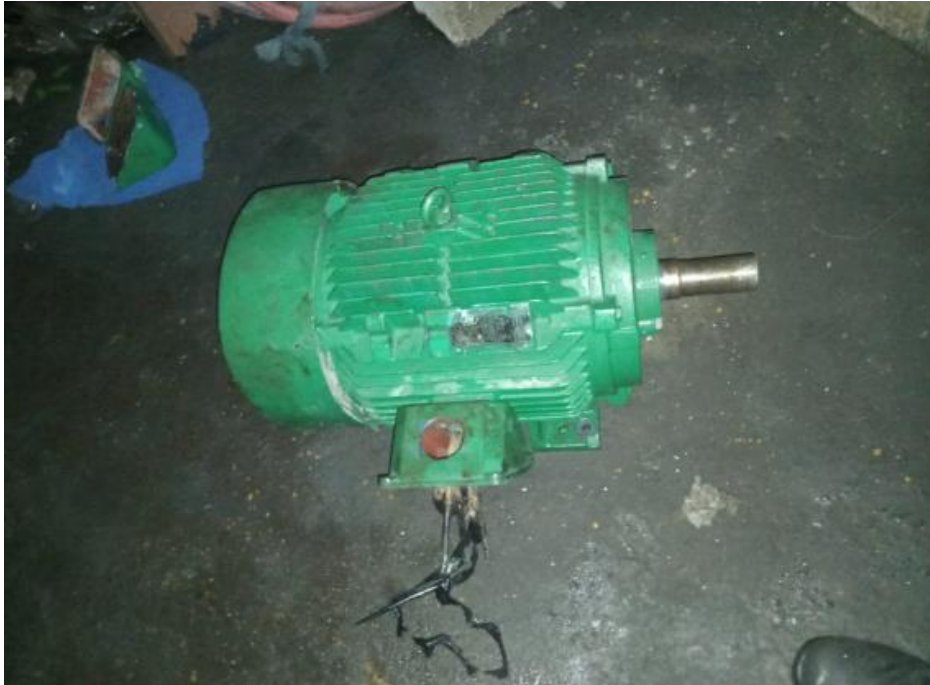
Imagen 122. Extracción de motores de bombas de fosa “L-224” (2). Fuente: fotografía tomada por estudiante.
