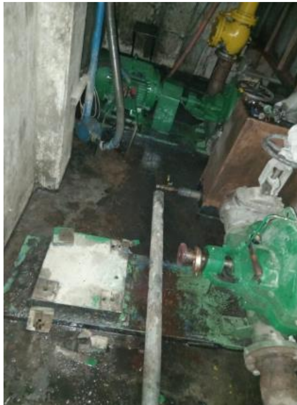
Imagen 125. Extracción de motores de bombas de fosa “L-224” (4). Fuente: fotografía tomada por estudiante.
