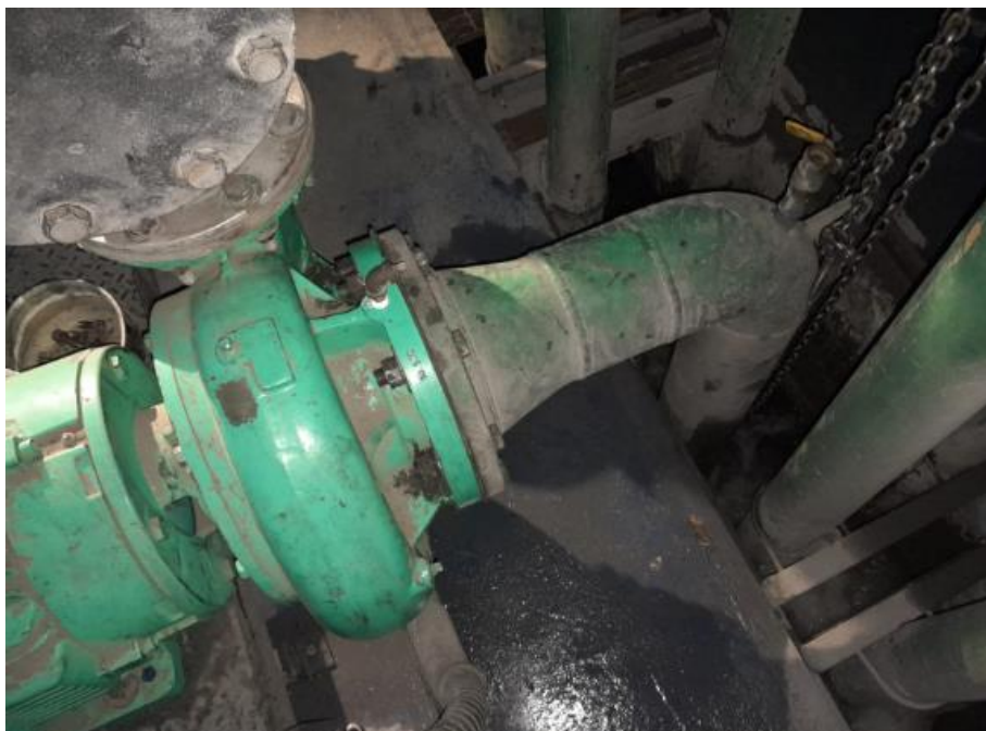
Imagen 82. Montaje de bomba nueva de riego DC-16 (2) . Fuente: fotografía tomada por estudiante.
