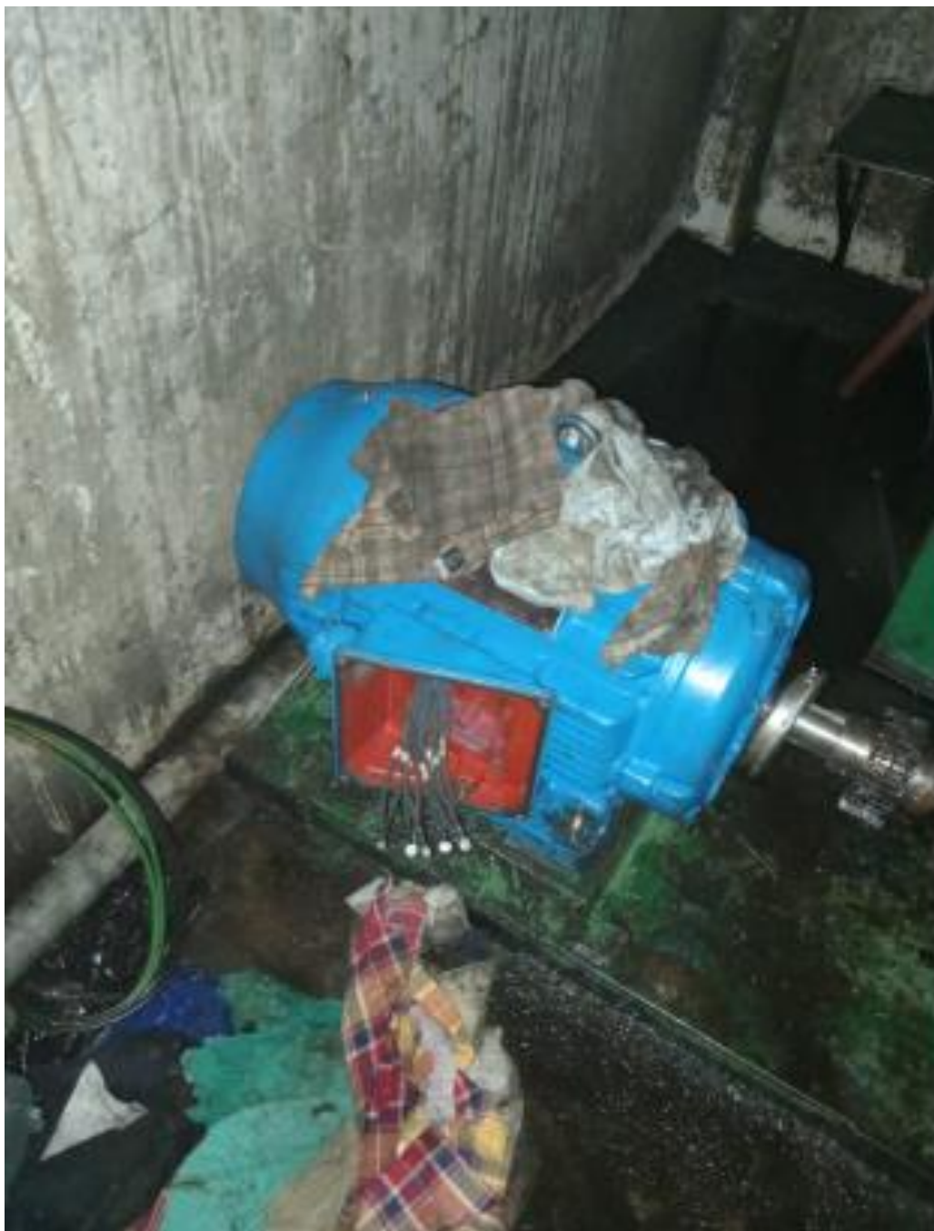
Imagen 148. Conexión de puntas de motores de fosa “L-224” (3). Fuente: fotografía tomada por estudiante.
