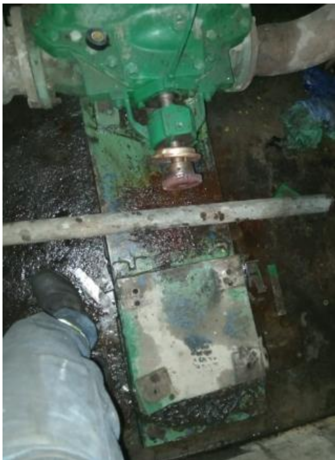
Imagen 121. Extracción de motores de bombas de fosa "L-224" . Fuente: fotografía tomada por estudiante.
