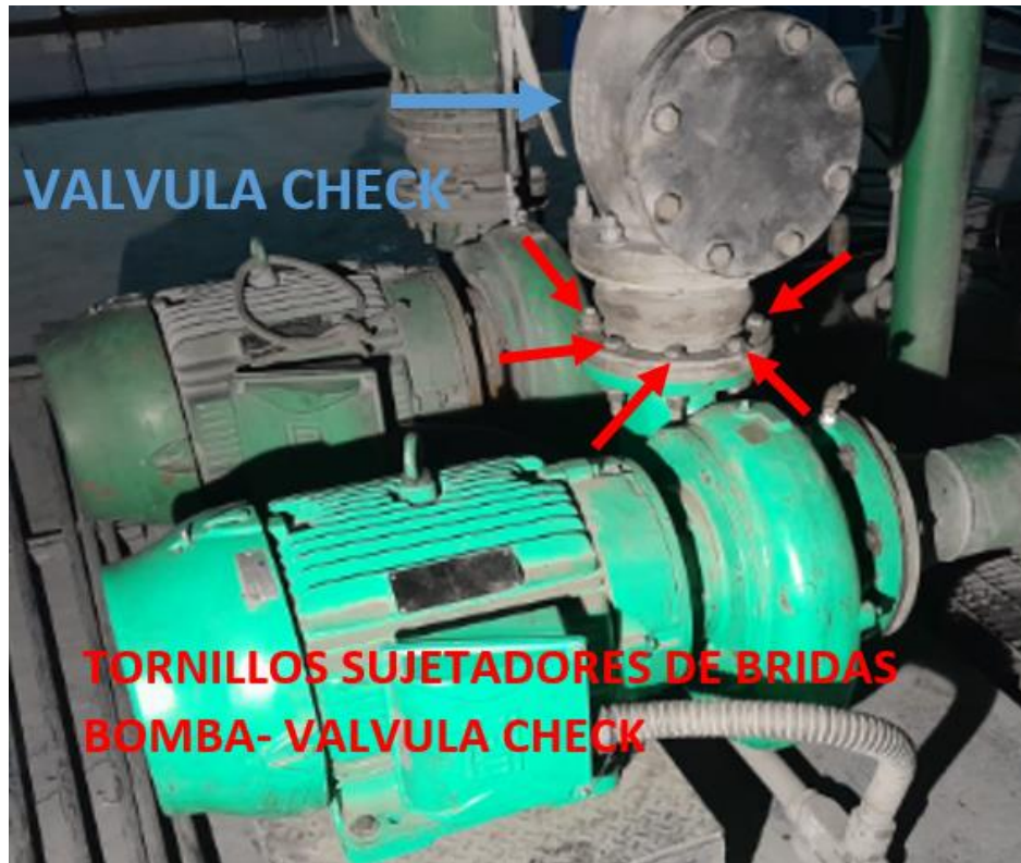
Imagen 79. Bomba nueva de riego DC-16, tornillos sujetadores de bridas bomba- válvula check. Fuente: fotografía tomada por estudiante
