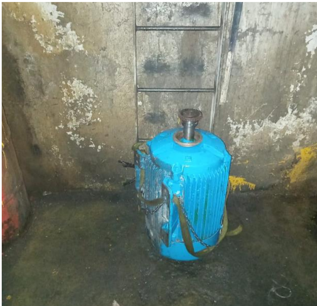
Imagen 139. Maniobra para bajar motores de fosa “L-224” (2). Fuente: fotografía tomada por estudiante.
