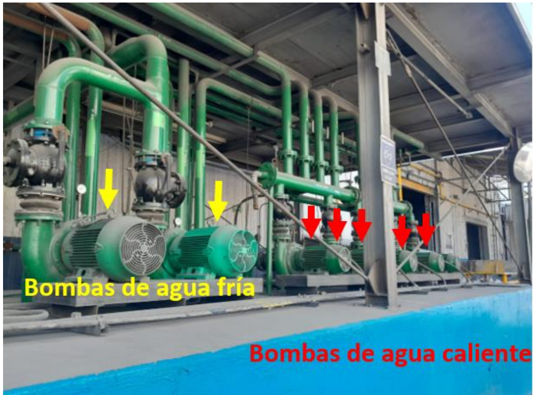
Imagen 69. Bombas de torre de enfriamiento nave #1. Fuente: fotografía tomada y editada por estudiante.
