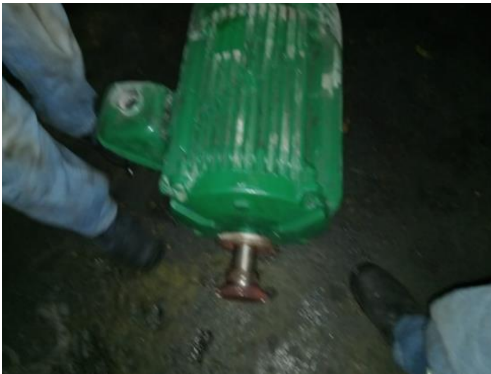
Imagen 123. Extracción de motores de bombas de fosa “L-224” (2). Fuente: fotografía tomada por estudiante.
