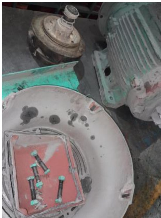
Imagen 74. Desmontaje de bomba de riego DC-16. Fuente: fotografía tomada por estudiante.
