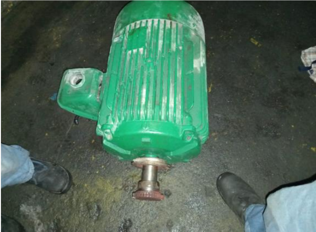
Imagen 124. Extracción de motores de bombas de fosa “L-224” (3). Fuente: fotografía tomada por estudiante.
