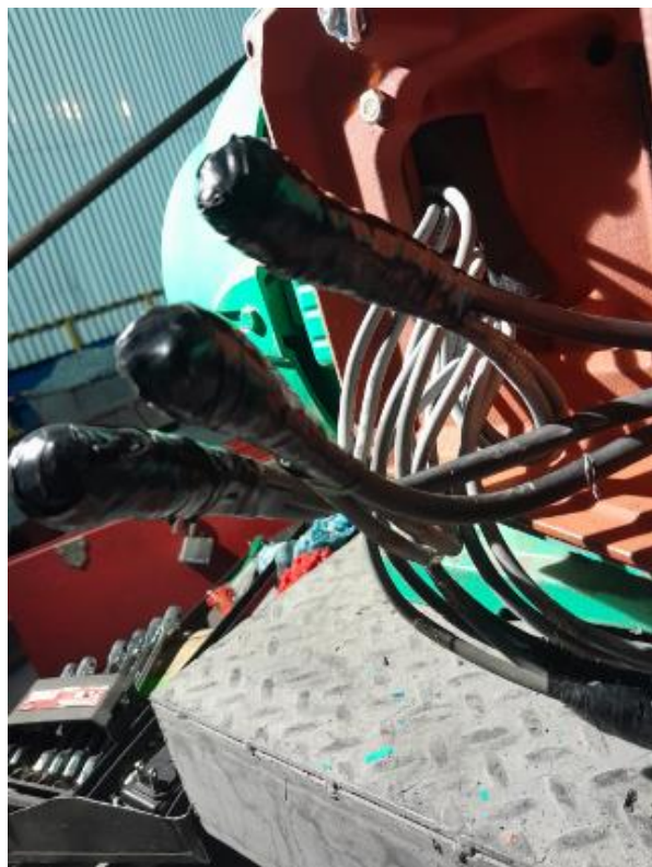
Imagen 91. Conexiones de motor de bomba (4). Fuente: fotografía tomada por estudiante.
