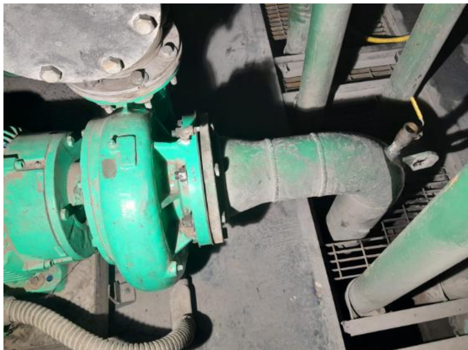
Imagen 85. Montaje de bomba nueva de riego DC-16 (5). Fuente: fotografía tomada por estudiante.
