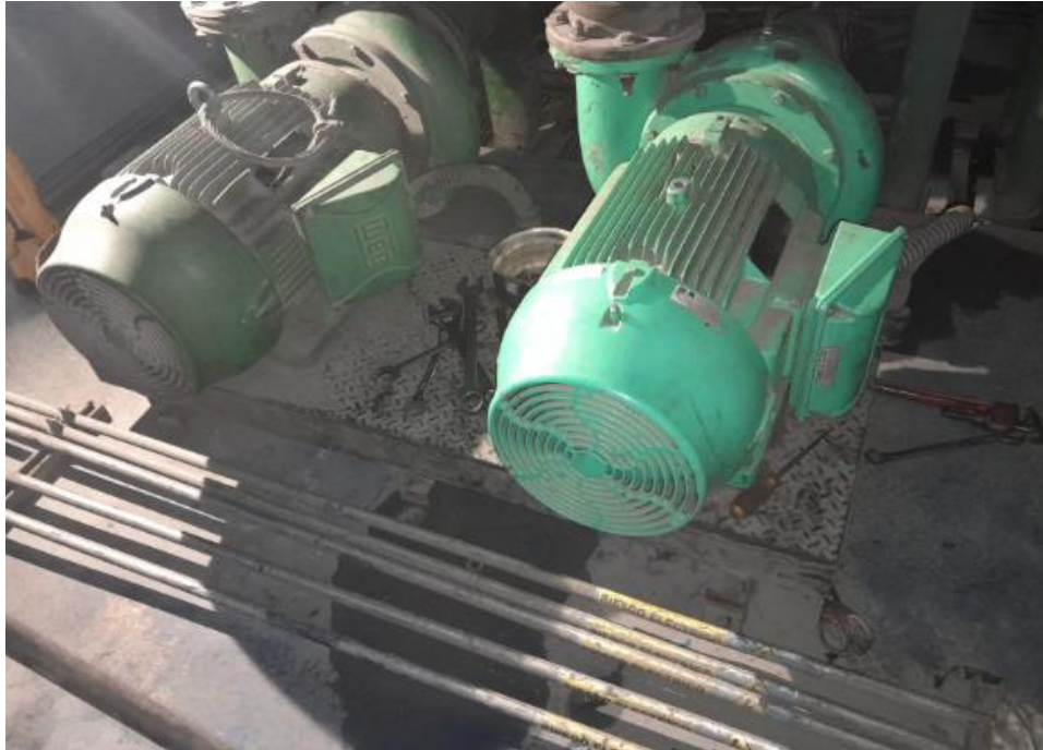
Imagen 84. Montaje de bomba nueva de riego DC-16 (4). Fuente: fotografía tomada por estudiante.
