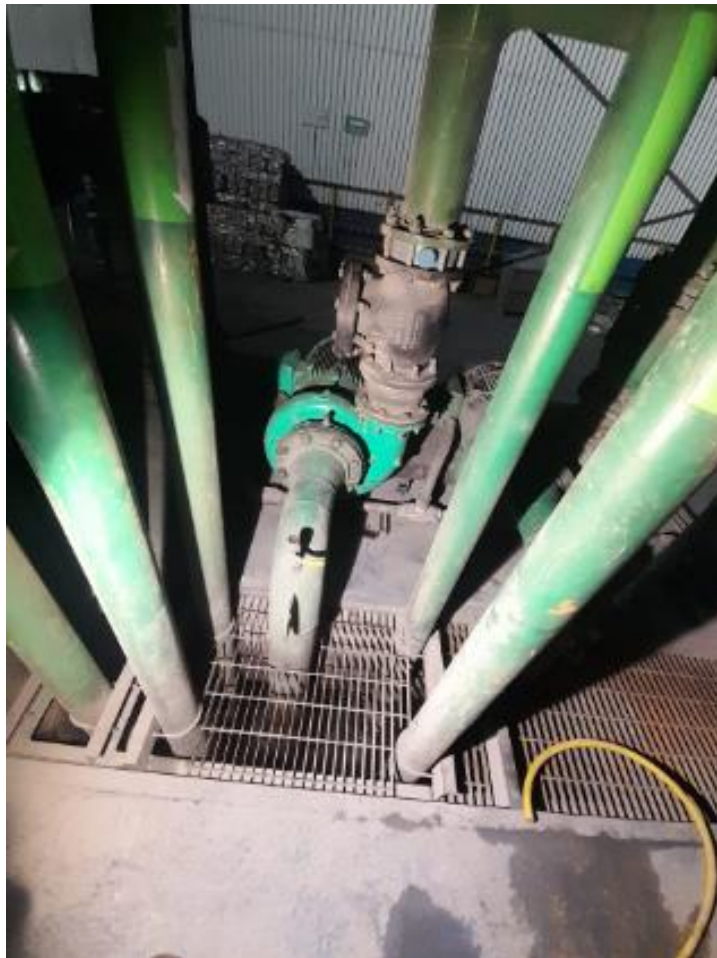
Imagen 87. Montaje de bomba nueva de riego DC-16 (7) . Fuente: fotografía tomada por estudiante.
