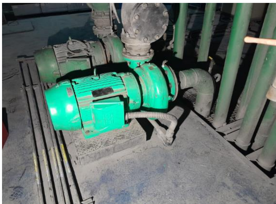
Imagen 81. Montaje de bomba nueva de riego DC-16. Fuente: fotografía tomada por estudiante.
