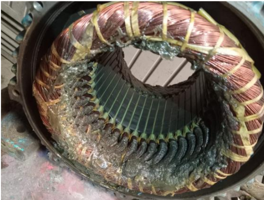
Imagen 134. Desarme de motores de fosa "L-224" (7). Fuente: fotografía tomada por estudiante.
