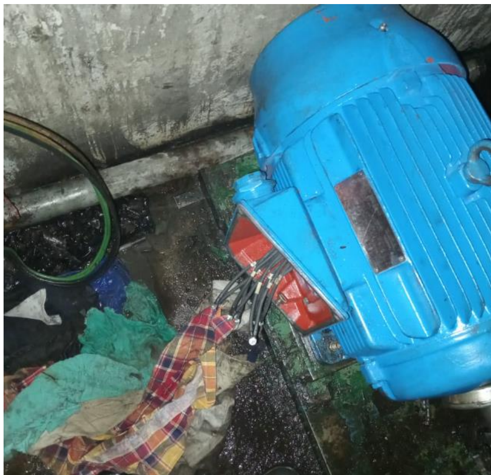
Imagen 147. Conexión de puntas de motores de fosa “L-224” (2). Fuente: fotografía tomada por estudiante.
