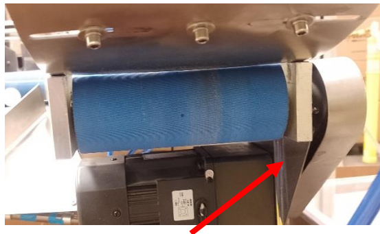
Fig. 27: Cinta Transportadora de Entrada y Salida - Cadenas Expuestas
