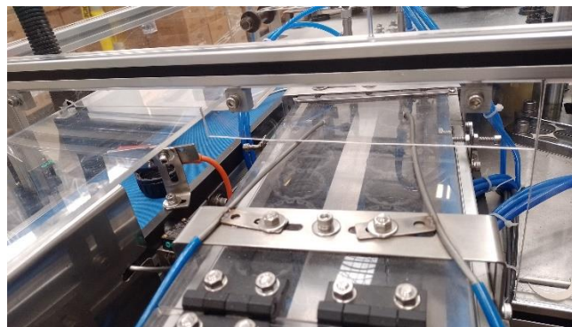
Fig. 51: Guardas de Protección Instaladas en Túnel de Entrada y Salida de Tapas
