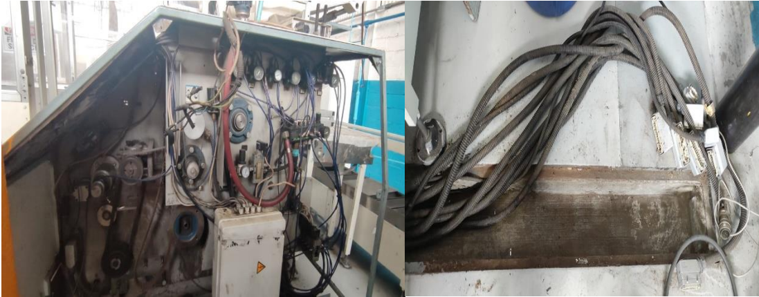
Figura 36 Limpieza de máquina y área de trabajo
