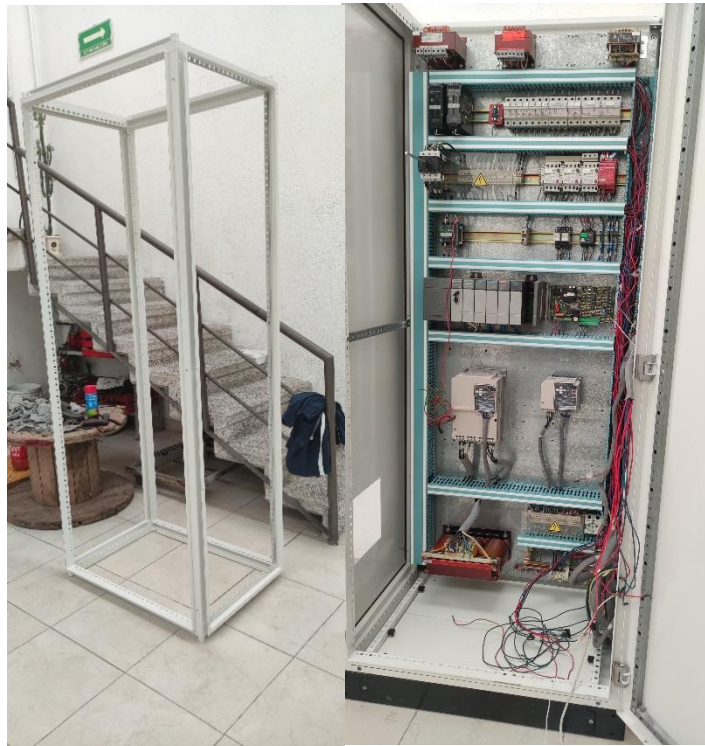
Figura 29 Armado de gabinete y montaje de platina
