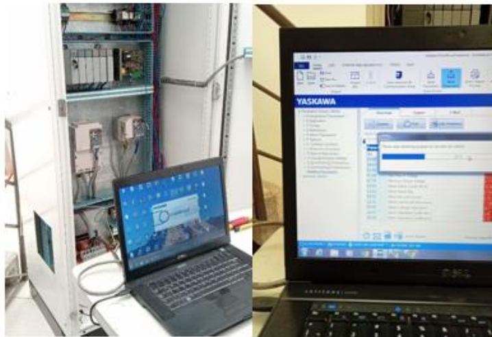
Figura 34 Programación de variadores YASKAWA
