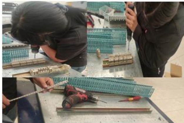
Figura 25 Montaje de canaleta y riel Din.
