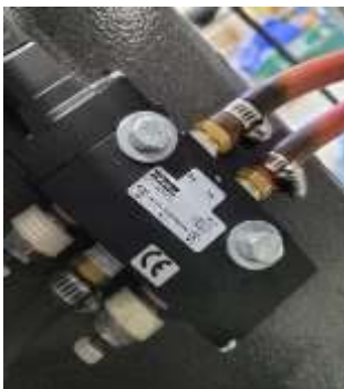
Ilustración 33 Válvulas de lavadora
