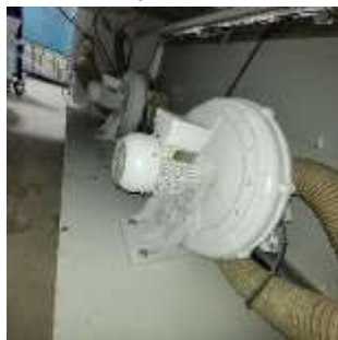
Ilustración 16 Limpieza de ventiladores folder
