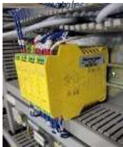
Ilustración 4 Relé de seguridad
