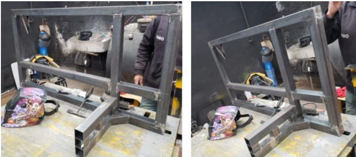
Ilustración 42: Armado de la Base
