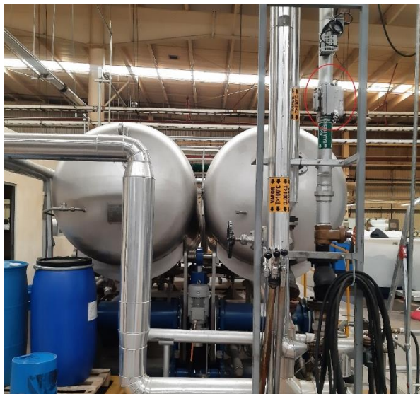
Figura 27.- Colocación de sensor FD-R 80
