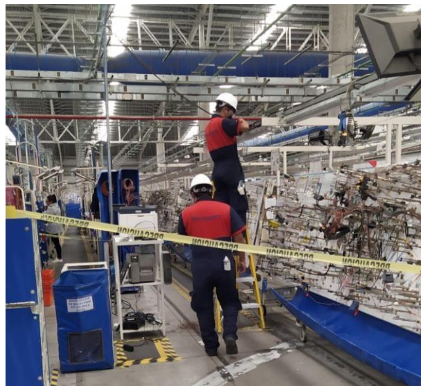
FIGURA 3. 15 Equipo de mantenimiento en área de trabajo
