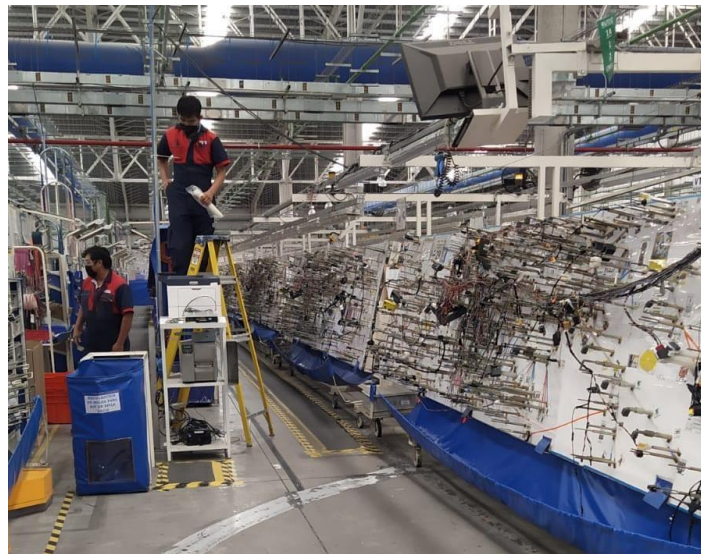
FIGURA 3. 14 Equipo de mantenimiento realizando el ruteo del control
