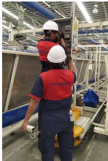
FIGURA 3. 17 Equipo de mantenimiento revisando la conexión en el control principal
