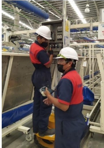
FIGURA 3. 16 Equipo de mantenimiento realizando conexión en el control principal
