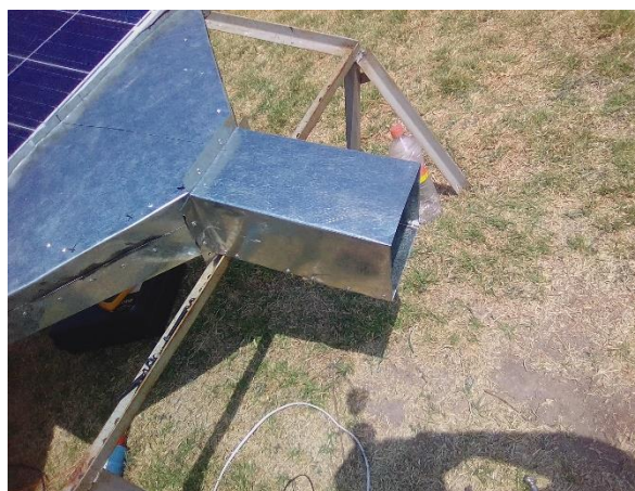
b) Colocación de ducto en canal
