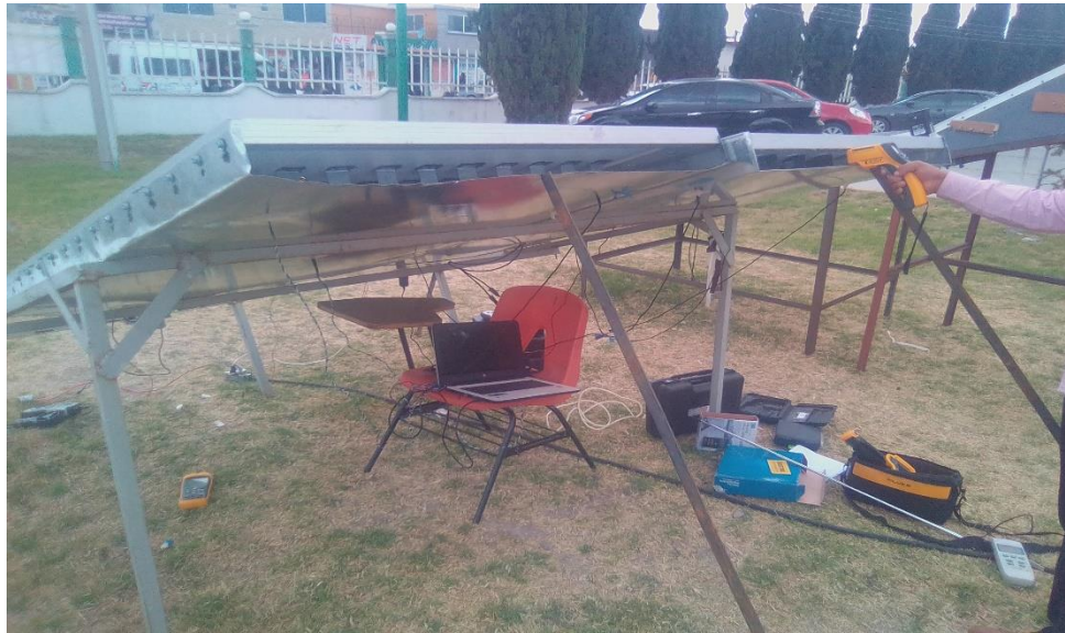
Figura 3-18 Instalación de equipos para realizar las pruebas experimentales.
