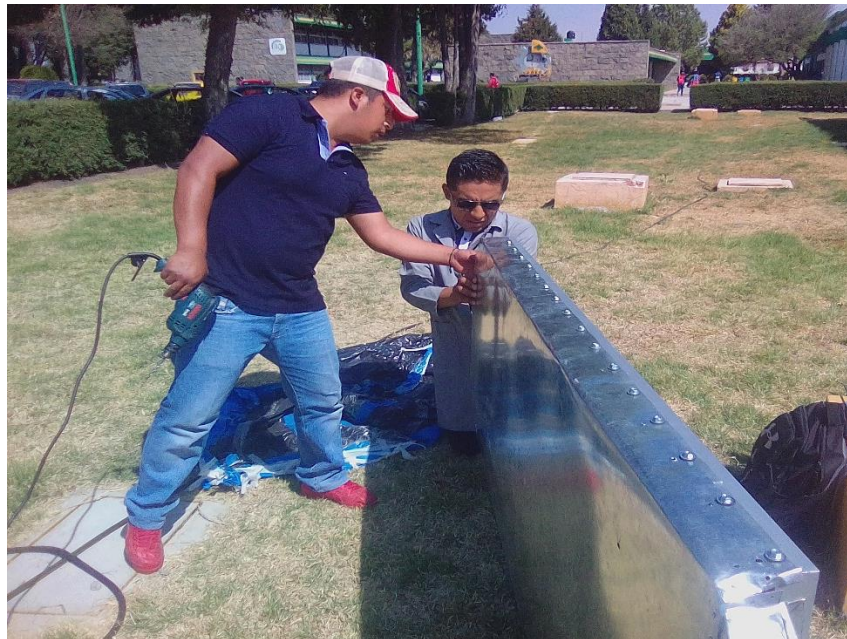
Figura 3-17 Ensamble de canal con panel solar.
