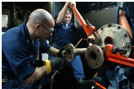
Ilustración 4 Pérdida de piezas o causa de fallas de mantenimiento
