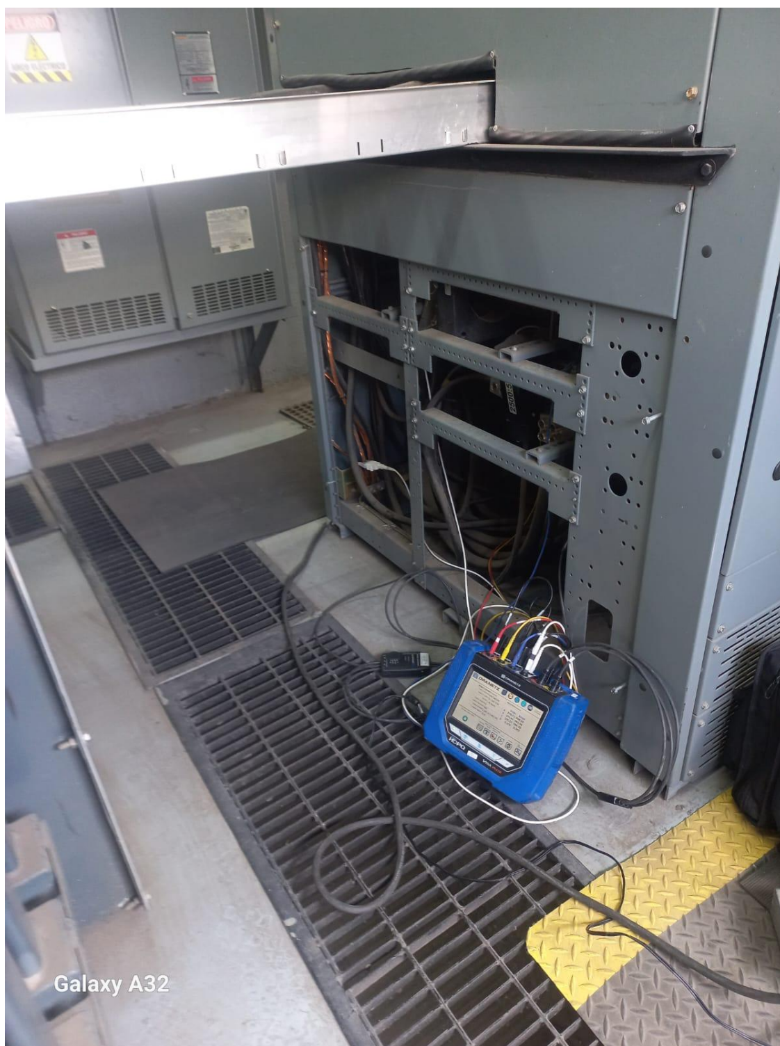
Ilustración 9 Conexión de equipo para el estudio de calidad de la energía a Transformador de 1500KVA
