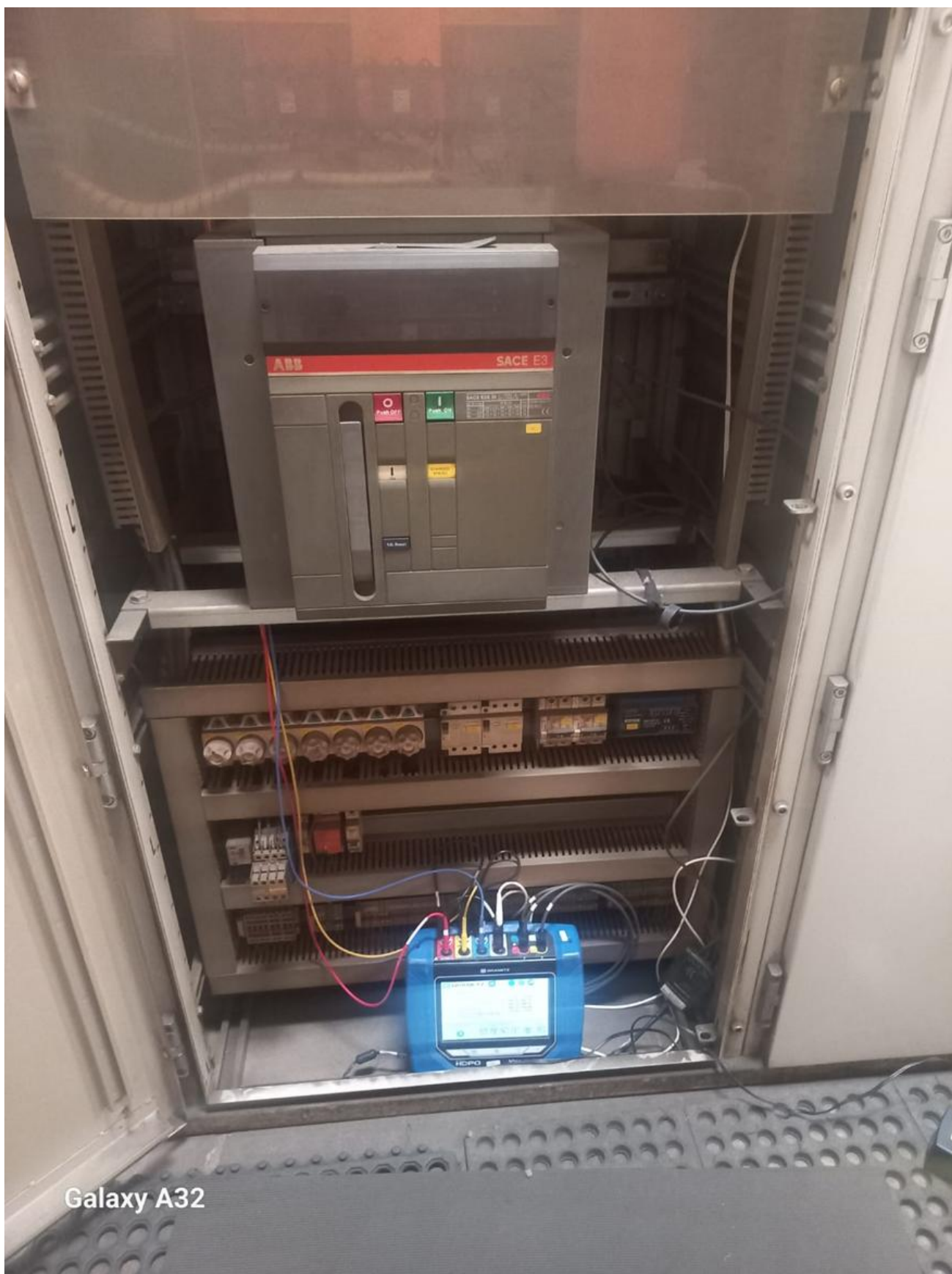
Ilustración 7 Conexión de equipo para el estudio de calidad de la energía a Transformador de 2000KVA
