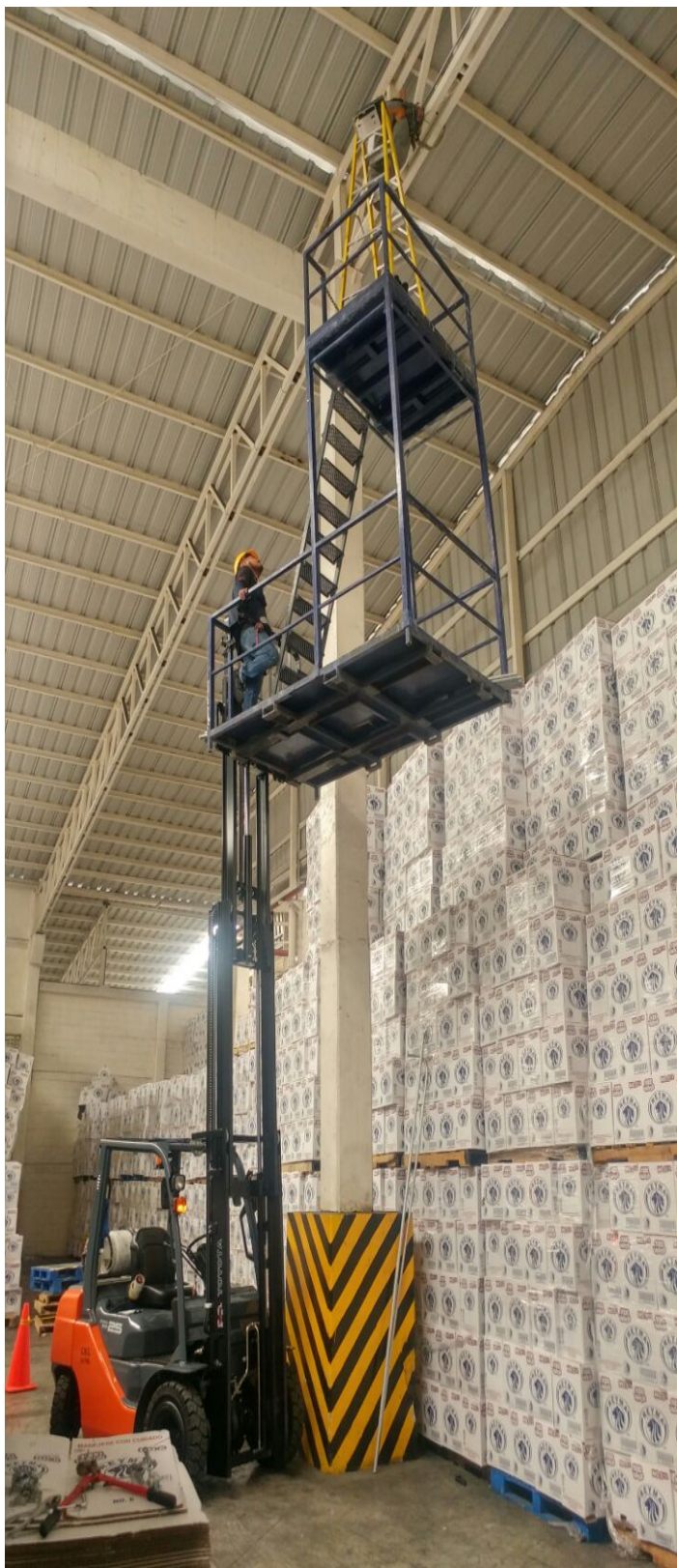
En esta parte se utilizó una plataforma para poder pasar los cables y el tubo por la parte de arriba para evitar daños
