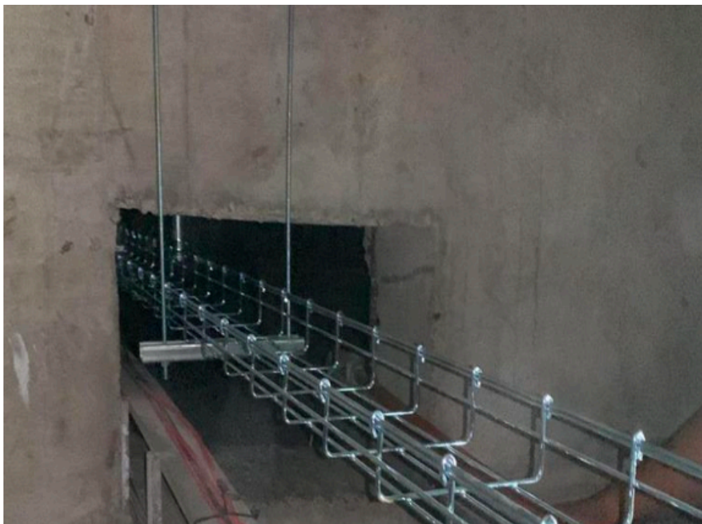
En esta parte del proyecto, comenzamos a realizar la canalización para el cableado estructurado utilizando una canaleta para colocar los cables en la parte subterránea del almacén.
