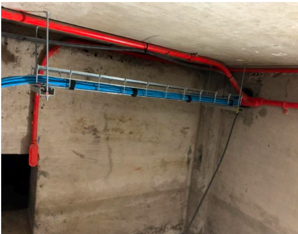
En esta foto podemos apreciar como ya está terminada la canalización y ya están colocados los cables de red y de otros servicios especiales en la canaleta
