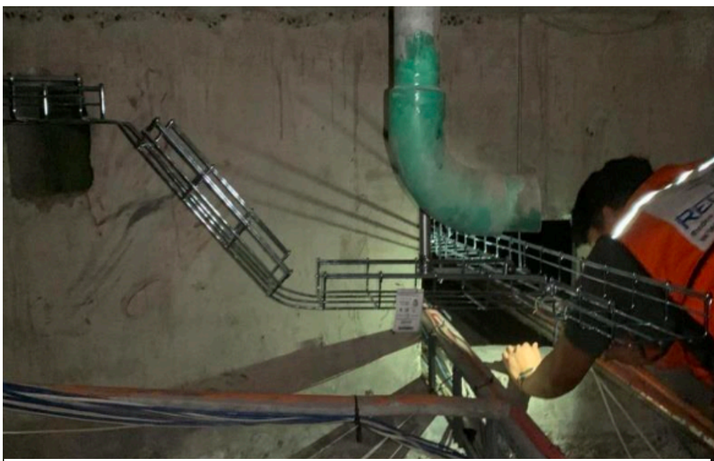
Aquí ya que teníamos toda la canalización lista y empezamos a colocar los cables de red y también de otros servicios en la canaleta
