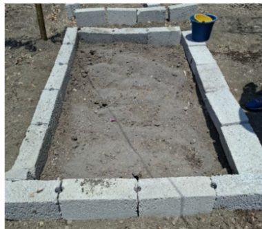
Figura 23. Colocación de bloques perimetrales. Fuente propia.
