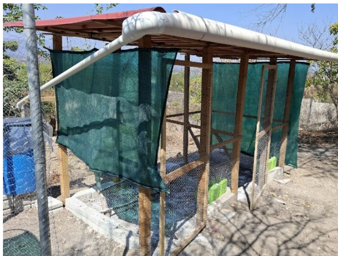
. Instalación de captación de pluvial. Fuente propia.
