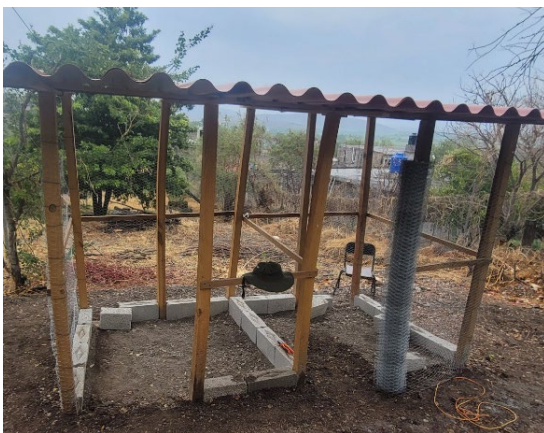
Figura 33. a) Forro del gallinero con tela hexagonal b) Colocación de malla sombra. Fuente propia.
