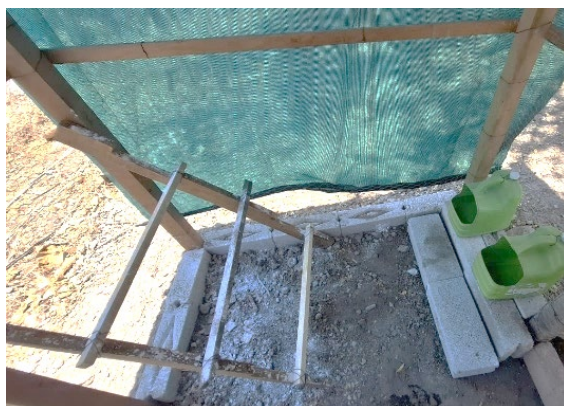
Figura 37. Colocación de cal. Fuente propia.
