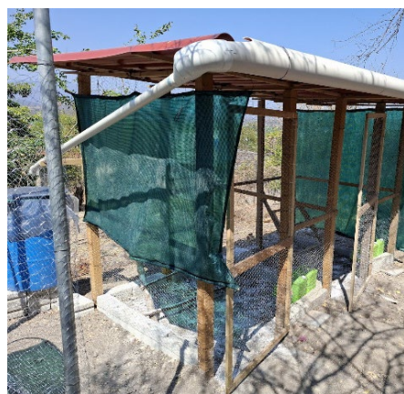
Figura 33. a) Forro del gallinero con tela hexagonal b) Colocación de malla sombra. Fuente propia.
