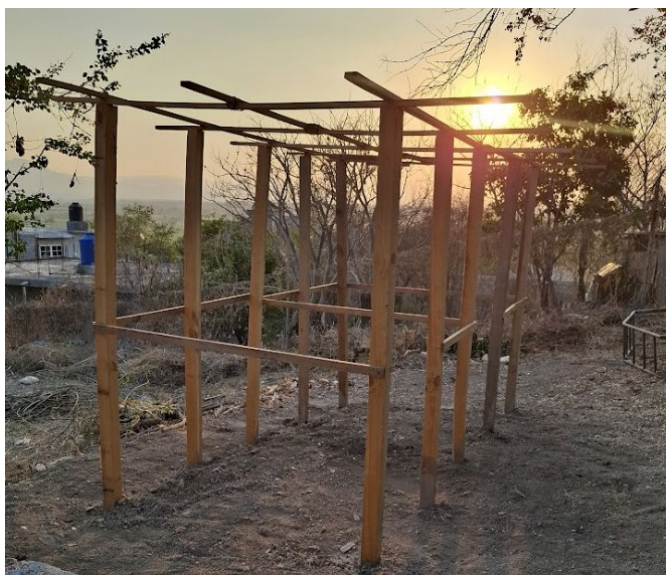
Figura 30. Construcción del armazón de la granja avícola. Fuente propia.
