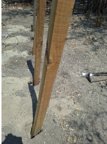
Figura 28. Fijación de postes estructurales. Fuente propia
