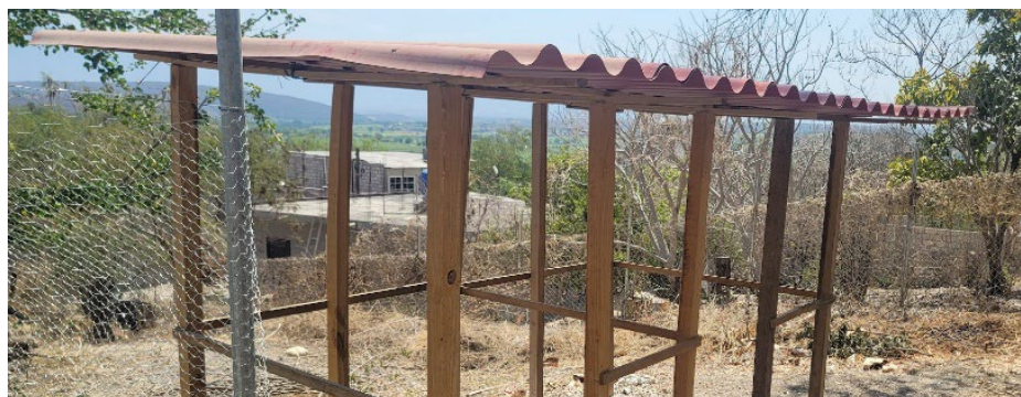
Figura 31. Colocación del techo de la granja avícola. Fuente propia.
