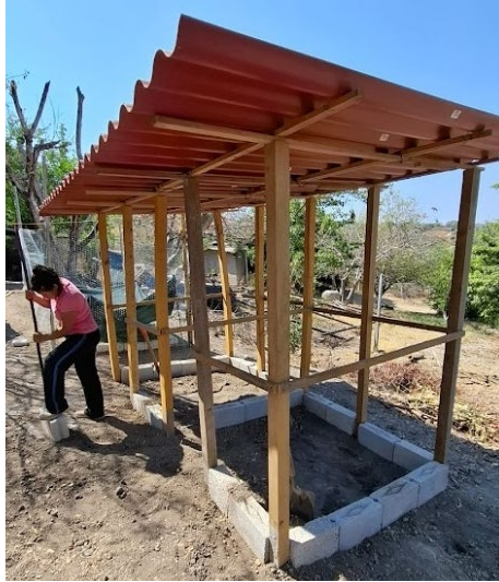
Figura 32. Aseguramiento de perímetro con blocks. Fuente propia.
