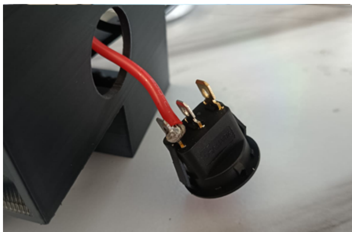
Figura 86: Cable de alimentación positivo de batería soldada a una terminal del botón de encendido
