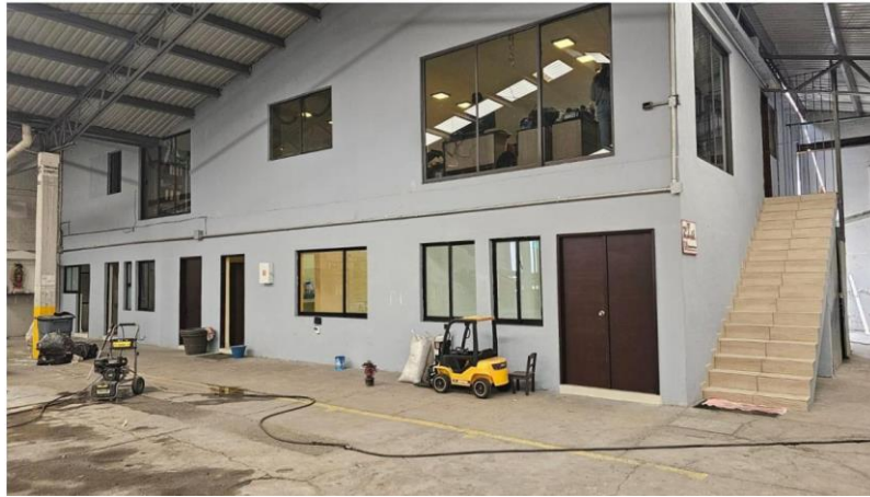
Figura 3.48 Área de oficinas de nave industrial
