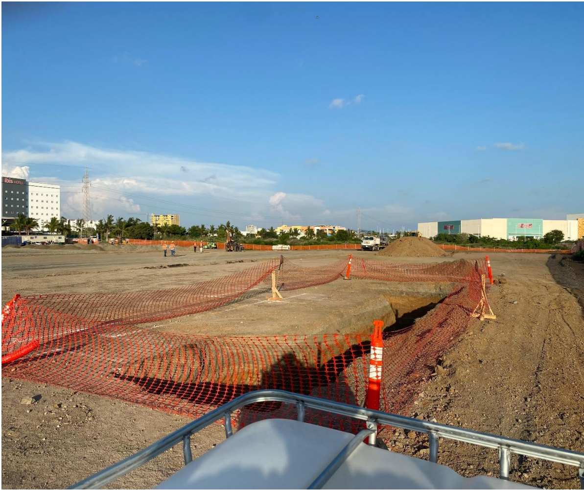
Figura 17 Seguridad y señalamiento de zanjas 2
