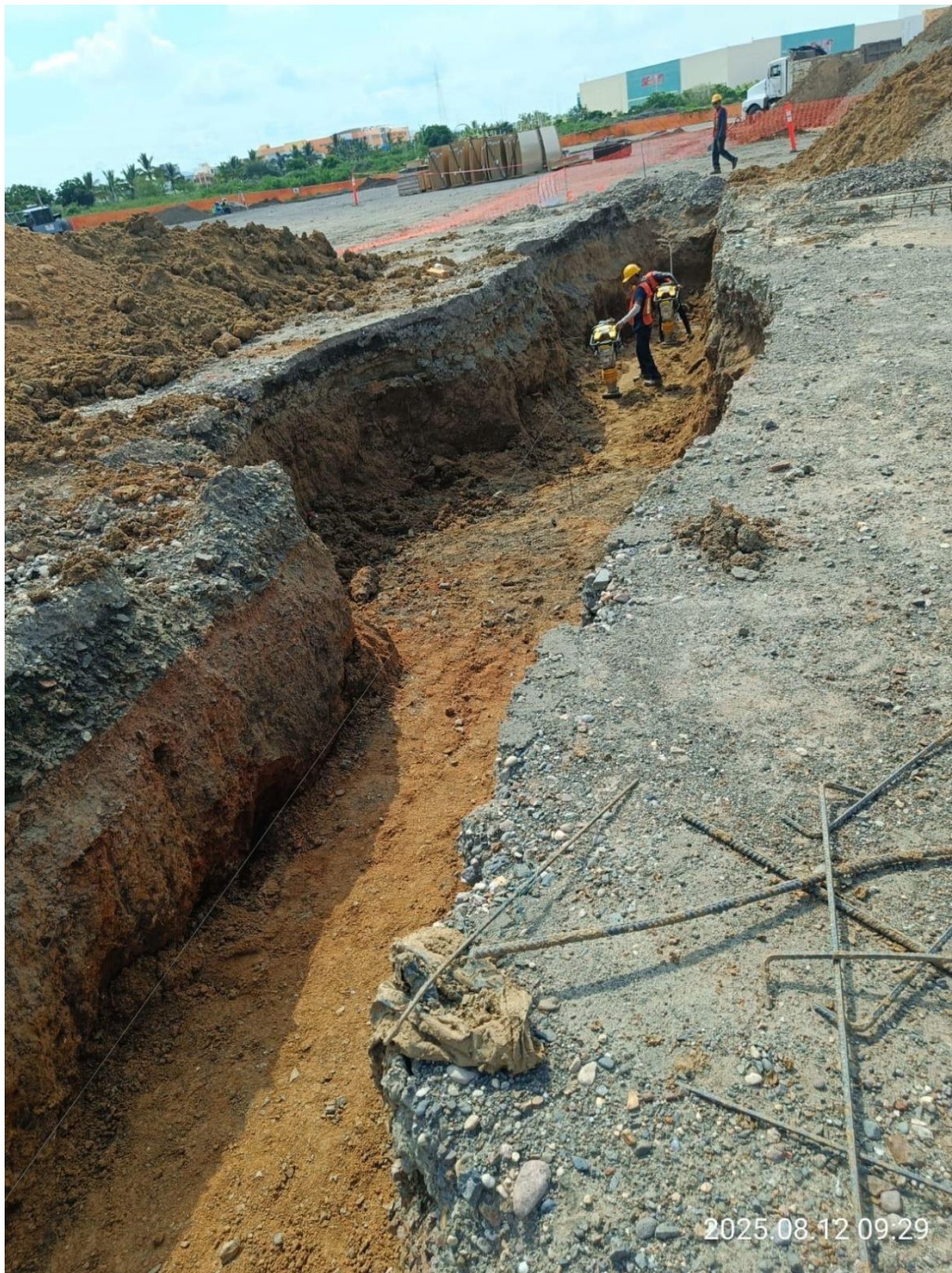
Figura 30 Aplanamiento de tierra
