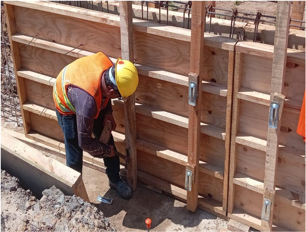
Figura 31 Colocación de estructura de madera
