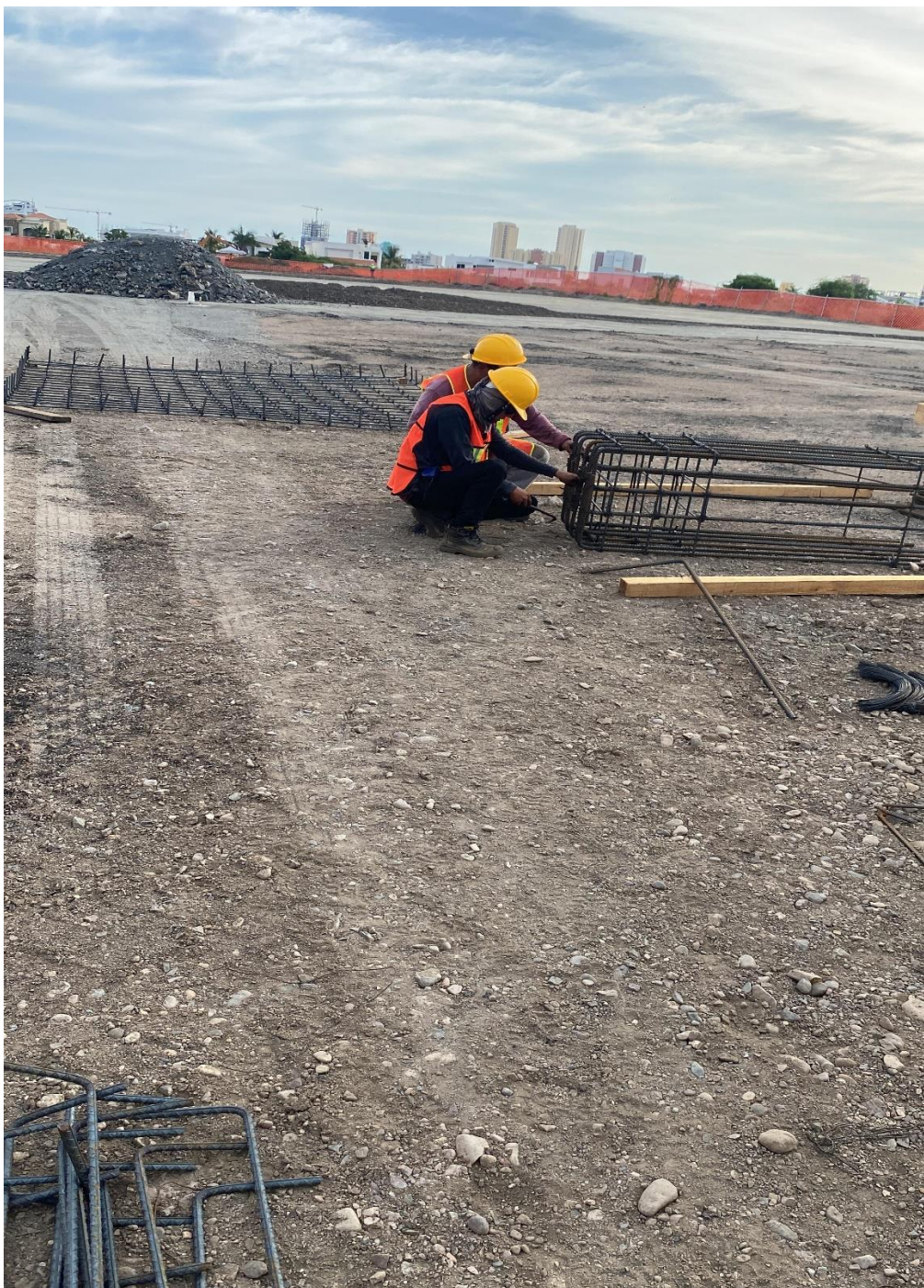
Figura 18 Realización de estructura varilla
