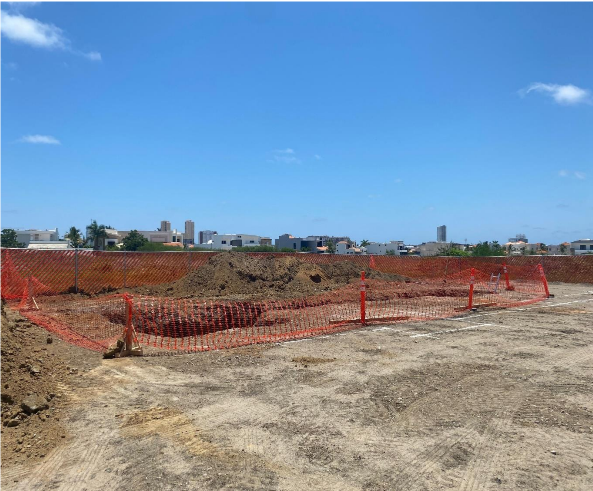
Figura 16 Seguridad y señalamiento en excavaciones
