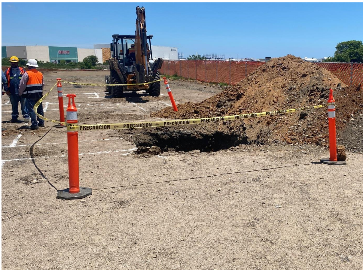
Figura 15 Inspección de excavaciones
