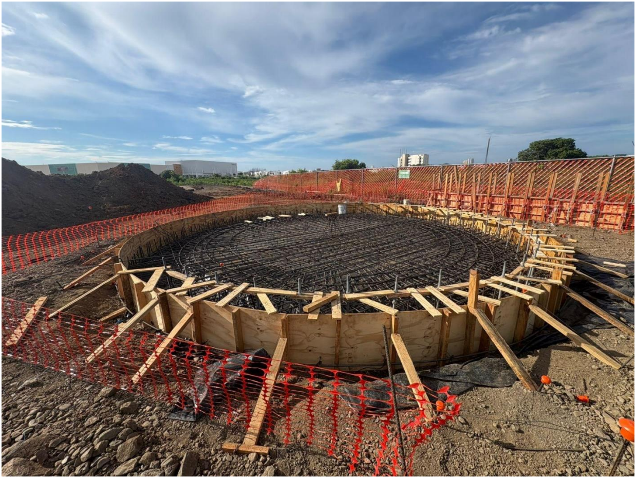
Figura 32 Creación de cisterna
