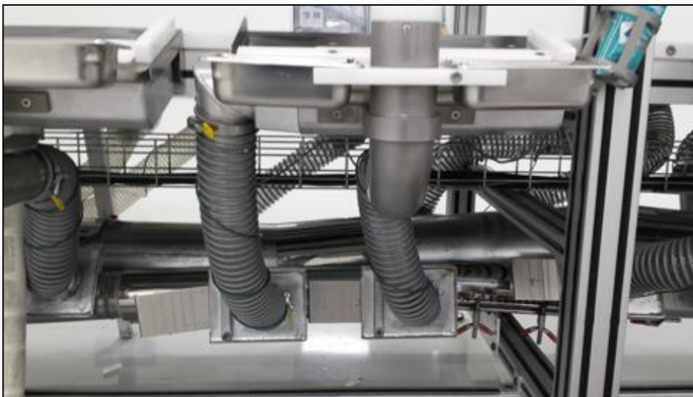
Figura 6. Instalación de tubería flexible.
