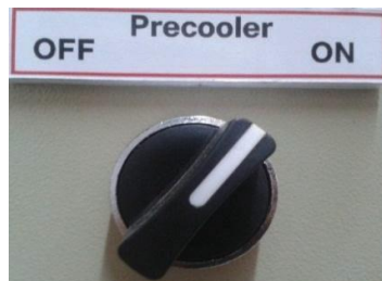
Figura 2.22 Selector de dos posiciones
