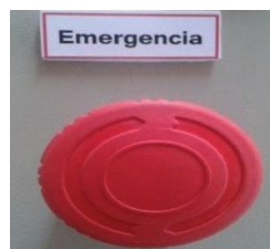
Figura 2.23 Pulsador de emergencia
