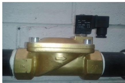
Figura 2.18 Electroválvula de desfogue
