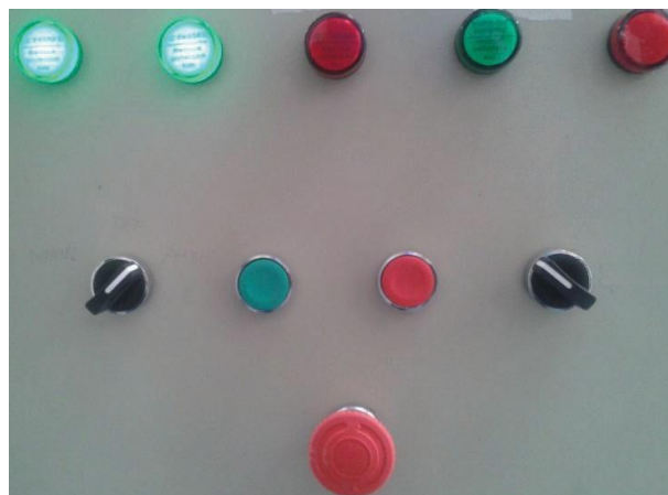
Figura 2.30 Distribución de elementos al exterior del tablero
