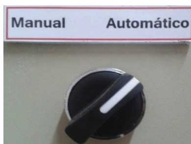
Figura 2.21 Selector de tres posiciones
