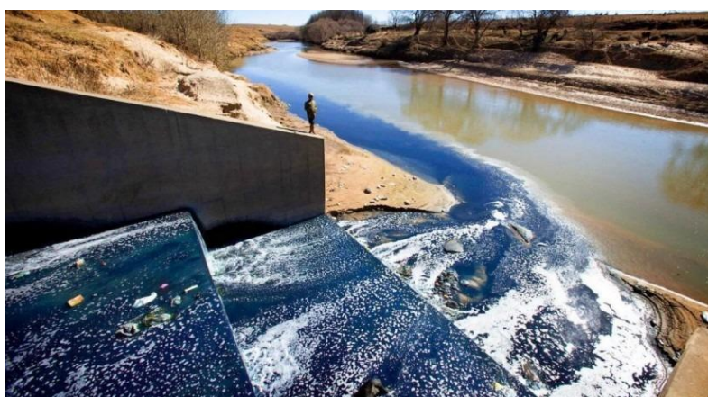
Figura 3 Descarga de aguas residuales textiles a un río
