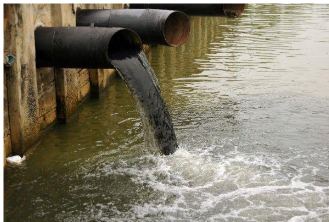
Figura 2 Descarga de aguas residuales
