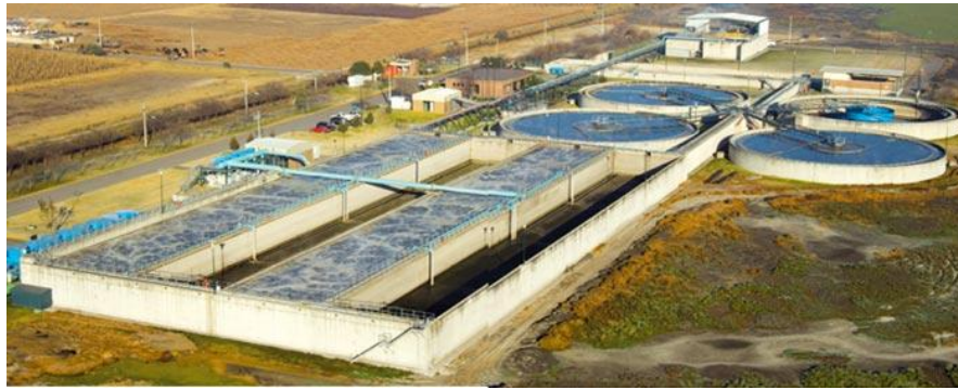
Figura 4 Planta de tratamiento de agua residual de Tejupilco
