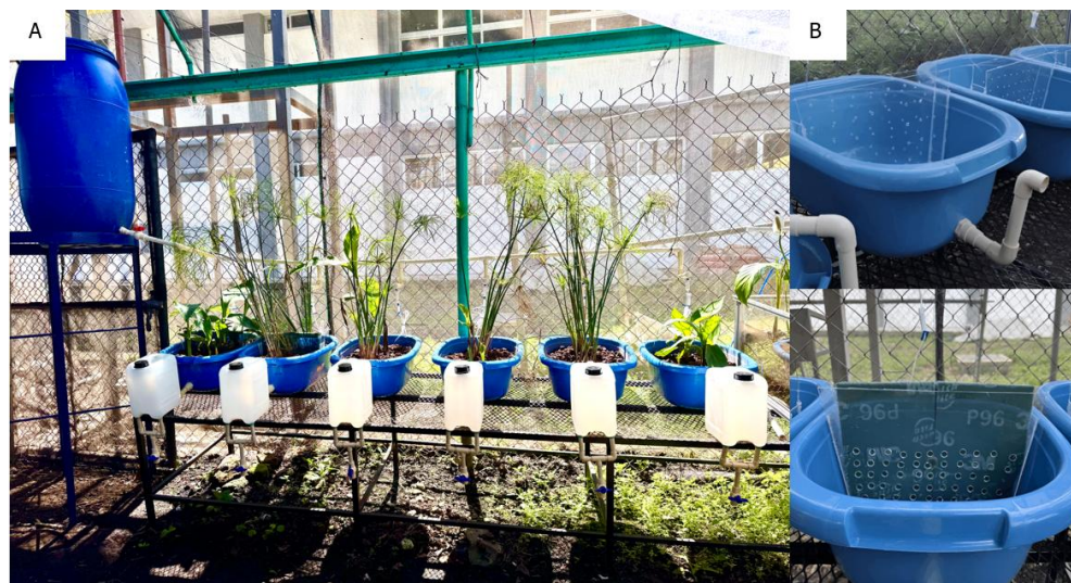
Figura 3.5 Celdas de humedales construidos y soporte para biopelícula.
