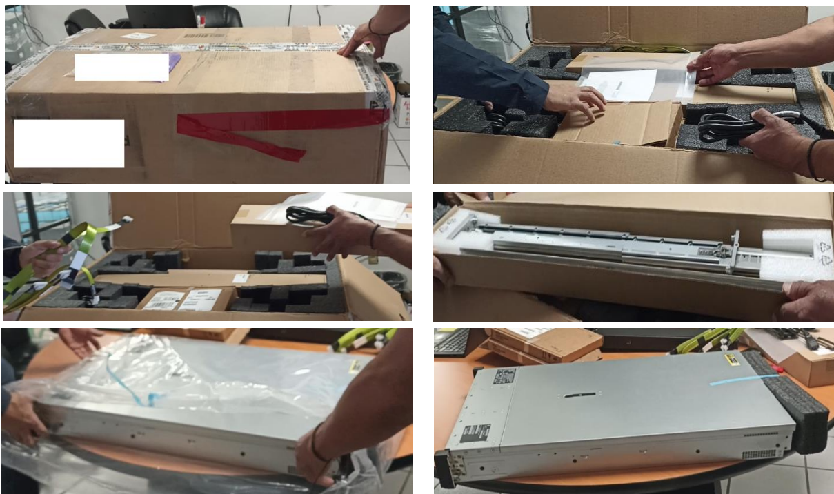
Ilustración 60 Desempaquetado y revisión del estado de servidores
