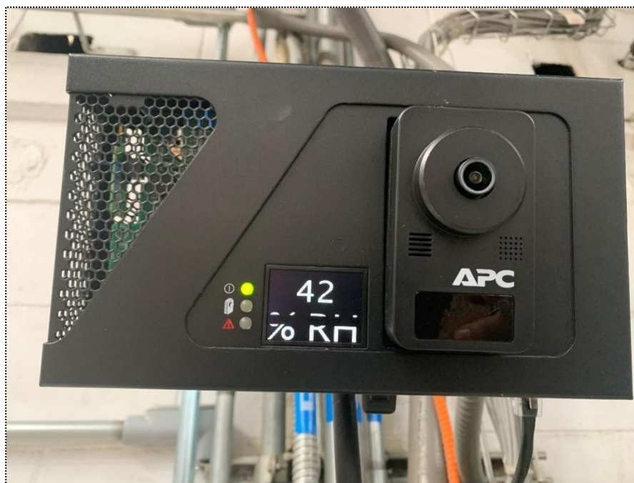
Figura 50 Verificación funcional del NetBotz 755.
