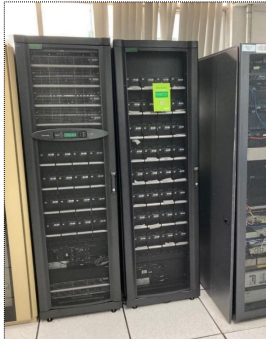
Figura 35 Implementación almacén de batería de 8 módulos PX 40KW.
