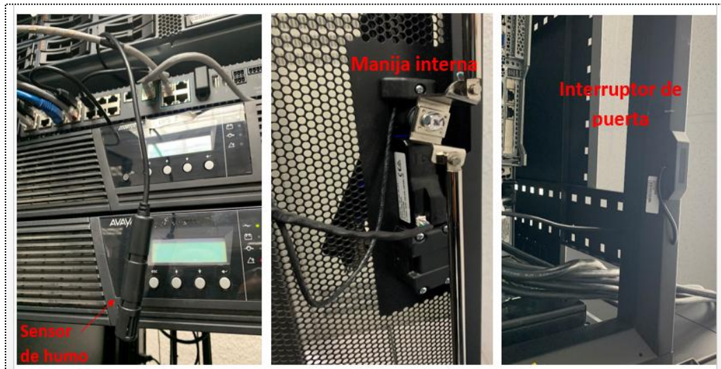
Figura 31 Instalación de sensor de humo, manija interna, e interruptor de puerta.
