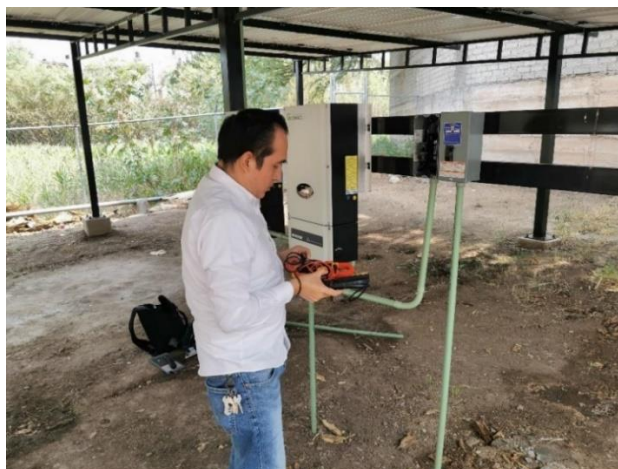
Ilustración 4 "Personal Del Área De Ingeniería Configurando Un Inversor"
