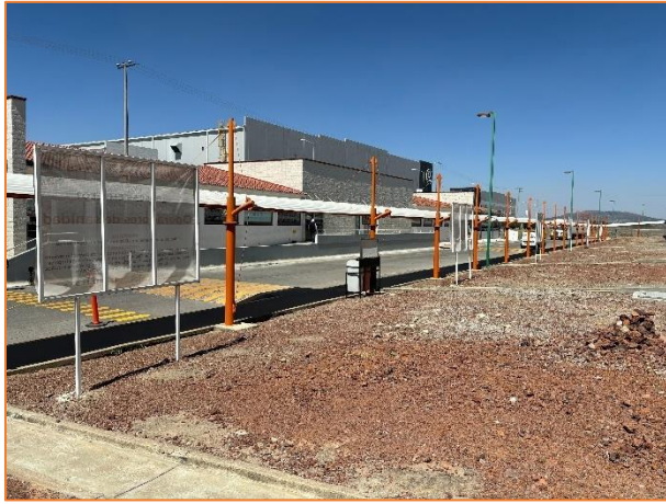
Ilustración 18. Estructuras metálicas frente a comedor
