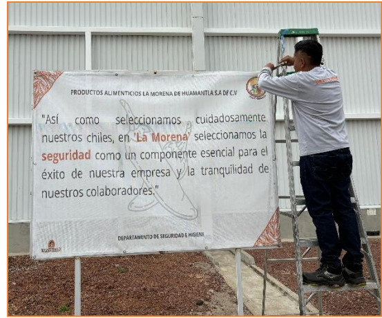
Ilustración 19. Colocación de lonas en estructuras metálicas
