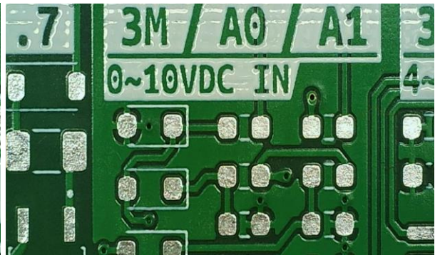
Figura 3.5.7: inspección de entradas 0~10V.
