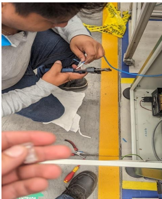
Ilustración 40 Instalacion del conector RJ45
