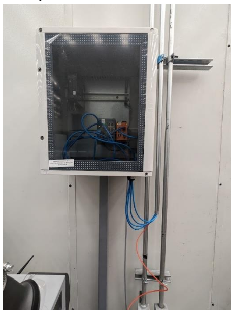
Ilustración 30 Switch Principal
