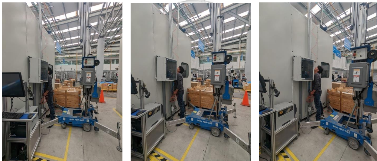
Ilustración 38 Instalación de cableado ethernet
