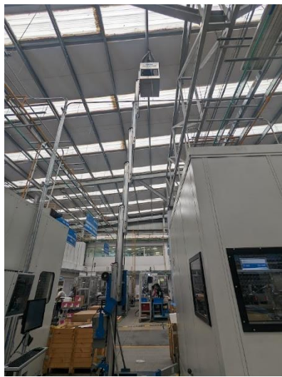
Ilustración 35 Instalación de tubo usando peras y que se muestran en el listado de materiales a utilizar
