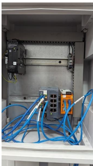
Ilustración 76 Switch Principal
