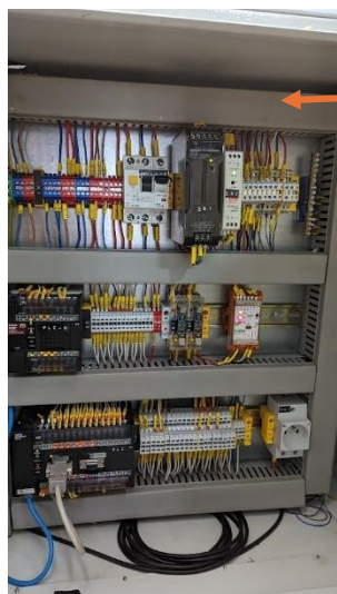
Ilustración 70 Conexión del Gabinete Motor HVAC A
