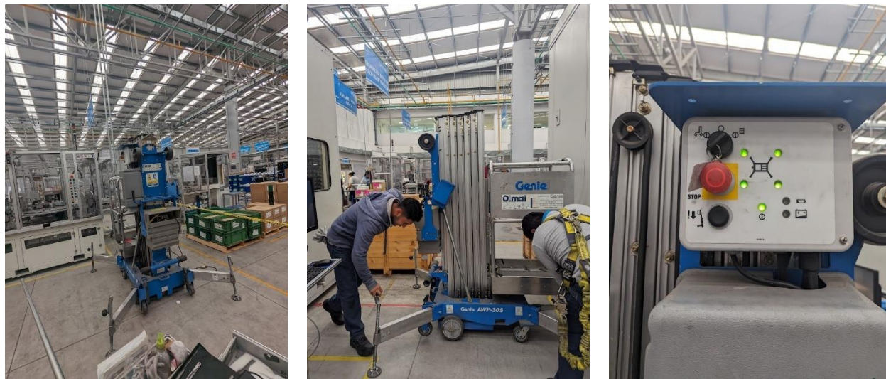
Ilustración 33 Genie: Equipo que se utilizó para los trabajos en altura
