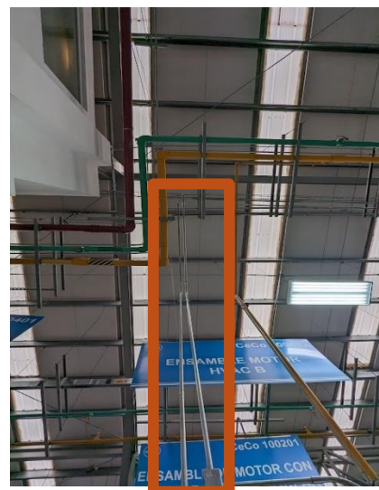
Ilustración 72 Tubería para la conexión Ethernet Motor Hvac A y B
