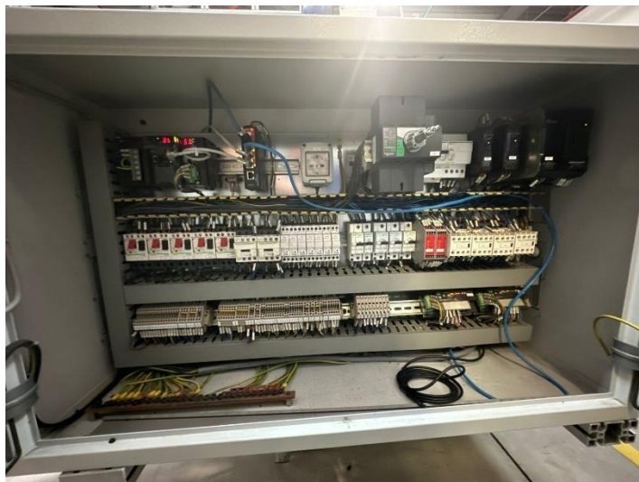
Ilustración 65 Conexión del Gabinete HVAC A
