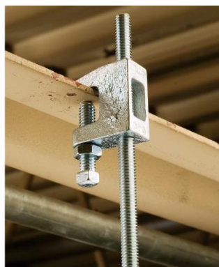
Ilustración 36 Mordaza de acero y colgador tipo pera
