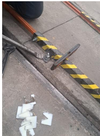
Figura 14: Nivelación de los rieles
