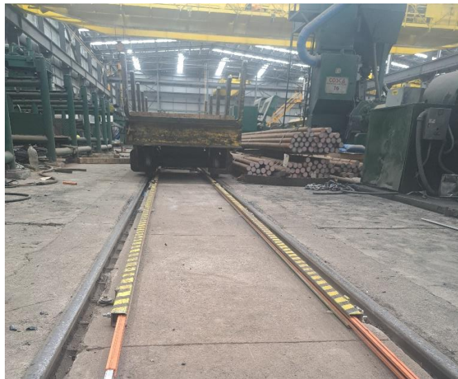
Figura 22: Prueba de funcionamiento del Transfer de carga No. 2
