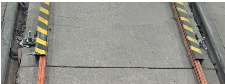
Figura 11: Montaje de los rieles conductores a los rieles cuadrados
