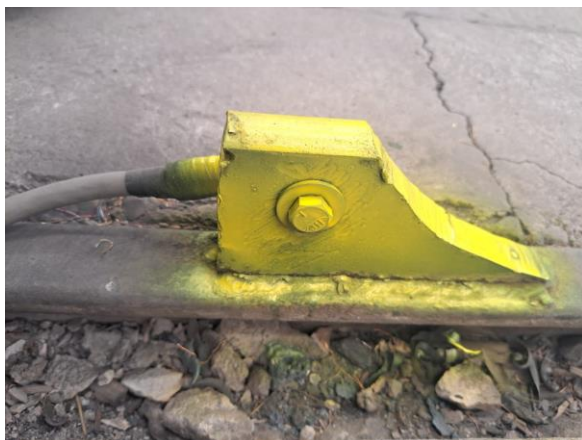
Figura 20: Conexión a tierra a los topes
