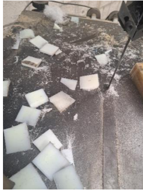
Figura 9: Espaciadores para nivelación
