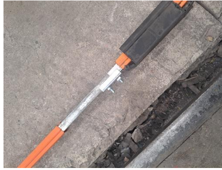
Figura 13: Conexión de los rieles conductores
