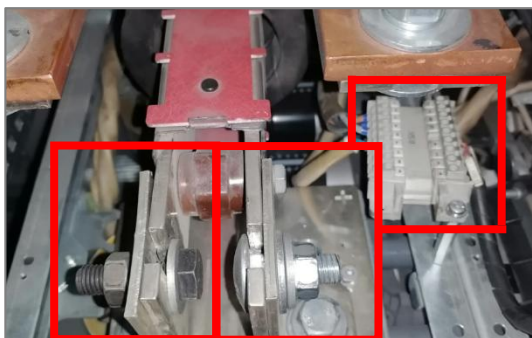
Imagen 14.30 Conectores X50 Y Zapatas.
