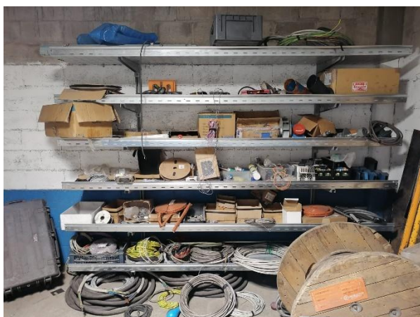
Imagen 13.12 Condiciones Iniciales "Almacén De Refacciones" Vista Lateral.
