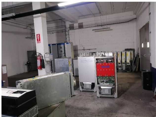
Imagen 13.14 Condiciones Iniciales 'Área De Mantenimiento De Módulos Inversores" Vista Frontal.
