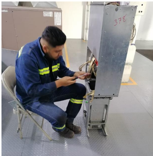
Imagen 13.49 Comienzo De Actividades De Mantenimiento Correctivo.
