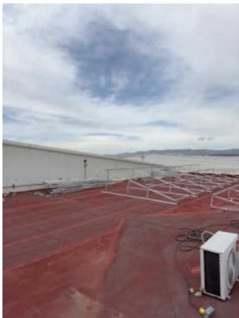
Ilustración 8. Fijación de bases.
