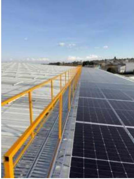
Ilustración 14. Instalación completa de paso de gato
