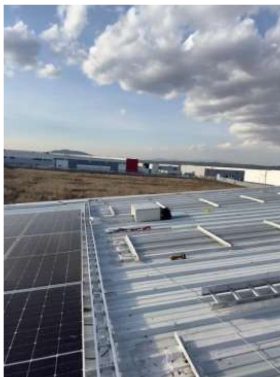
Ilustración 12. Continuación de fijación de módulos fotovoltaicos.
