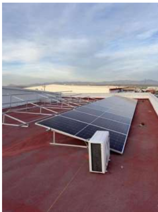
Ilustración 9. Montaje de los primeros módulos.
