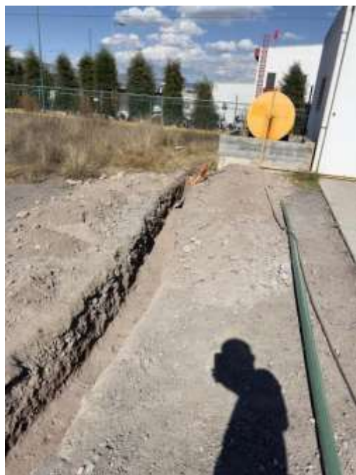
Ilustración 18. Continuación de rascado para cableado subterránea
