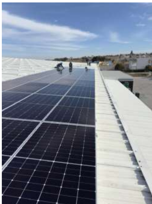
Ilustración 12. Continuación de fijación de módulos fotovoltaicos.
