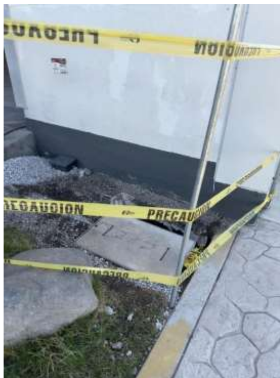
Ilustración 20 Se introducen cables a registro de bajada hacia la subestación
