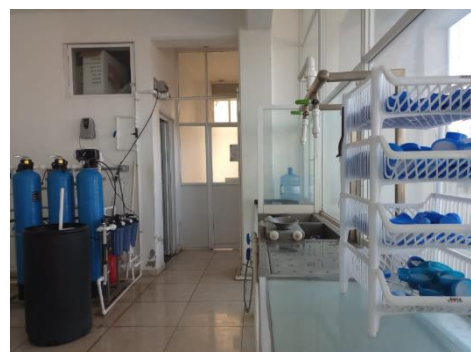
FIGURA 1.1 INTERIOR DE LA PLANTA [FUENTE: PROPIA 2023]
