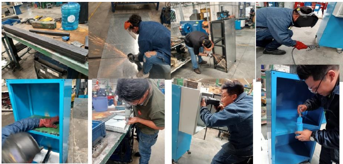
Figura 3.34 Armado de la estructura.
