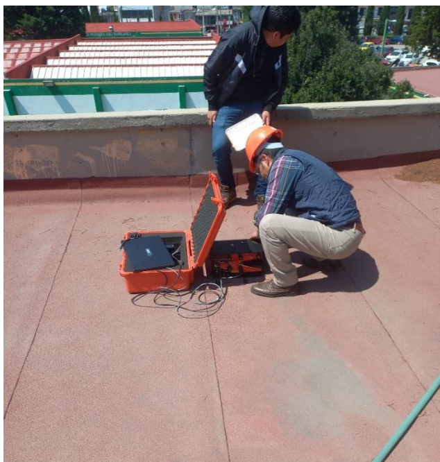
Imagen 71. Toma de muestras en azotea
