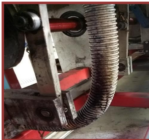
Imagen 1.68 Tubos de Liquid Tight. [Fuente: IEA 2019]
