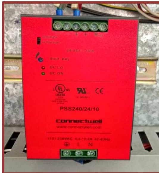
Imagen 1.87 Fuente de Alimentación nueva 115/220v a 24 VCD. [Fuente: IEA 2019]
