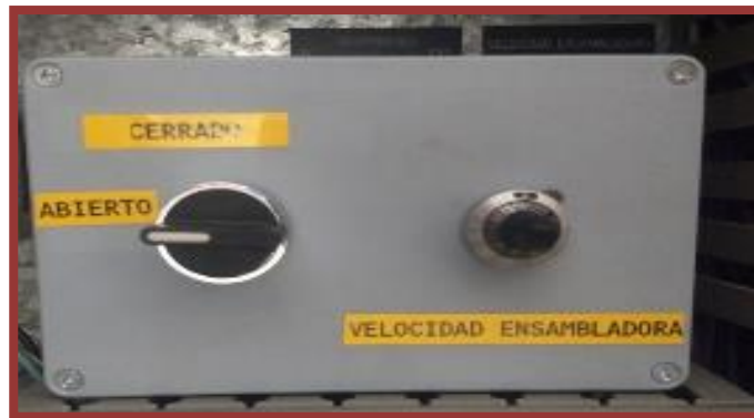
Imagen 1.91. Caja fabricada para Selector y potenciómetro [Fuente: IEA 2019]
