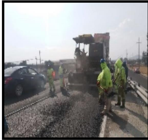
Ilustración 7 Tendido de carpeta asfáltica
