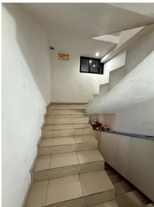
Ilustración 10. Escalera tramo entrepiso
