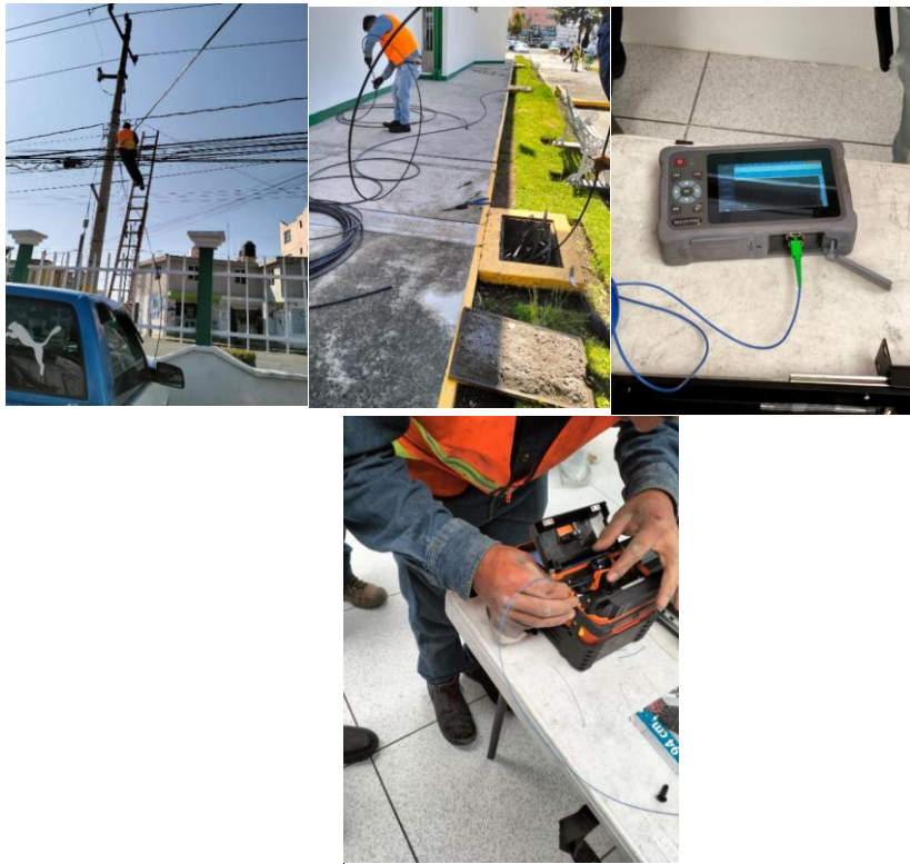
Figura 13.1 Supervisión del tendido y fusión de fibra óptica hacia el Edificio R (MDF)
