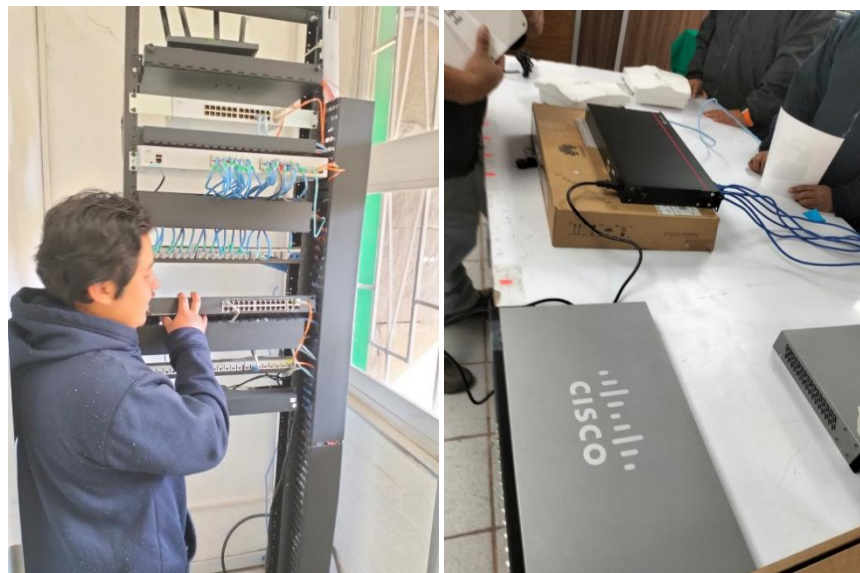
Figura 16.1 – Sustitución de equipos de red en mal estado
