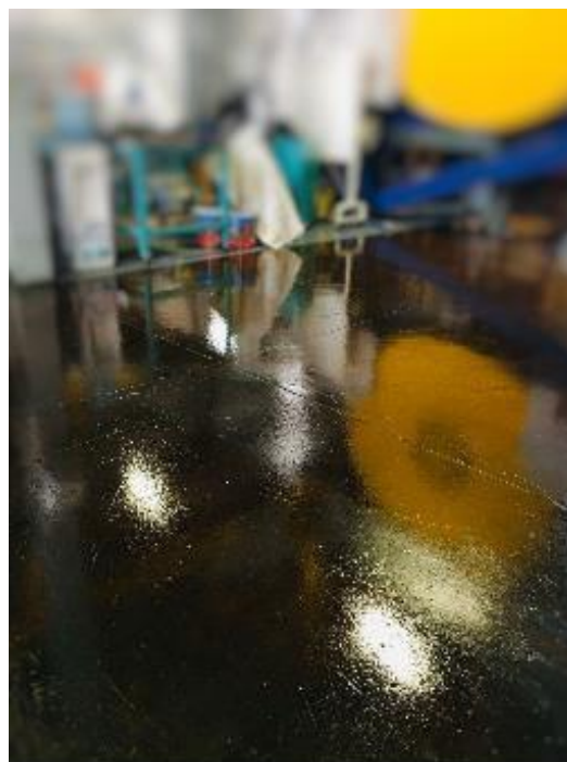
Ilustración 87. Después de la limpieza.
