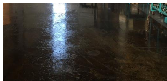
Ilustración 79. Después de la limpieza de piso.
