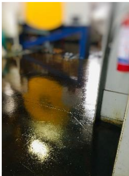
Ilustración 91. Después de la limpieza.
