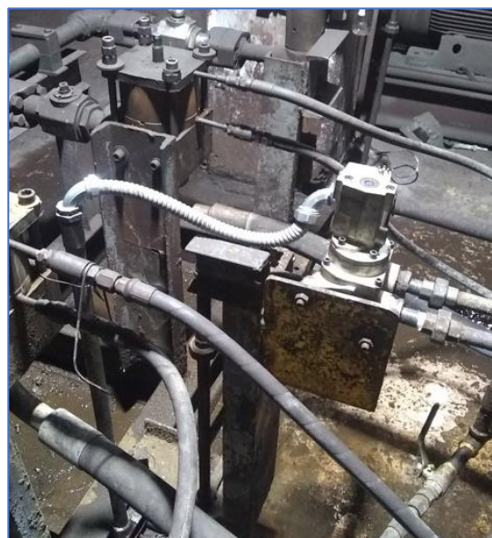
Ilustración 3.13: válvula electroneumática 3/2, fuente propia. [fotografía]
