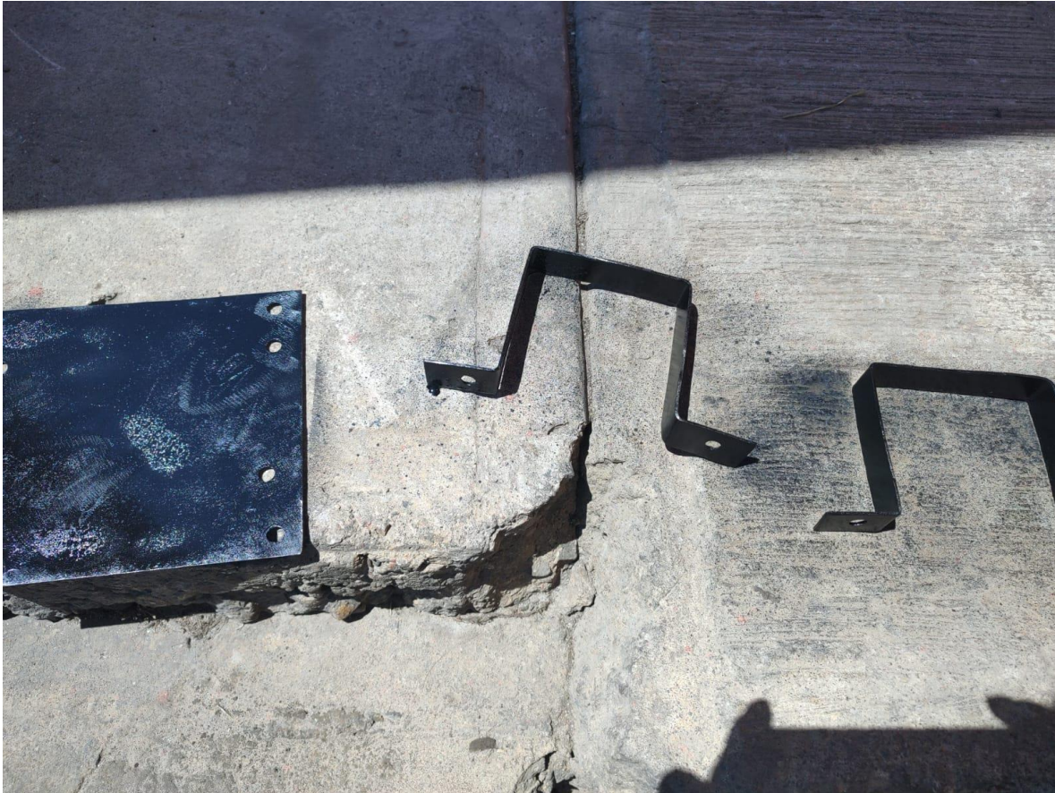
Fig.4.5.13 base y ganchos para la base y sostenimiento del motor trifásico
