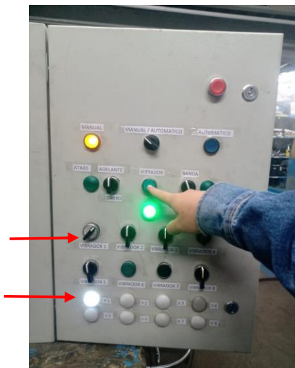
Figura 14.2.5. Pruebas de funcionamiento de tablero – modo manual.
