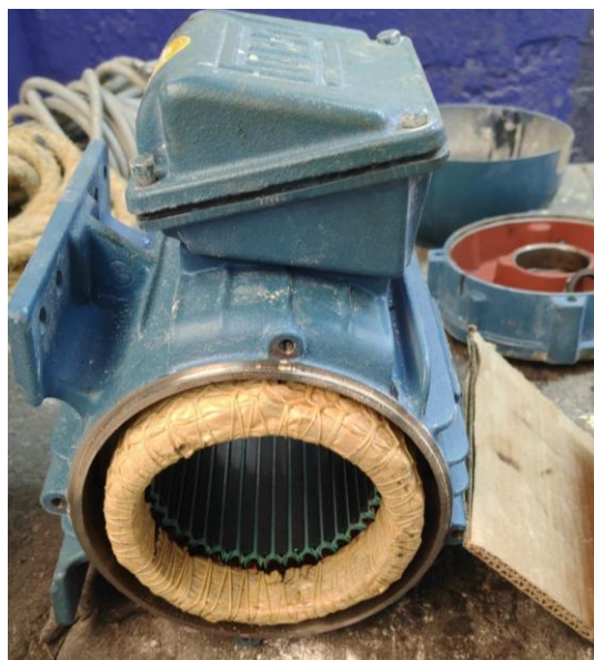
Ilustración 36: Mantenimiento al motor del barredor
