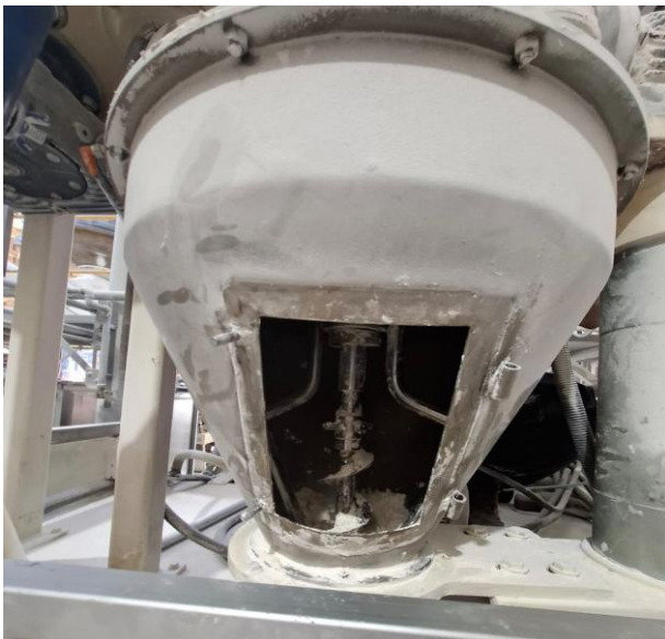
Ilustración 35: Mantenimiento a tolva de dosificación del barredor
