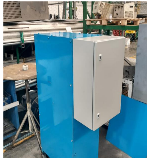
Ilustración 35.- Estructura exterior final del termorregulador
