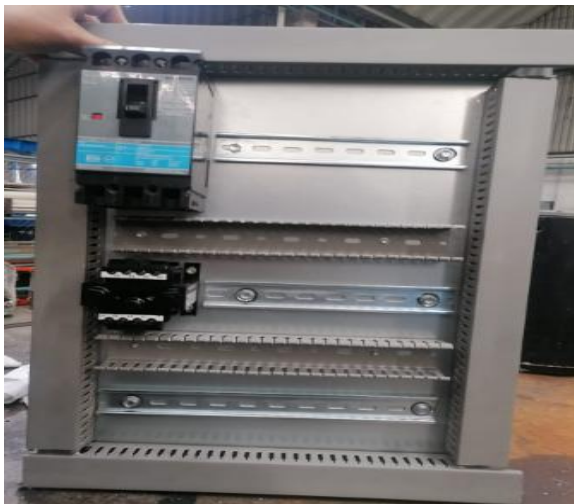
Ilustración 38.- Instalación de componentes eléctricos en gabinete
