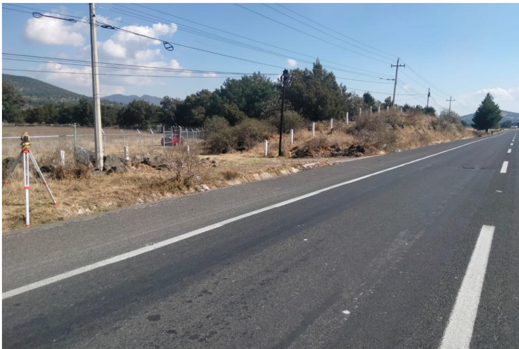
Imagen 1. Inicio de trabajos topográficos para carril de aceleración y desaceleración para el acceso al centro de distribución “El Ranchero”.
