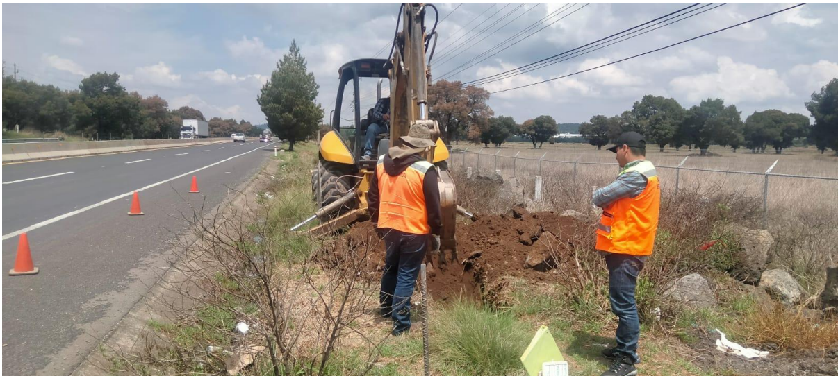
Imagen 5. Obtención de muestras en pozo a cielo abierto
