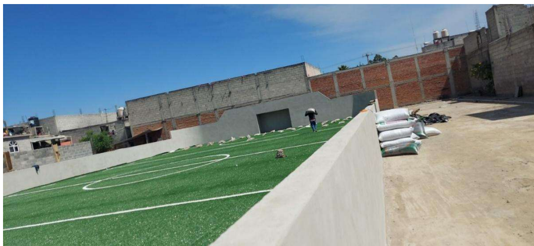
Figura 59. Colocación de caucho y arena
