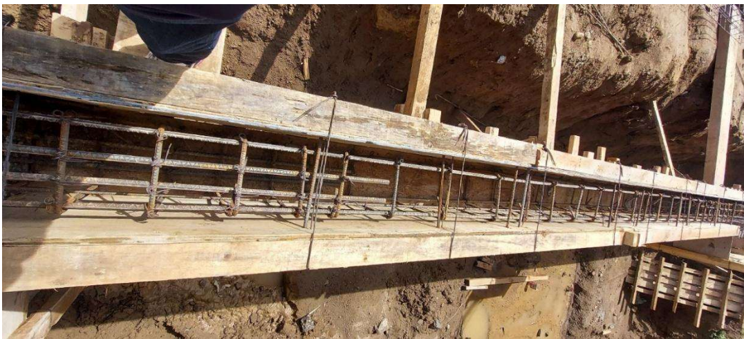
Figura 116. Colocación y colado de la contratrabe
