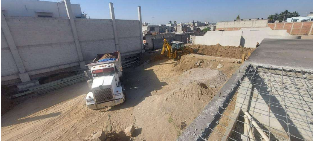
Figura 80. Retiro de material producto de la excavación para cisterna
