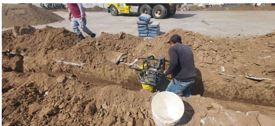
Figura 48. Compactación con bailarina compactadora
