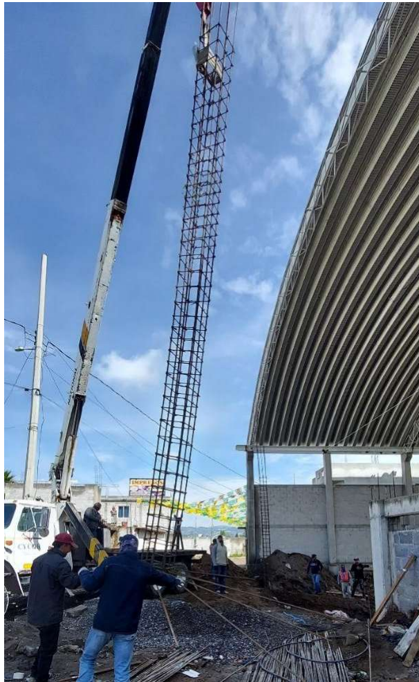
Figura 111. Maniobra de colocación de columnas para techumbre
