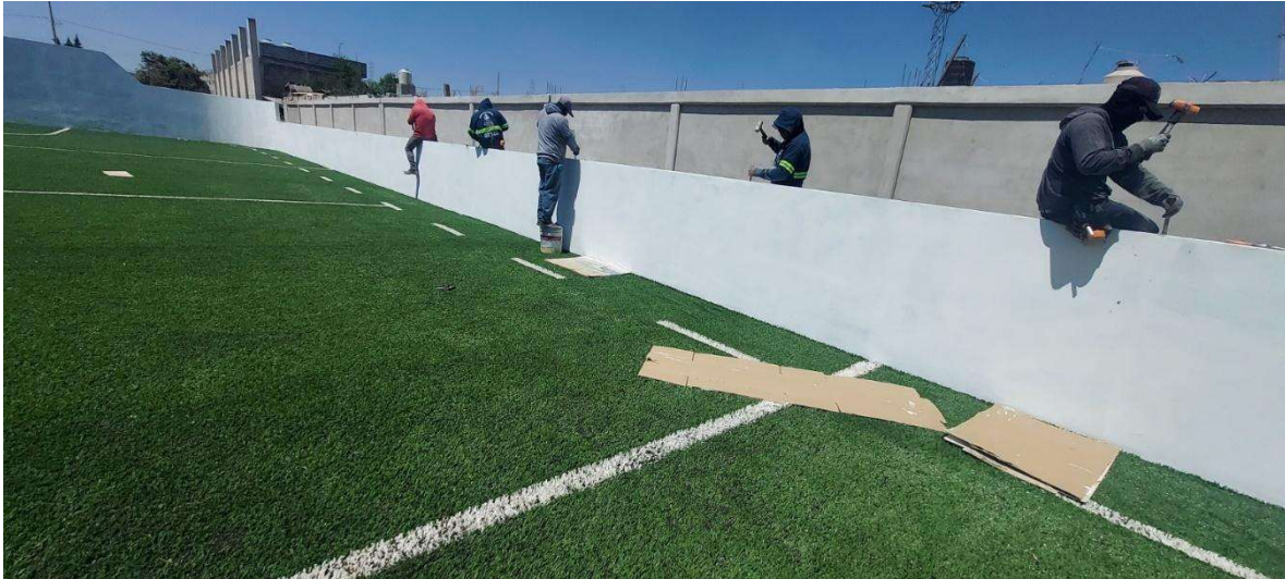
Figura 62. Instalación de malla ciclónica en cancha
