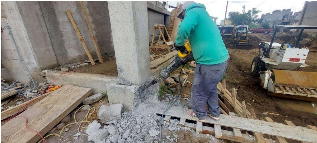
Figura 115. Demolición de concreto de la columna
