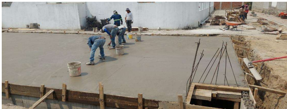
Figura 96. Pulido de losa de concreto para cisterna
