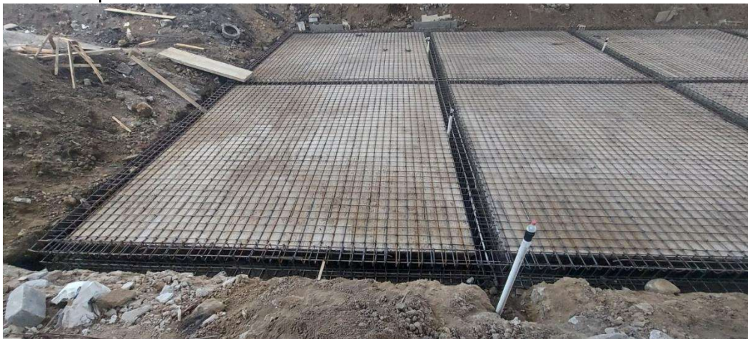
Figura 131. Colocación de tubería dentro de la losa de cimentación
