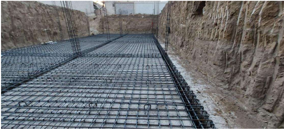
Figura 84. Armado de losa de cimentación y anclaje de columnas para cisterna
