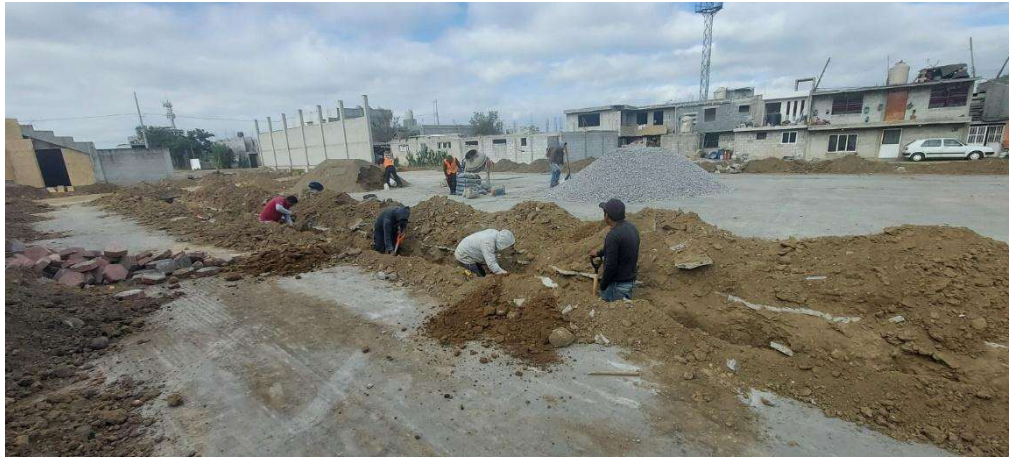
Figura 50. Colado de plantilla de concreto para cancha de futbol 7
