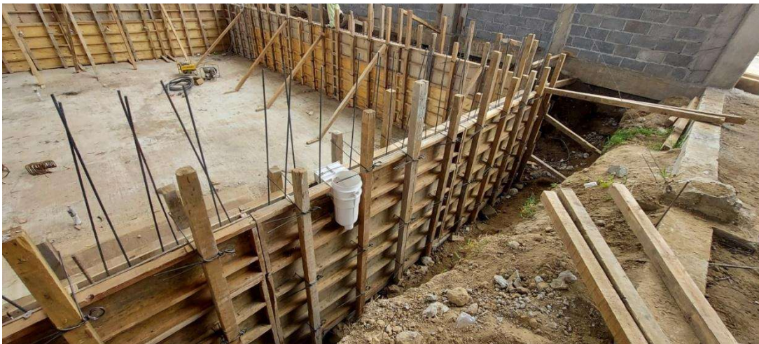
Figura 140. Verificación de colocación de cimbra para muros de alberca
