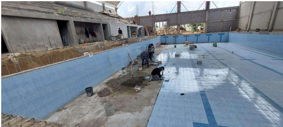
Figura 148. Pegado de azulejo en el firme de alberca
