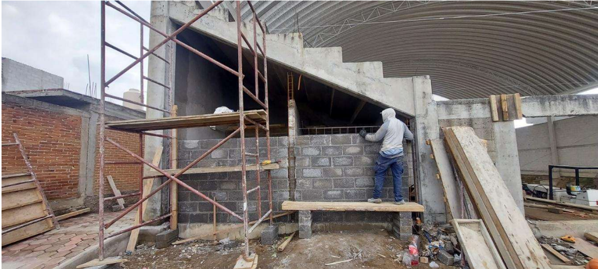
Figura 122. Muros perimetrales de la techumbre
