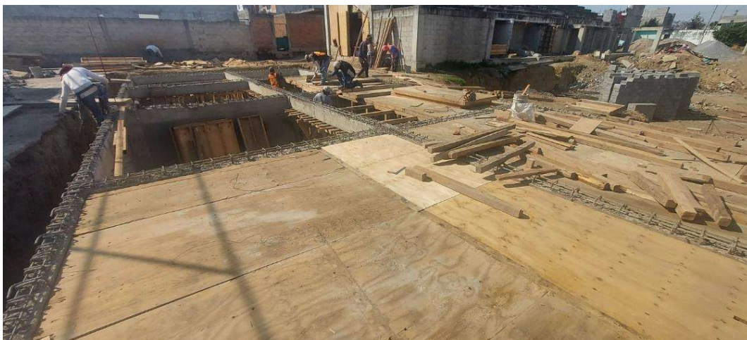
Figura 92. Cimbrado con triplay de losa de concreto para cisterna
