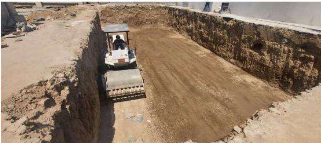
Figura 79. Compactación de suelo de cisterna
