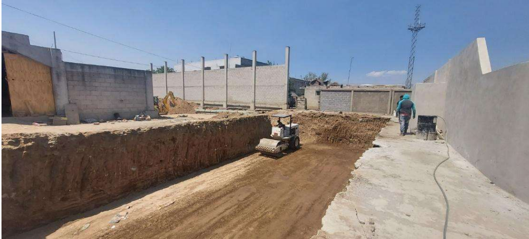
Figura 78. Rampa de acceso para vibro compactador
