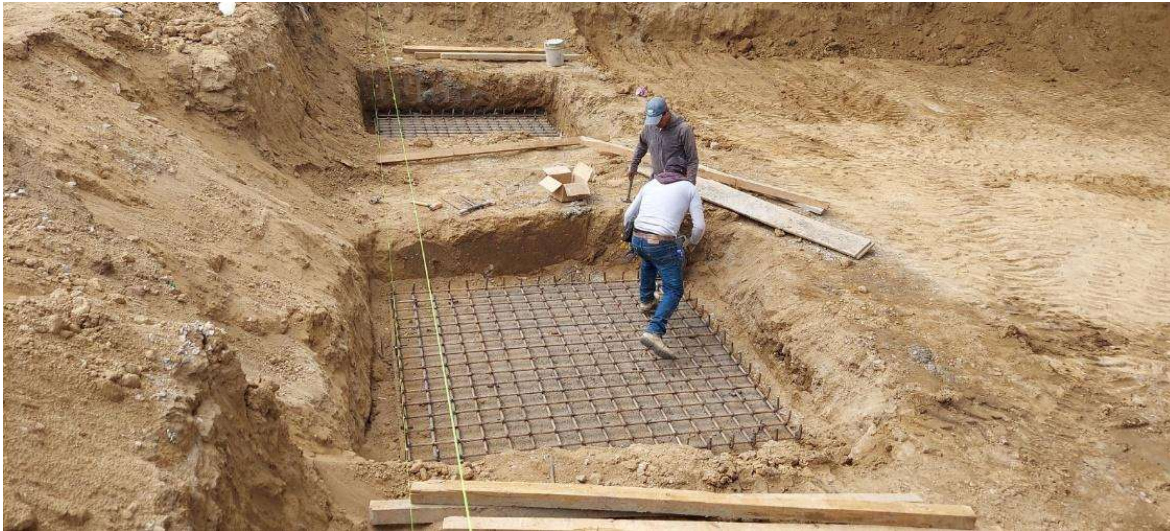
Figura 109. Armado de zapatas para techumbre
