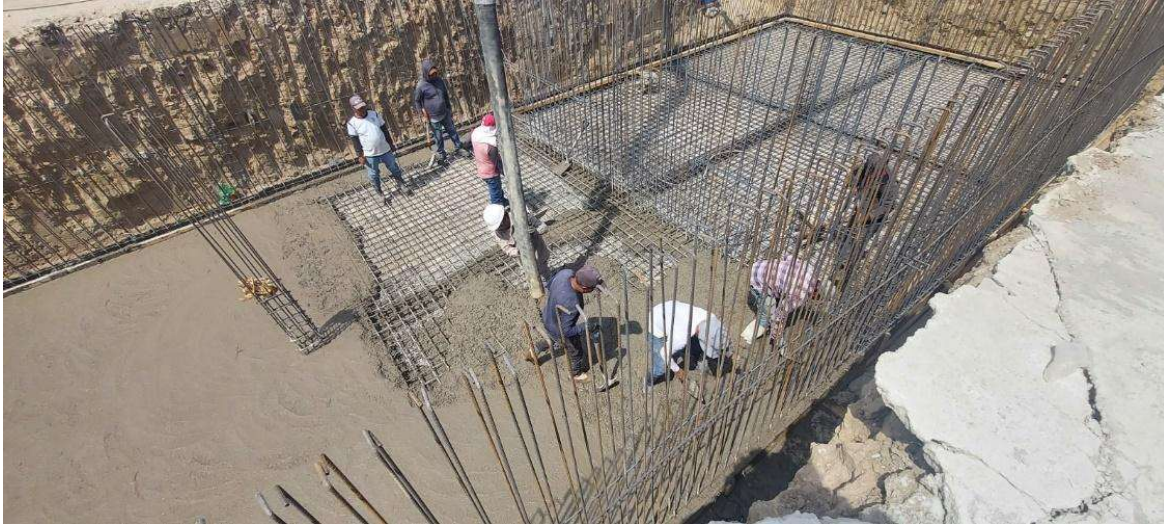
Figura 85. Colado de losa de cimentación para cisterna
