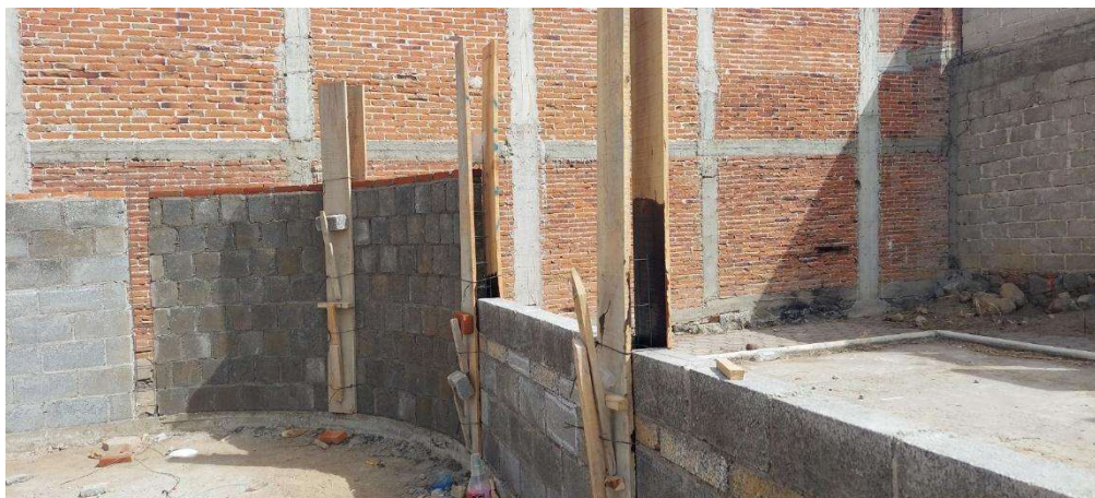
Figura 53. Muros de block
