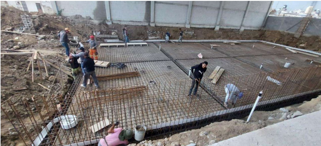
Figura 134. Anclaje de muro a losa de cimentación
