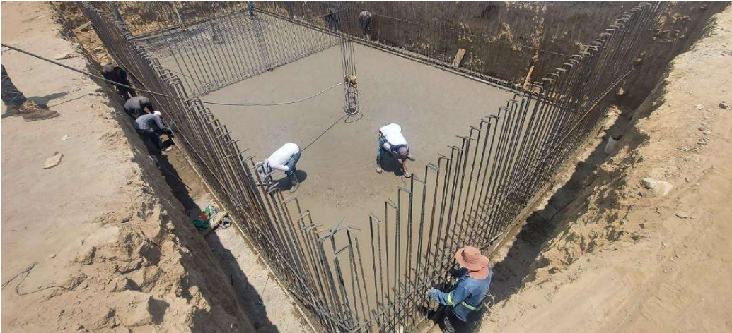
Figura 86. Pulido de losa de cimentación para cisterna
