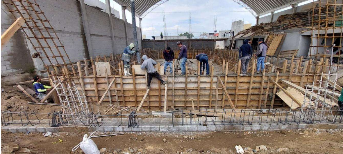
Figura 141. Colado de muros de alberca con pluma
