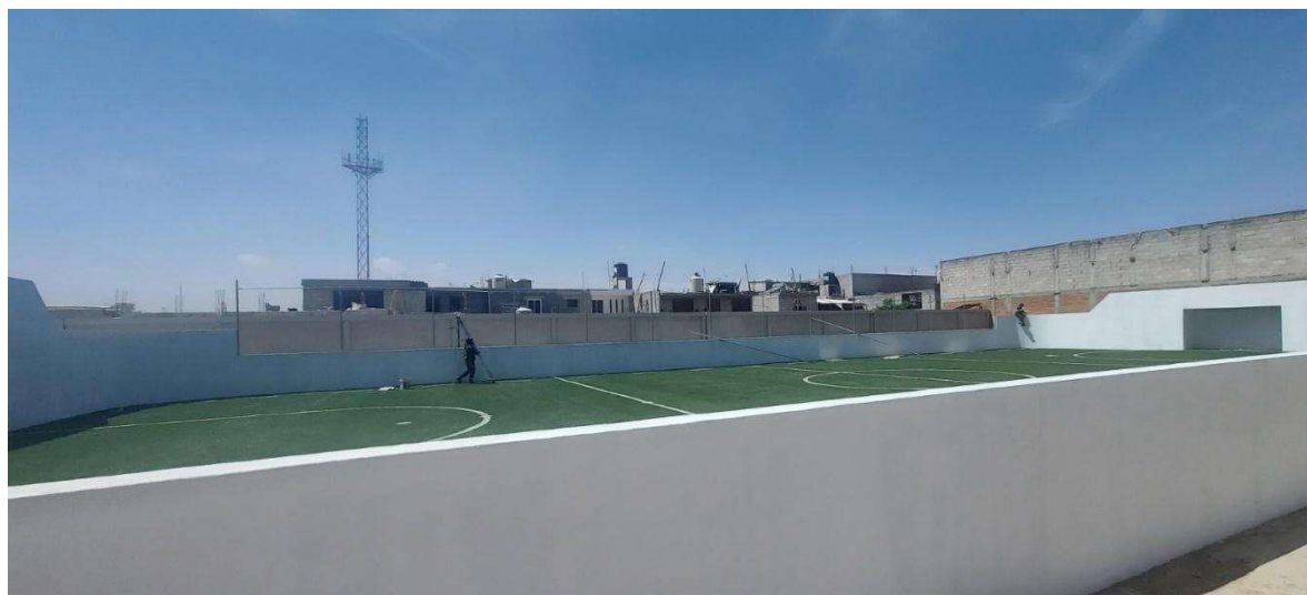
Figura 61. Anclaje de postes para malla ciclónica en cancha
