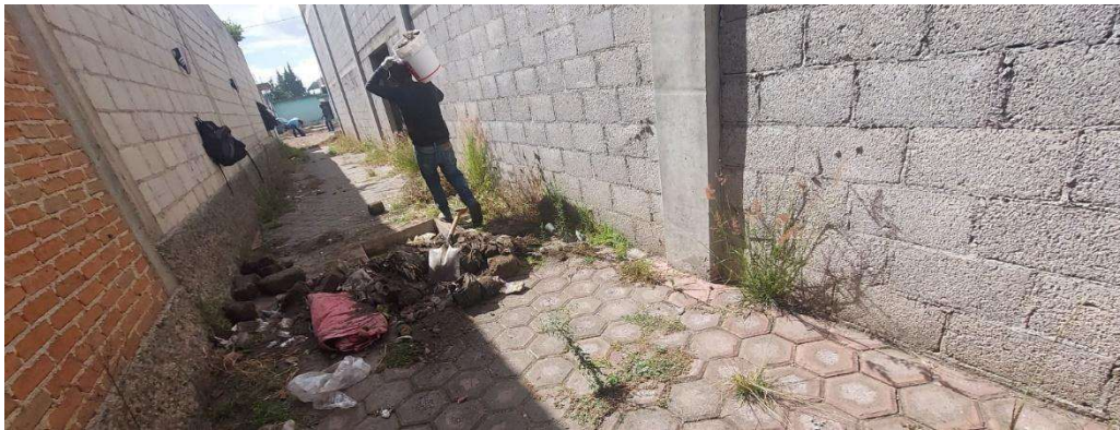
Figura 41. Limpieza inicial de la obra
