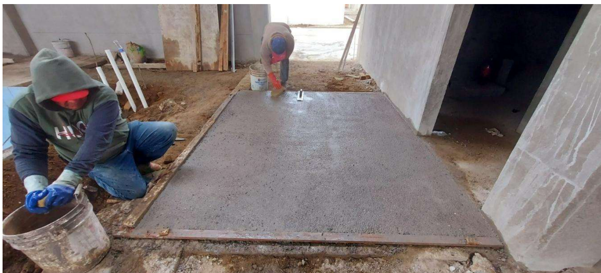
Figura 154. Acabado en andadores de alberca
