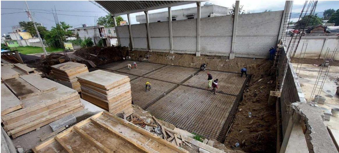
Figura 130. Armado de losa de cimentación
