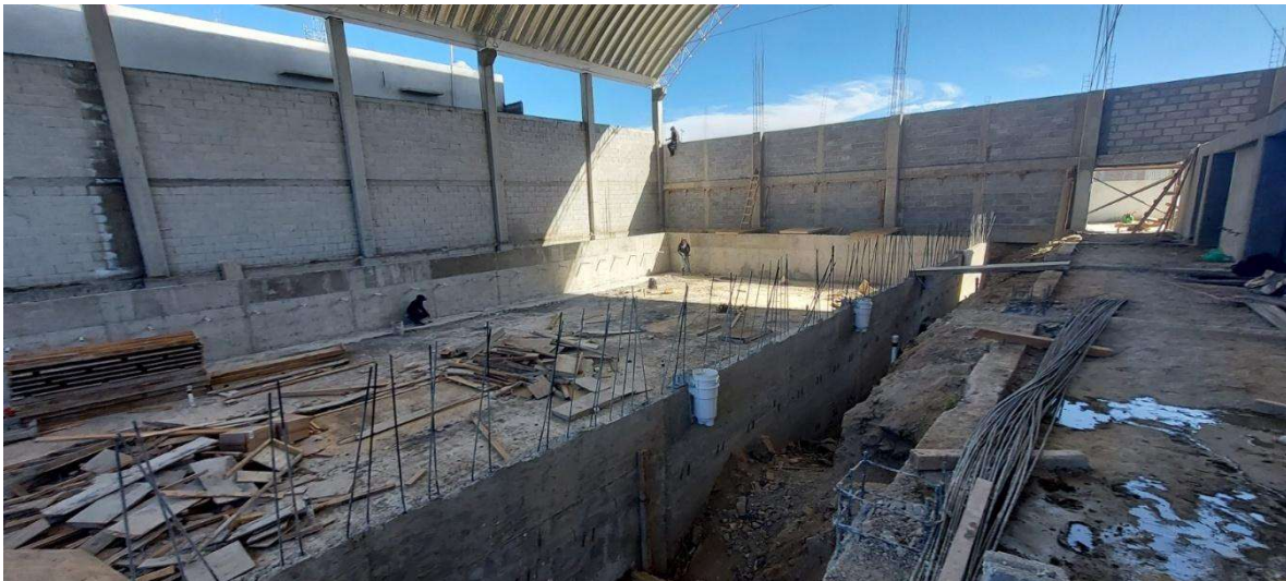
Figura 142. Descimbrado de muros de alberca
