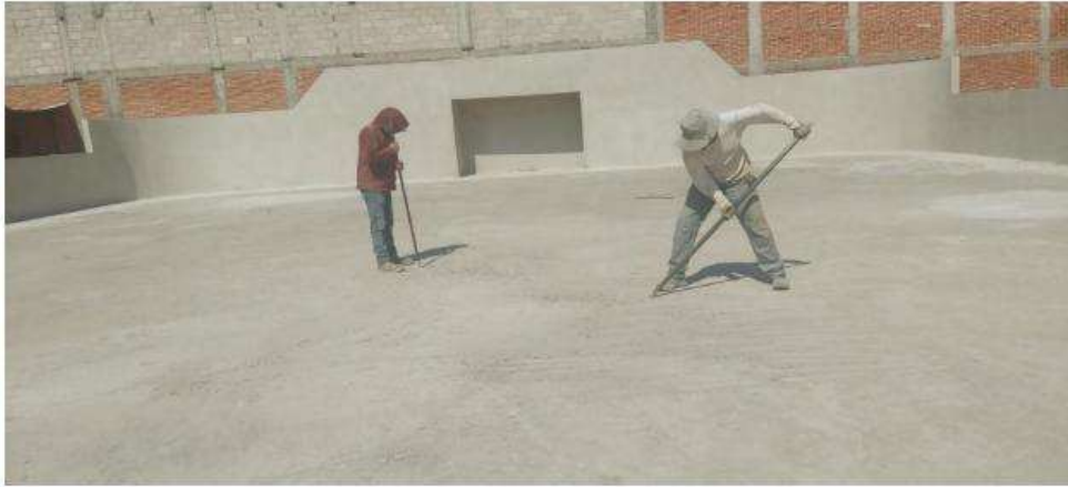
Figura 57. Afine de la superficie del firme de concreto
