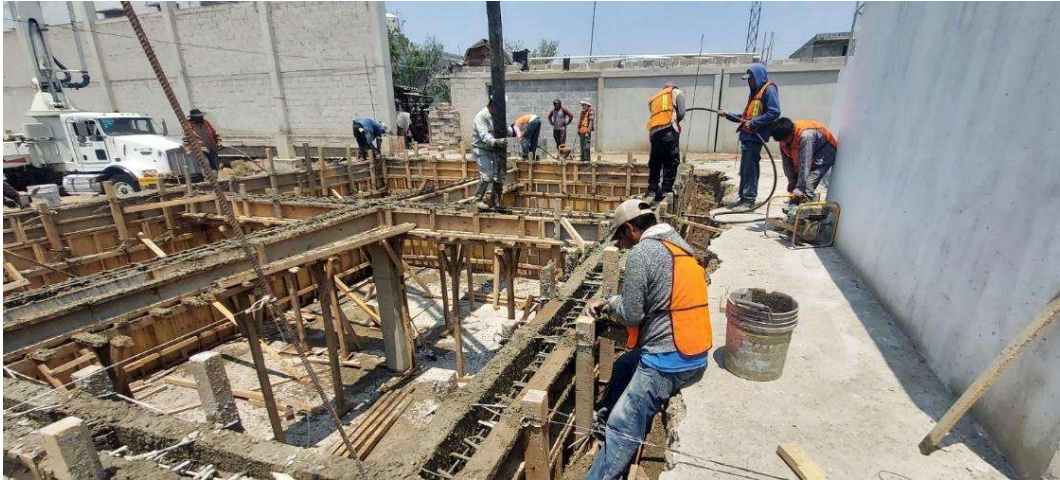
Figura 88. Colado de muros de contención y trabes para cisterna
