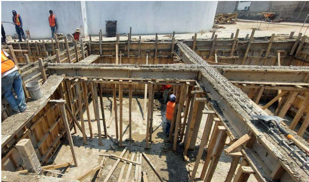
Figura 87. Cimbrado de muros de contención y trabes para cisterna
