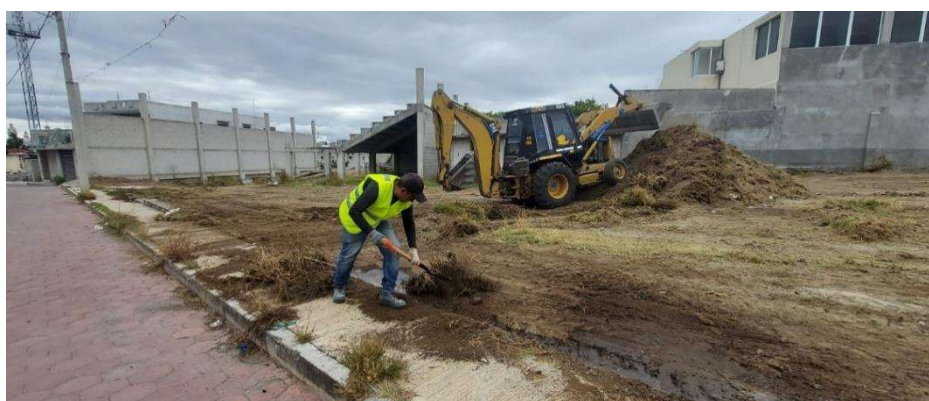
Figura 106. Nivelación del terreno para techumbre
