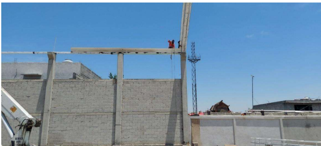
Figura 118. Colocación de vigas ancladas a columnas
