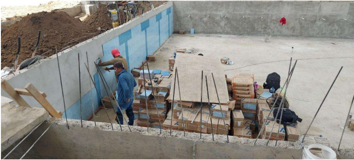
Figura 146. Pegado de azulejo en muros de alberca
