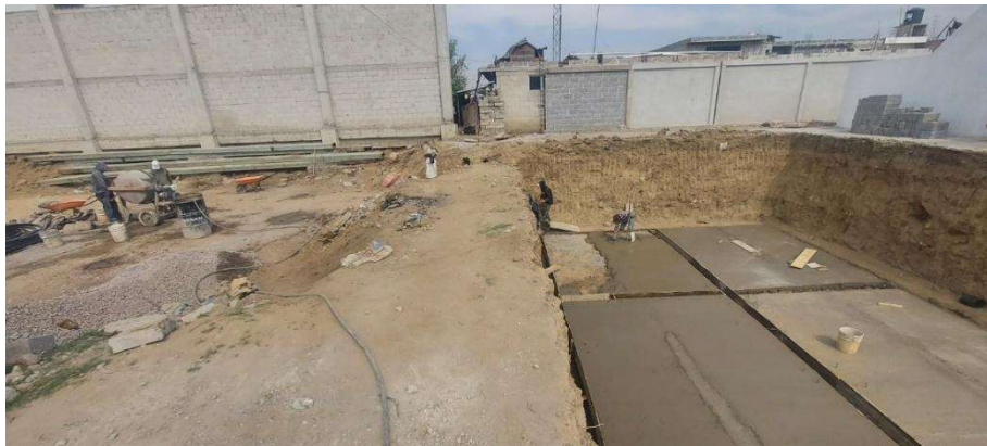
Figura 81. Colado de plantilla de concreto para cisterna
