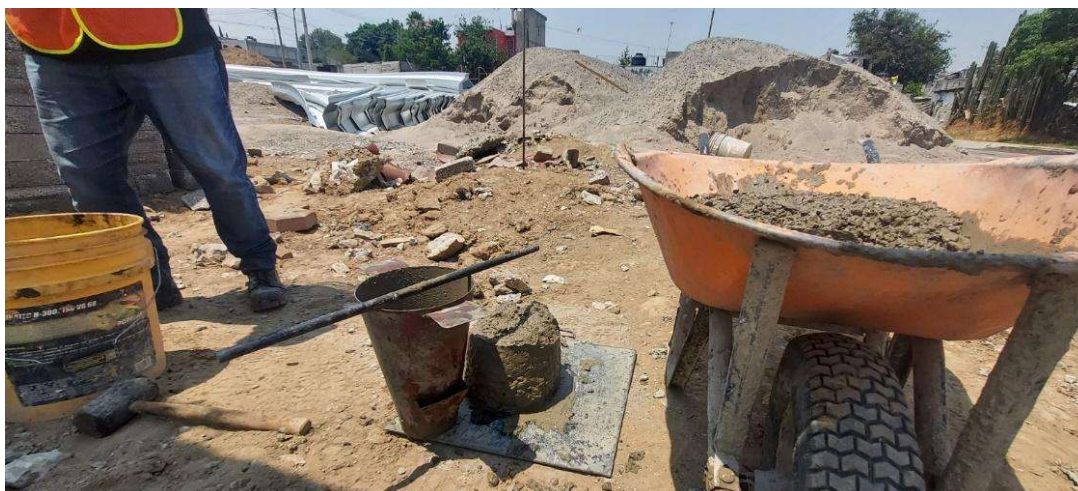
Figura 89. Prueba de revenimiento de concreto
