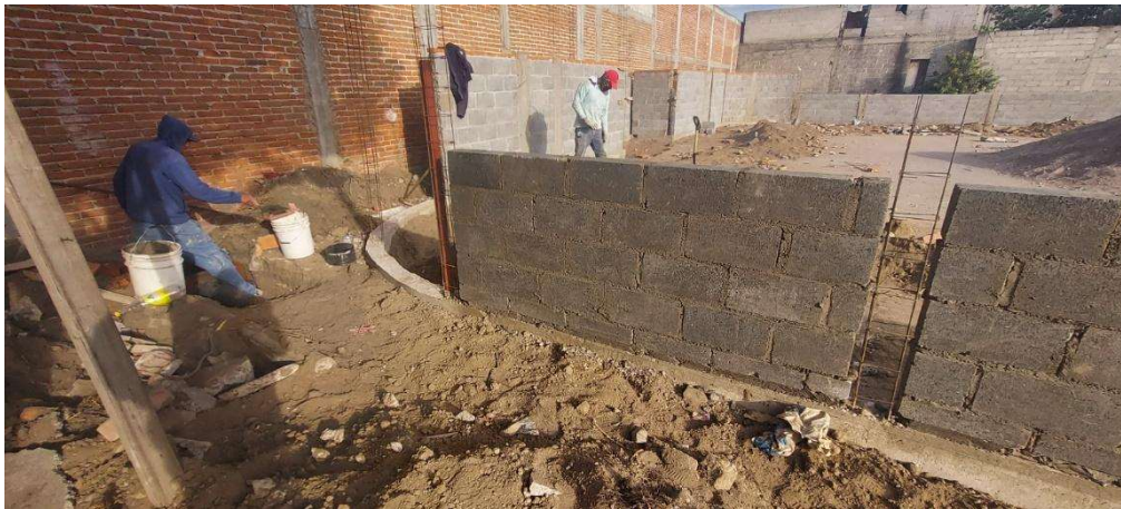
Figura 54. Colado de castillos en cancha de futbol 7
