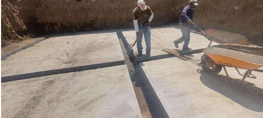
Figura 82. Colado de plantilla de concreto para trabes de cisterna
