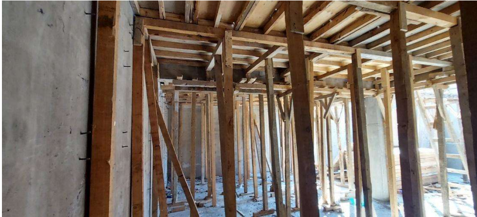
Figura 91. Cimbrado con polines y largueros de losa de concreto para cisterna
