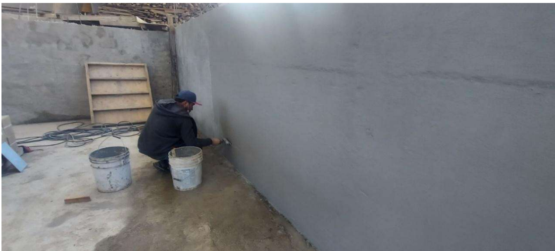
Figura 144. Impermeabilización de muros de alberca
