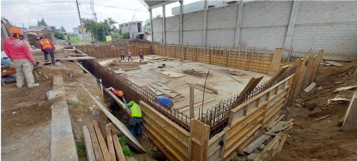
Figura 139. Cimbrado de muros de alberca
