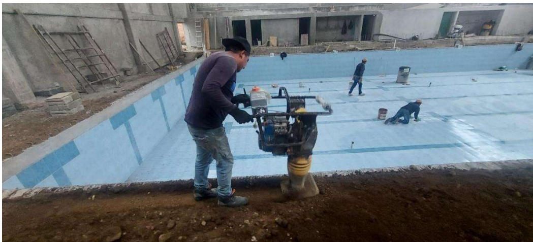
Figura 152. Compactación para andadores de alberca
