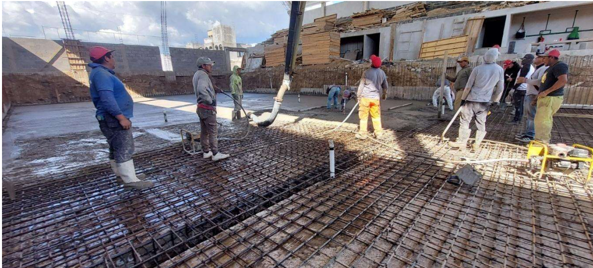
Figura 135. Colado de losa de cimentación
