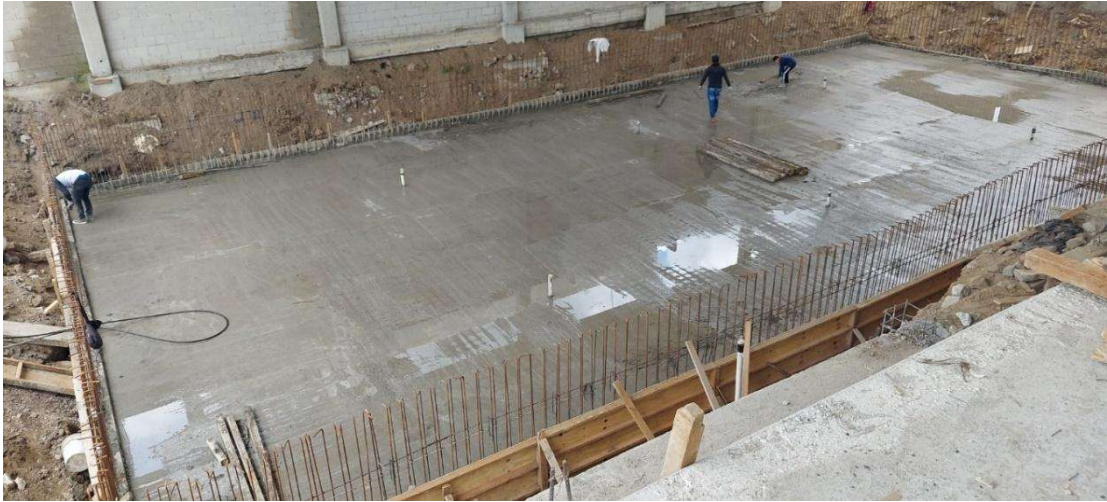
Figura 137. Fraguado del concreto
