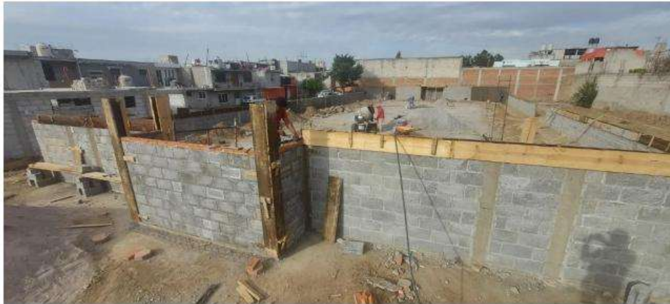
Figura 55. Colado de cadenas de cerramiento para cancha de futbol 7
