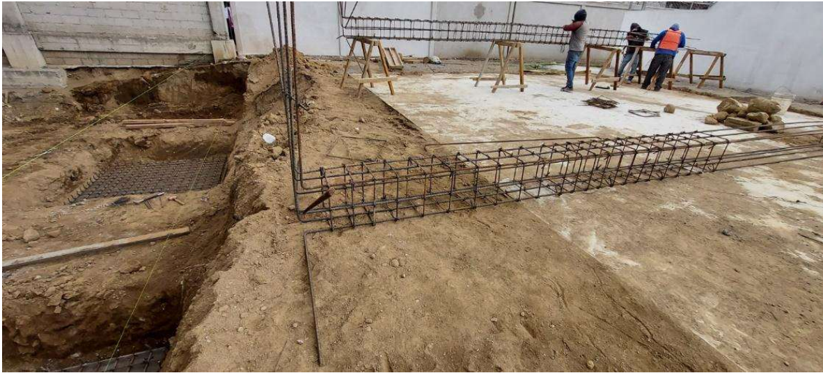
Figura 110. Armado de columnas para techumbre
