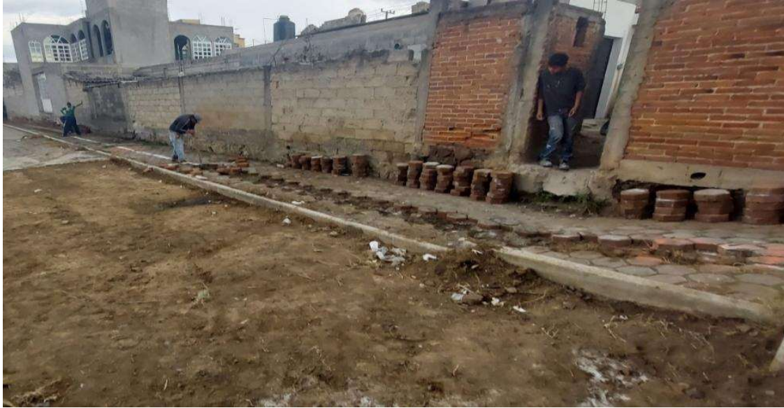
Figura 42. Retiro de adoquines
