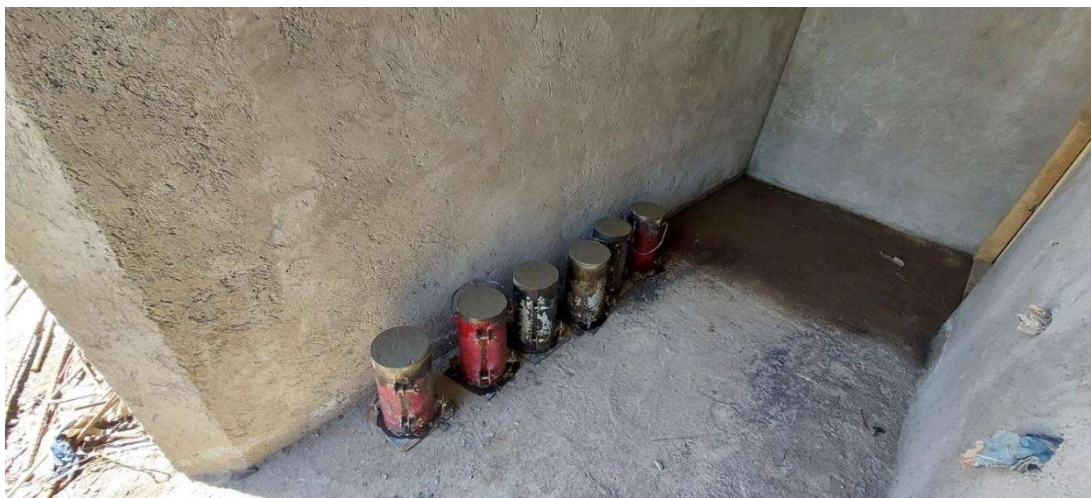
Figura 133. Prueba de compactación para alberca
