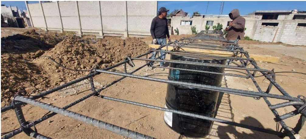
Figura 51. Armado de zapata
