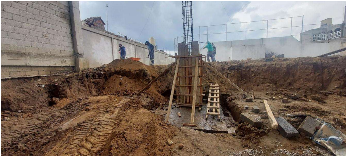
Figura 113. Cimbrado de columna
