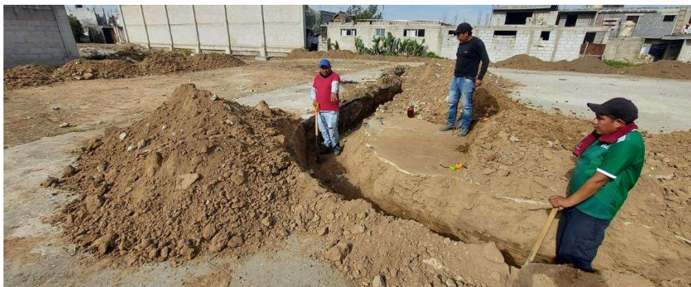
Figura 47. Afine de talud de cepa
