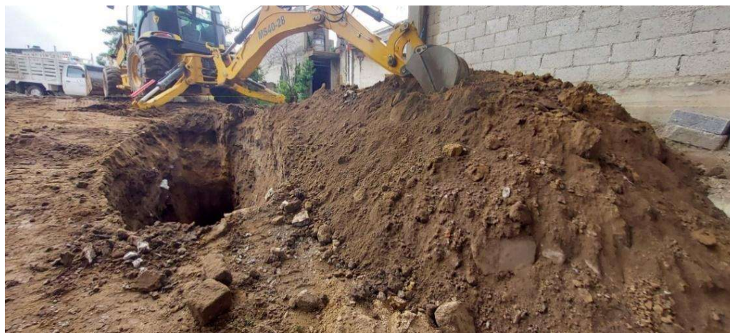
Figura 108. Excavación de cepas para columnas de Techumbre
