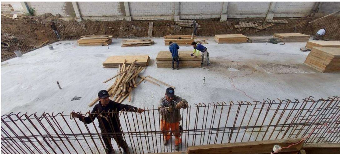
Figura 138. Armado de muros para alberca
