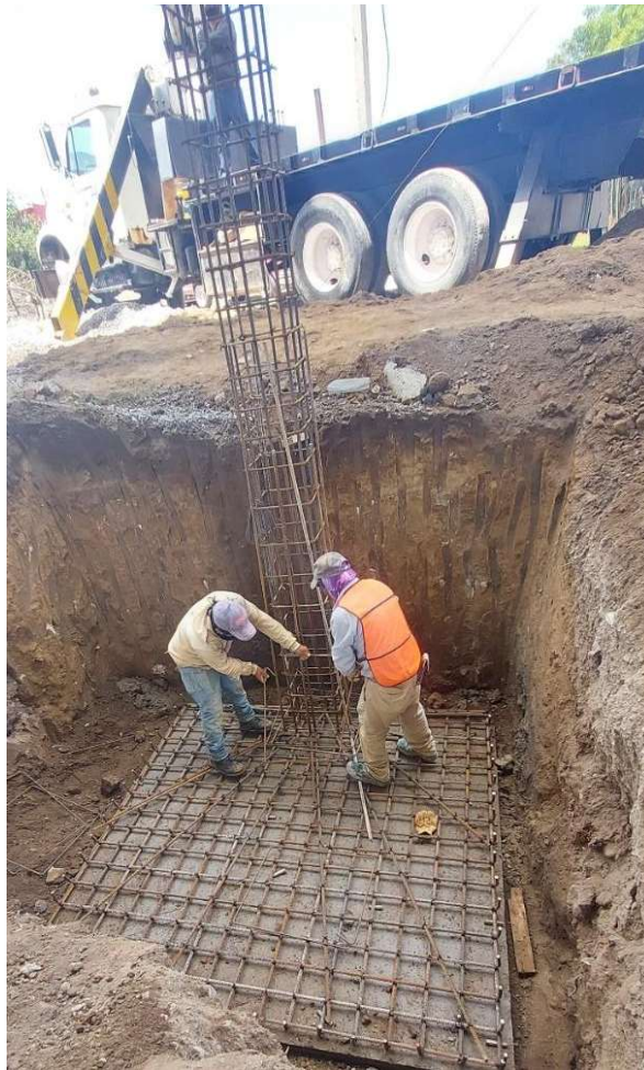
Figura 112. Anclaje de columna con zapata para techumbre
