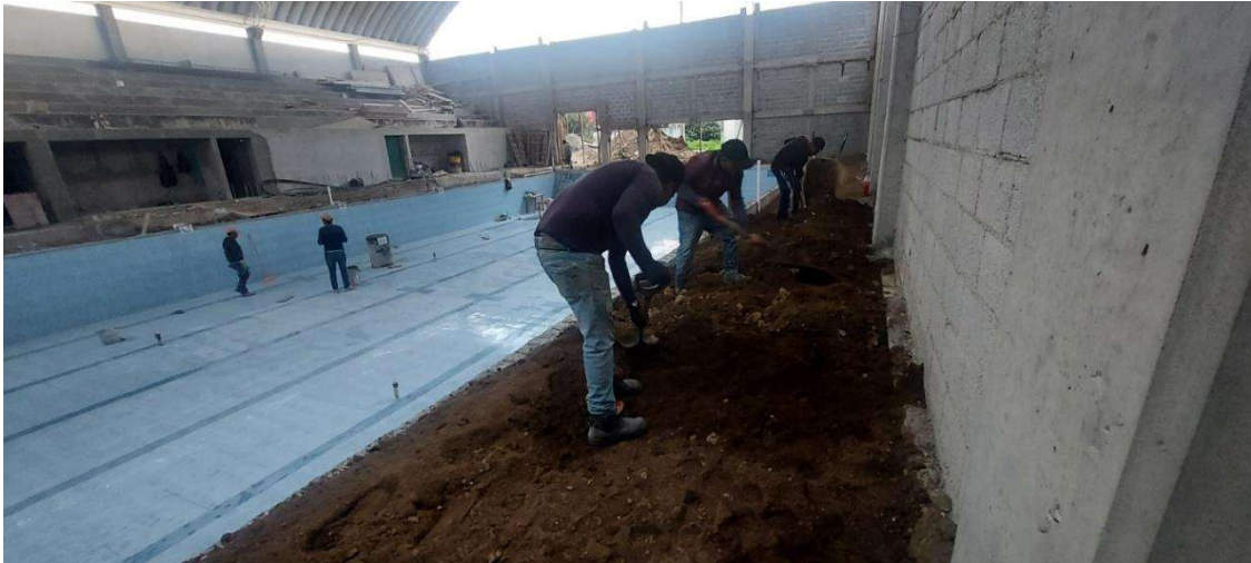
Figura 151. Relleno para nivelación entre andadores y alberca
