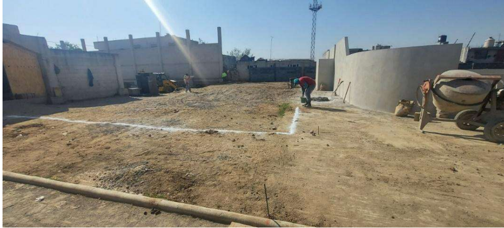
Figura 76. Trazo de cisterna
