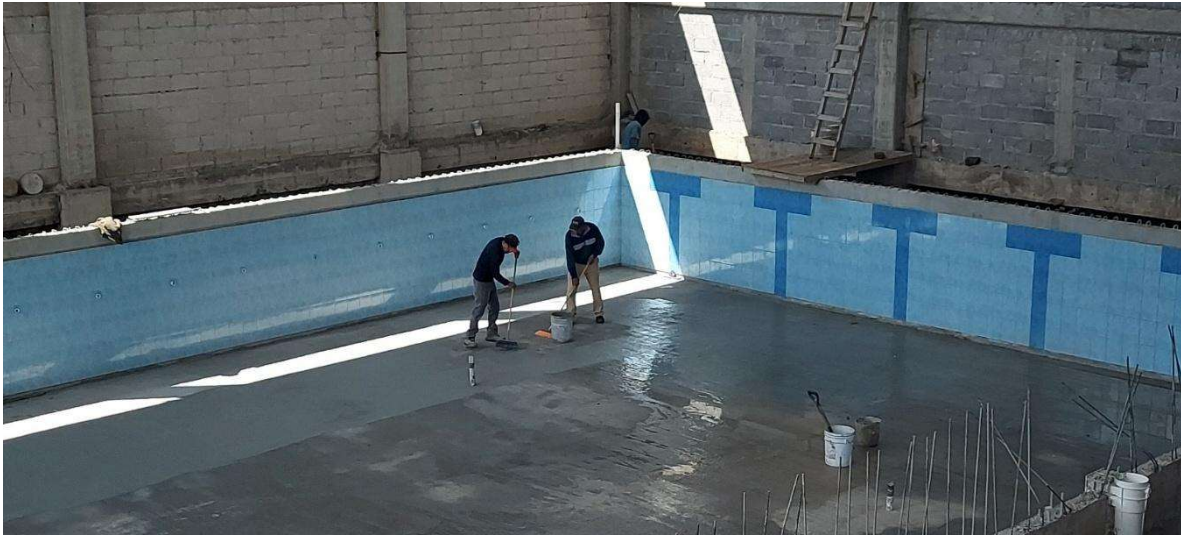
Figura 147. Impermeabilización de firme de alberca
