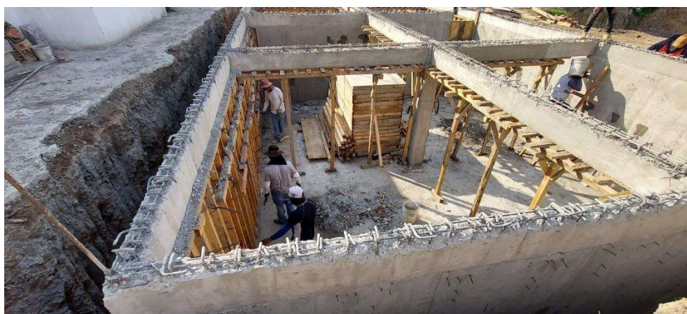
Figura 90. Descimbrado de muros de contención
