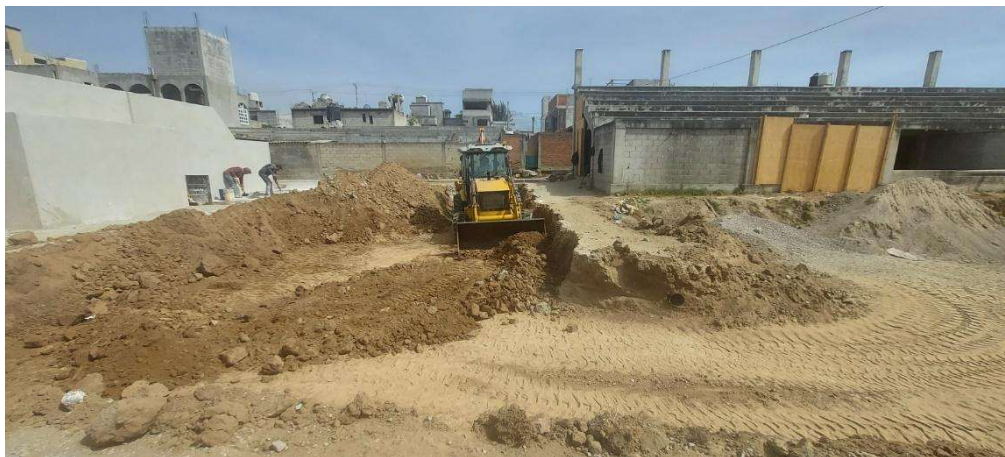
Figura 77. Excavación para cisterna
