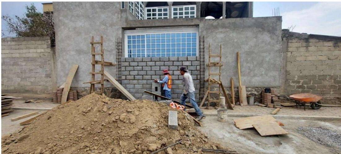
Figura 121. Muros perimetrales del polideportivo
