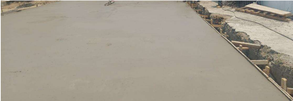
Figura 95. Colado de losa de concreto para cisterna
