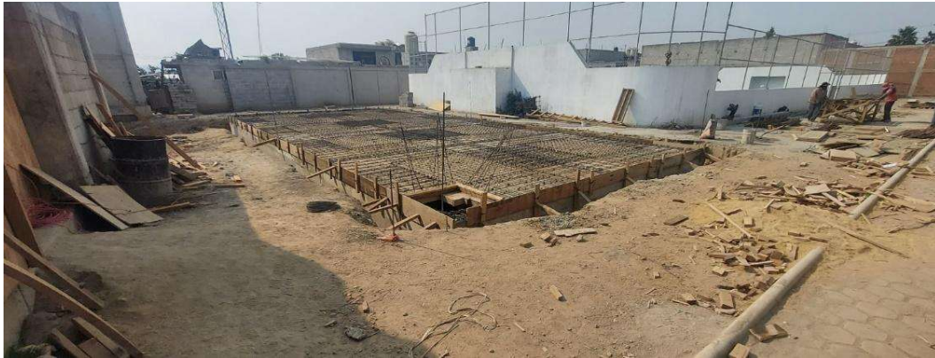
Figura 93. Armado de losa de concreto para cisterna
