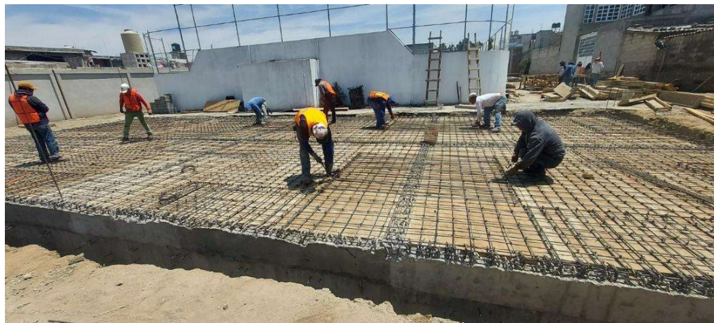
Figura 94. Cimbrado de frontera de losa de concreto
