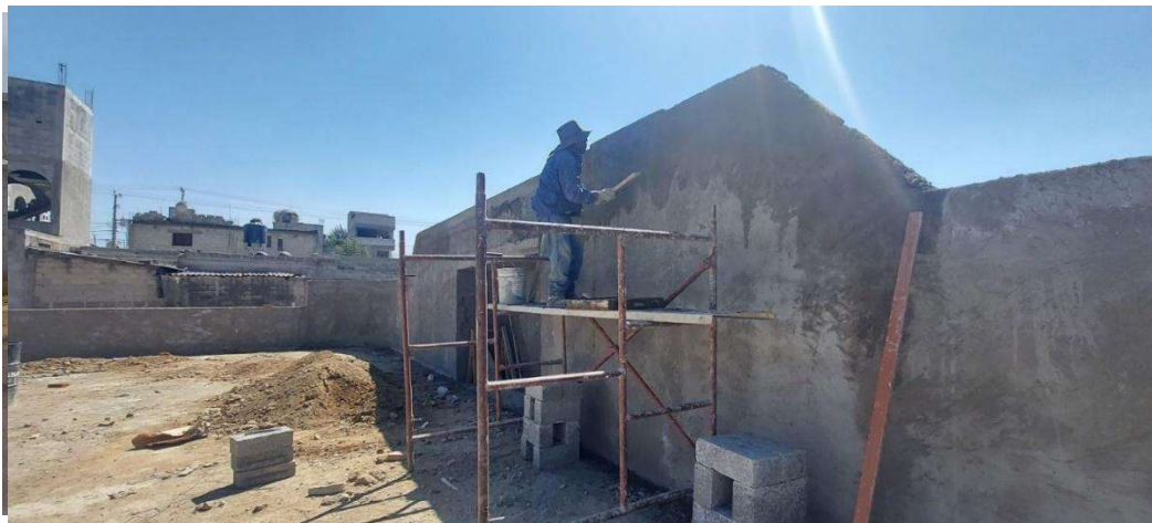
Figura 56. Repellado de muros en cancha de futbol 7
