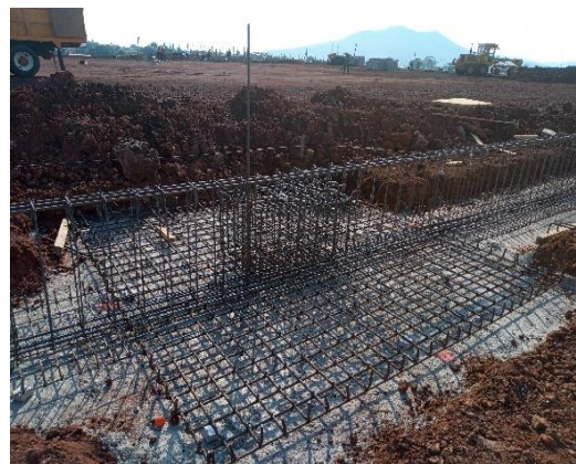
Ilustración 30 Habilidadado de zapata corrida. Fuente propia
