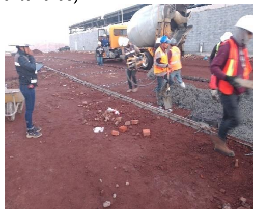
Ilustración 136 Colado de estacionamiento. Fuente propia
