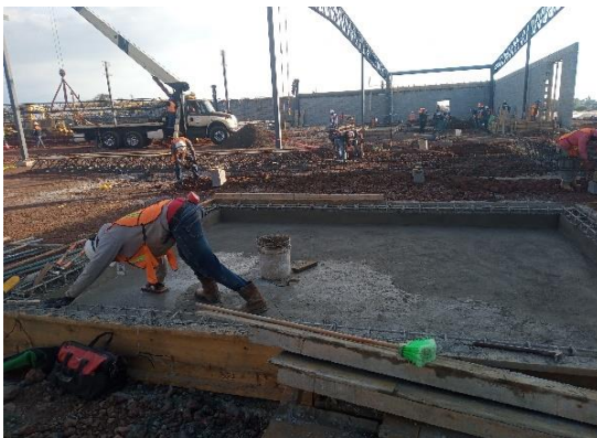
Ilustración 57 Pulido de cámara. Fuente propia
