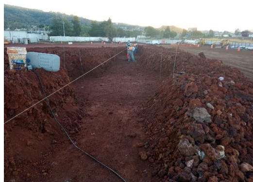
Ilustración 26 Afine en cepa. Fuente propia
