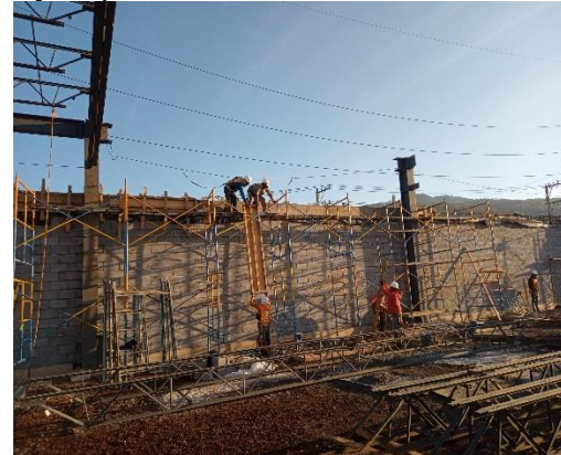
Ilustración 49 Descimbrado de dala. Fuente propia
