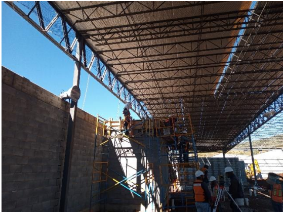
ilustración 65 Dala de cerramiento. Fuente propia
