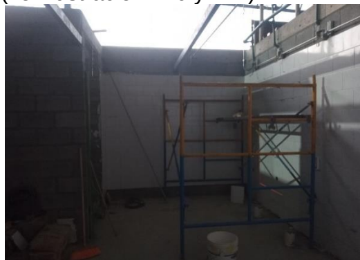
Ilustración 111 Azulejo en baños. Fuente propia
