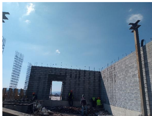
Ilustración 83 Rallado de muro de block. Fuente propia
