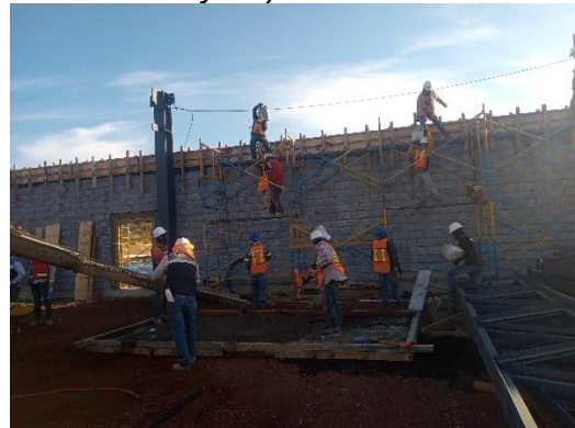
Ilustración 51 Colado de dala. Fuente propia
