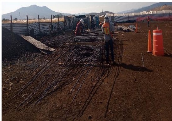
Ilustración 9 Habilitado de acero. Fuente: propia
