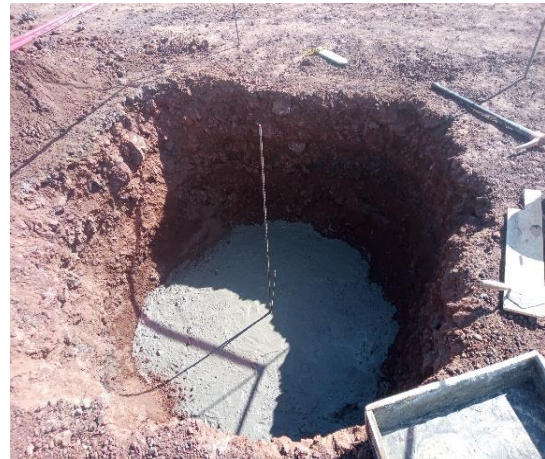
Ilustración 89 Plantilla en pozo. Fuente propia
