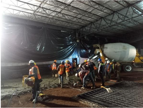
Ilustración 72 Tendido de concreto. Fuente propia
