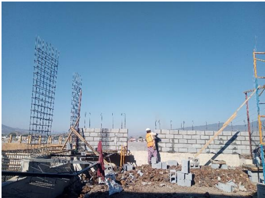
Ilustración 82 Muro de block. Fuente propia
