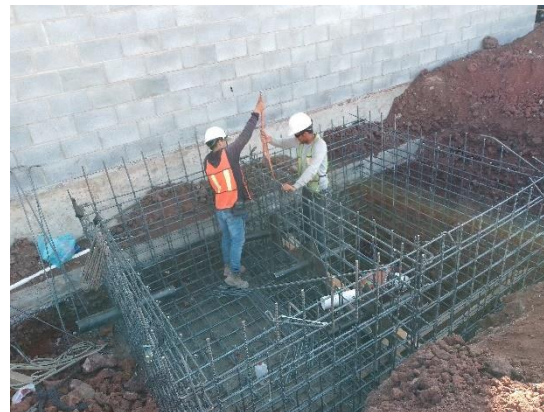
Ilustración 141 Acero en cárcamo. Fuente propia
