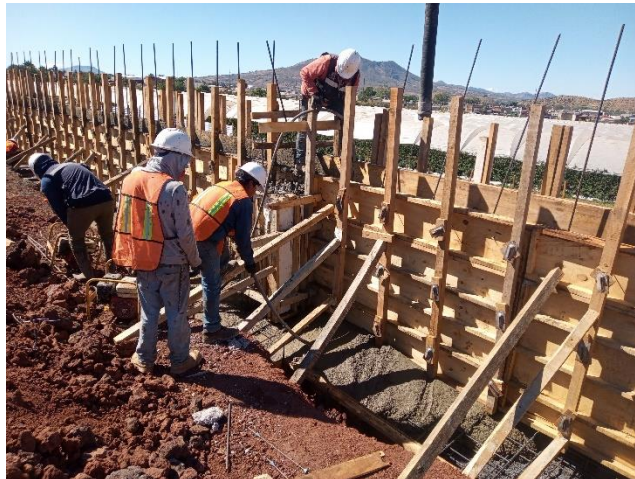
Ilustración 24 Colado de zapata. Fuente propia
