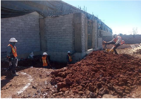
Ilustración 80 Inicio de excavación. Fuente propia
