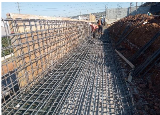
Ilustración 106 colocación de cimbra. Fuente propia
