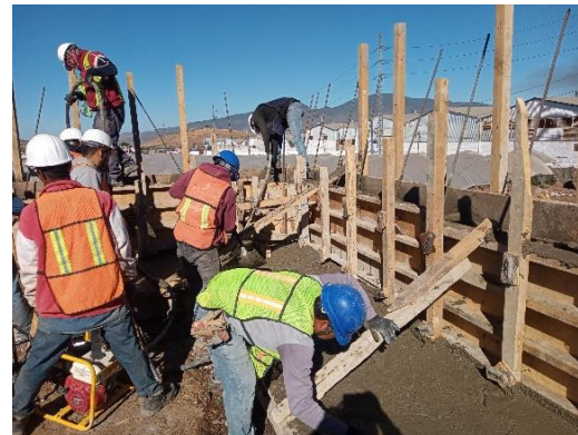
Ilustración 62 Colado de cimentación. Fuente propia
