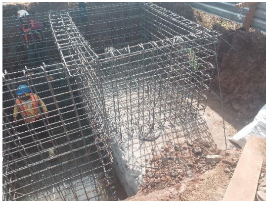
Ilustración 127 Acero en cárcamo. Fuente propia
