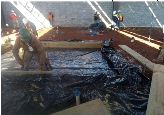
Ilustración 69 Colocación de tablón. Fuente propia
