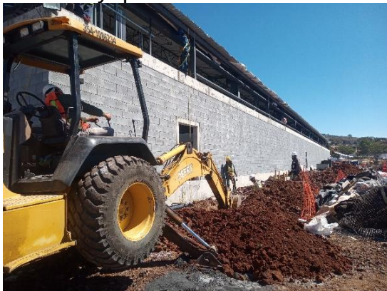
Ilustración 96 Excavación a máquina. Fuente propia
