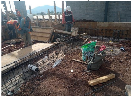
Ilustración 54 Habilitado de dala de desplante. Fuente propia
