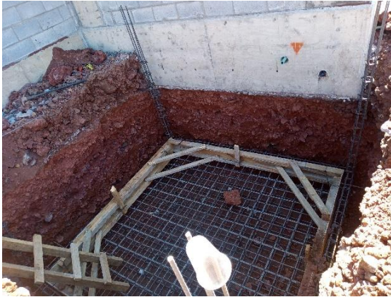
Ilustración 86 Cimbra perimetral. Fuente propia
