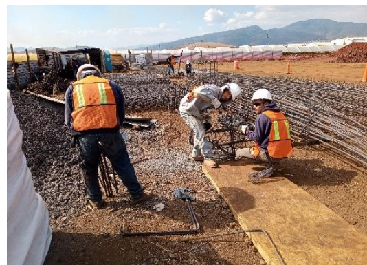
Ilustración 10 Habilitado de acero. Fuente: propia
