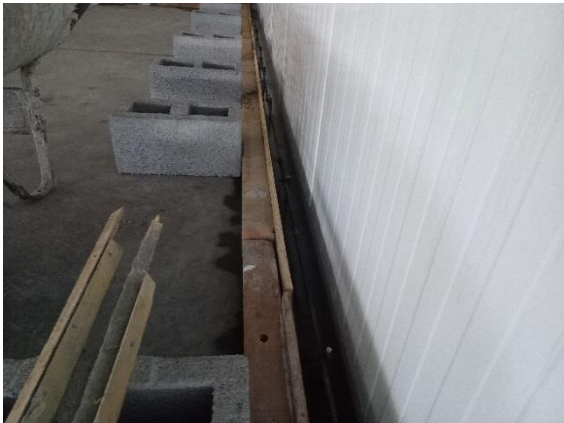
Ilustración 114 Cimbra en sardinel. Fuente propia
