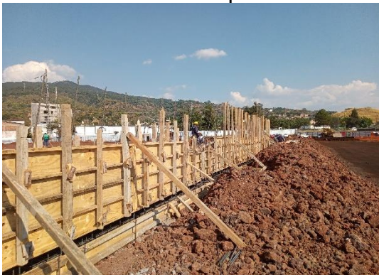
Ilustración 35 Cimbra de zapata corrida. Fuente propia
