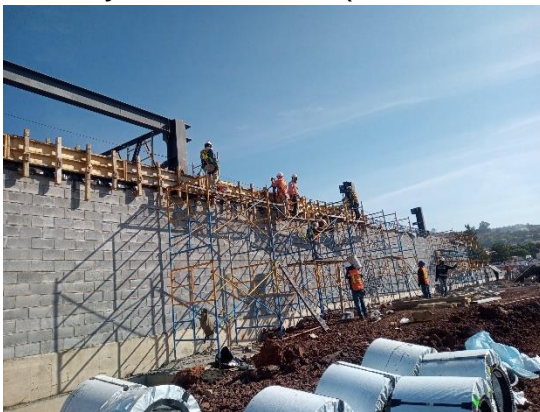
Ilustración 48 Colocación de cimbra en dala. Fuente propia
