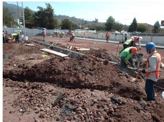
Ilustración 146 Guarnición de islas. Fuente propia
