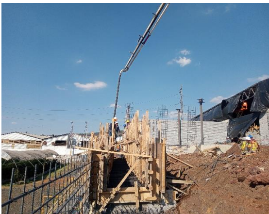
Ilustración 90 Colado de muro. Fuente propia
