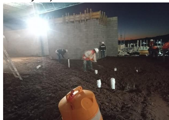
Ilustración 68 Tendido de tierra, Fuente propia
