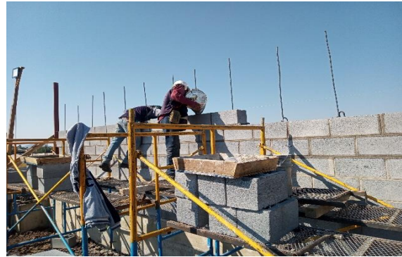
Ilustración 32 Colado de castillo ahogado, Fuente propia
