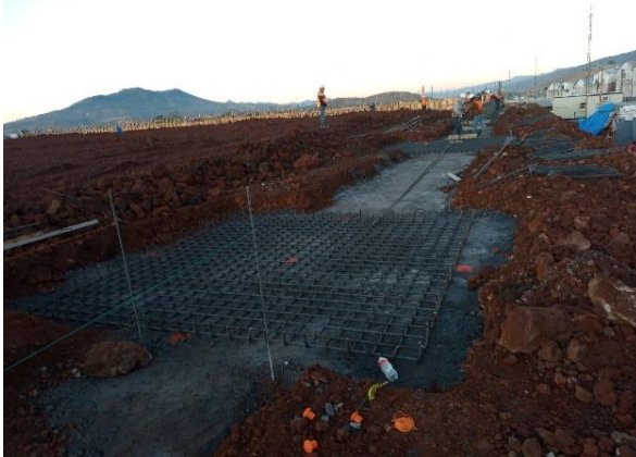
Ilustración 29 Habilidadado de zapata. Fuente propia
