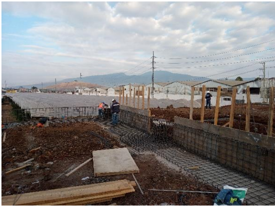
Ilustración 59 colocación de cimbra. Fuente propia
