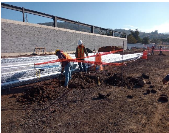
Ilustración 88 Excavación de pozo. Fuente propia
