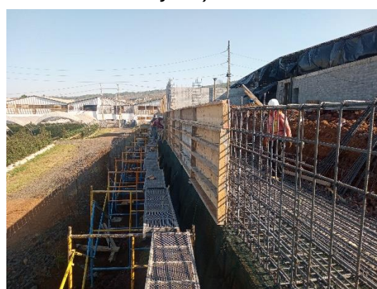
Ilustración 85 Habilitado de acero. Fuente propia
