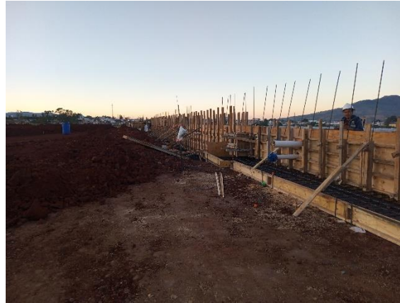
Ilustración 23 Cimbra en cimentación. Fuente propia
