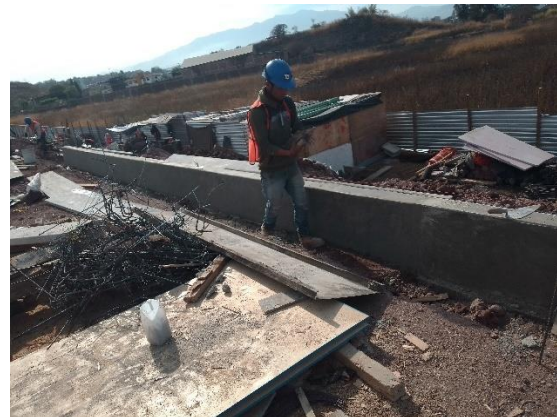
Ilustración 133 Descimbrado de guarnición. Fuente propia
