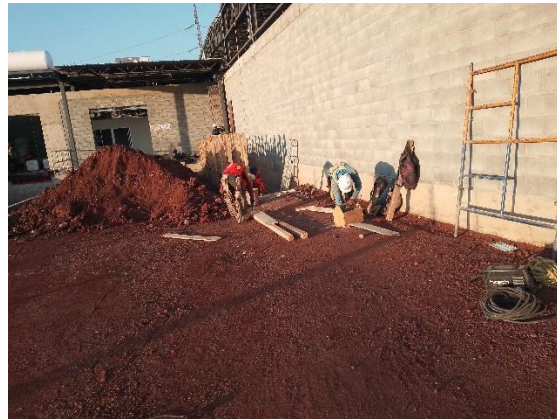
Ilustración 131 Corte de madera para muros. Fuente propia
