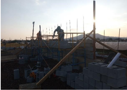
Ilustración 31 colocación de block. Fuente propia
