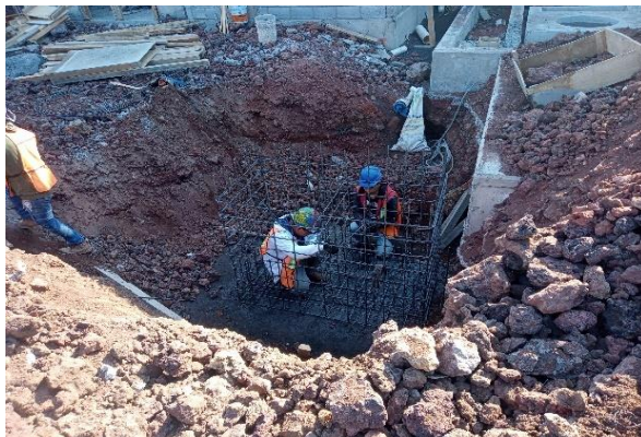
Ilustración 100 Habilitado de acero. Fuente propia
