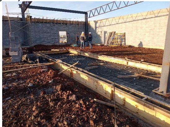
Ilustración 58 Cimbra en cámaras. Fuente propia
