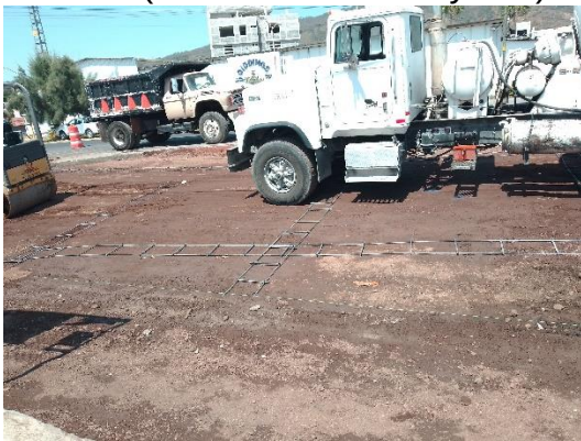
Ilustración 149 Junta JAR. Fuente propia
