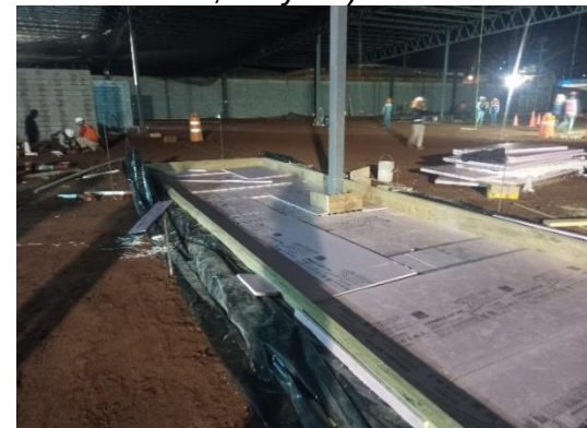
Ilustración 70 Fomular en cámaras. Fuente propia
