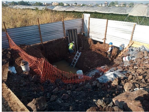
Ilustración 126 Excavación en cárcamo. Fuente propia
