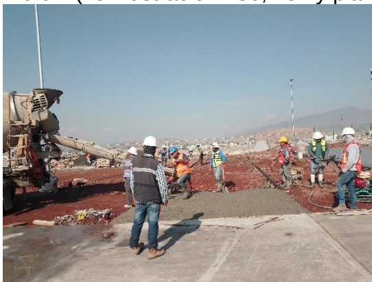
Ilustración 136 Colado de estacionamiento. Fuente propia
