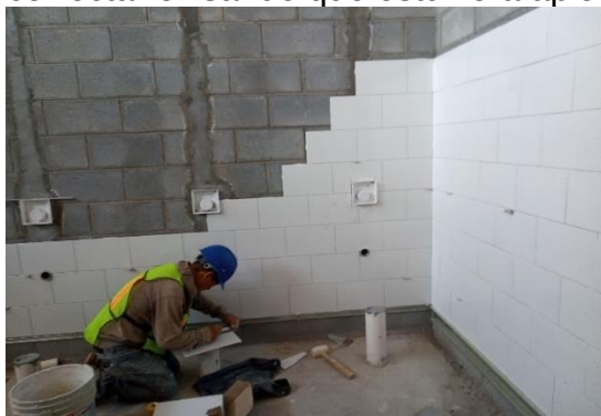
Ilustración 110 colocación de azulejo. Fuente propia
