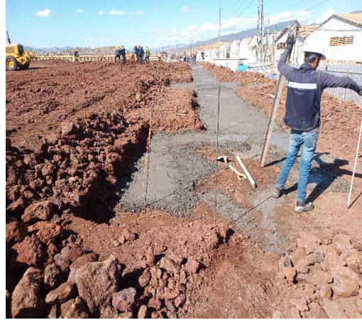
Ilustración 28 Colado de plantilla. Fuente propia
