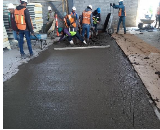
Ilustración 95 nivelación de piso. Fuente propia
