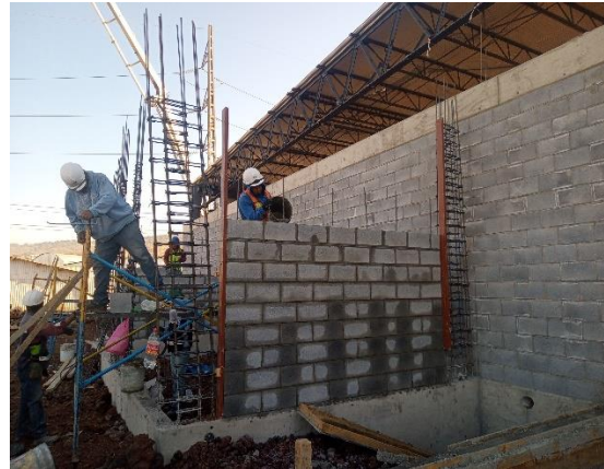
Ilustración 66 colocación de block, Fuente propia
