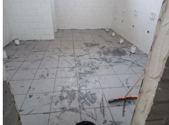
Ilustración 113 Riego de sello. Fuente propia
