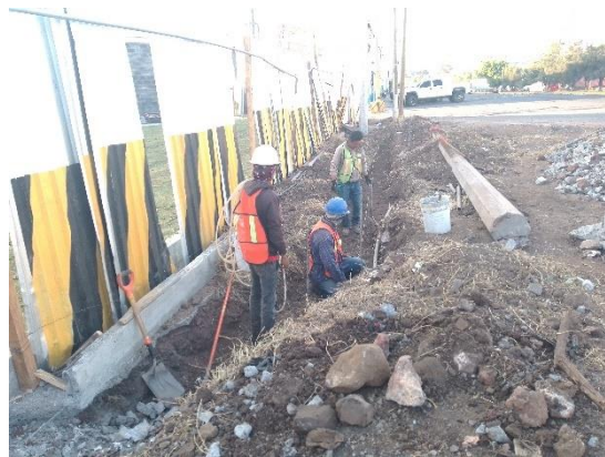
Ilustración 148 Nivelación de guarnición fuente propia
