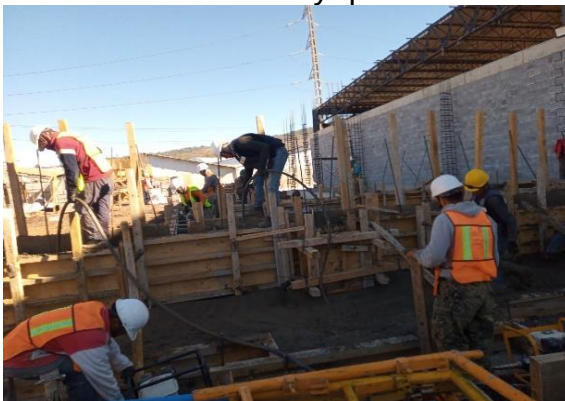
Ilustración 61 Vibrado de concreto. Fuente propia
