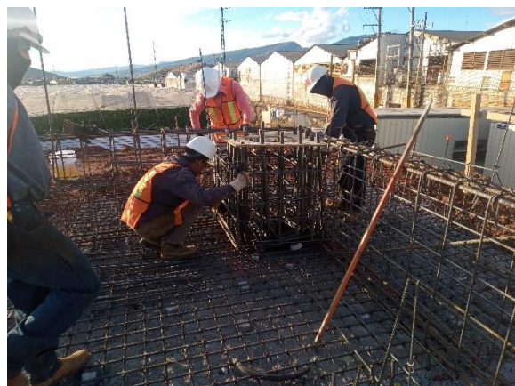
Ilustración 21 nivelación de anclas. Fuente propia
