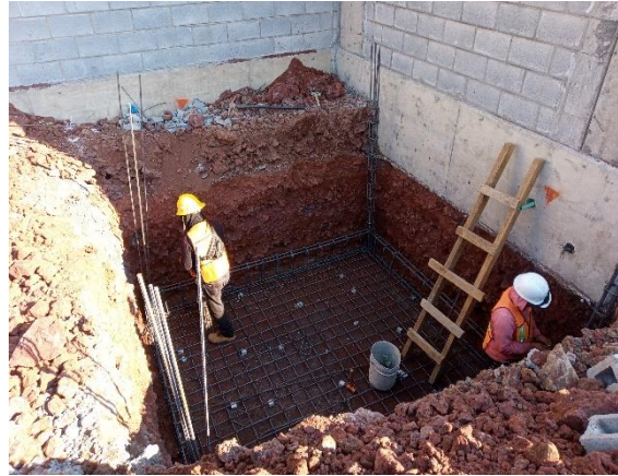
Ilustración 87 Habilitado de acero. Fuente propia
