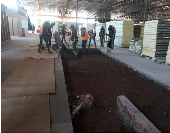
Ilustración 94 Colado de piedra. Fuente propia
