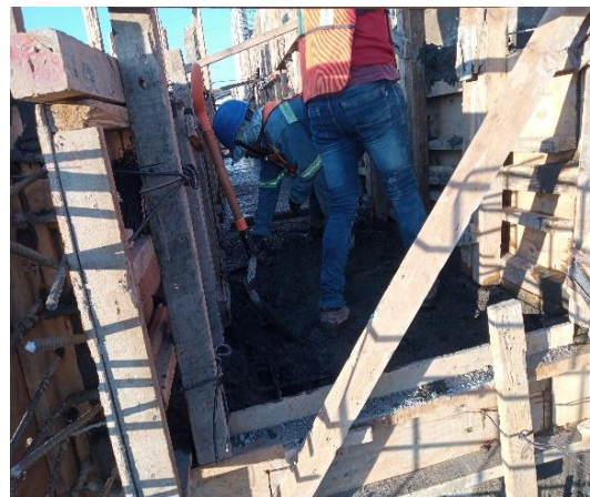
Ilustración 91 Vibrado en el colado. Fuente propia
