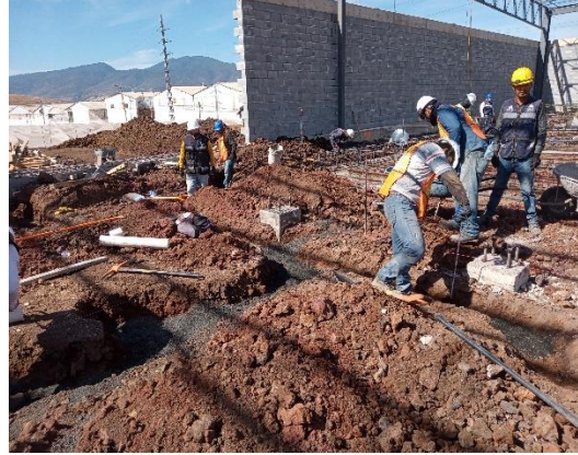
Ilustración 53 Cama de arena. Fuente propia
