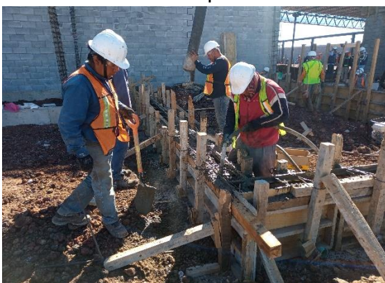
Ilustración 63 Colado. Fuente propia
