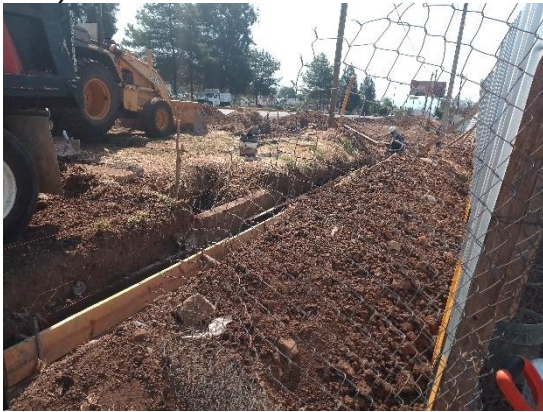
Ilustración 147 Cimbra en guarnición. Fuente propia
