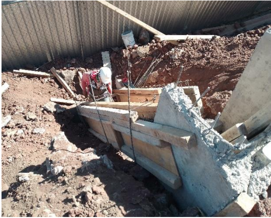
Ilustración 120 Cimbra en lavadero. Fuente propia
