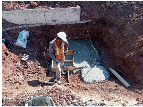
Ilustración 99 Plantilla de concreto. Fuente propia
