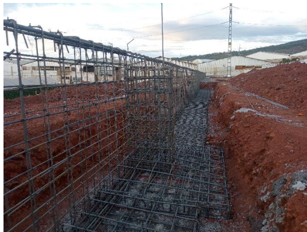
Ilustración 19 Acero de cimentación. Fuente propia
