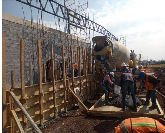
Ilustración 56 Colado de cimentación. Fuente propia
