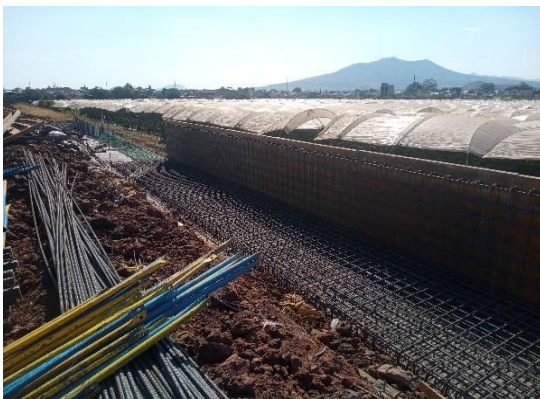
Ilustración 104 Habilitado de acero. Fuente propia
