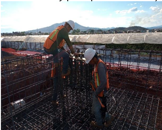
Ilustración 20 colocación de anclas. Fuente propia
