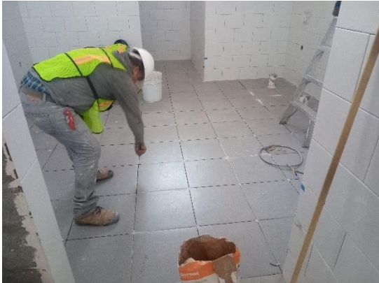
Ilustración 112 Sello en juntas. Fuente propia
