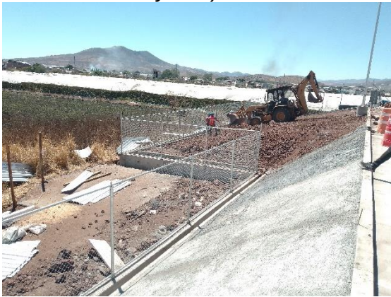
Ilustración 134 Retiro de material. Fuente propia
