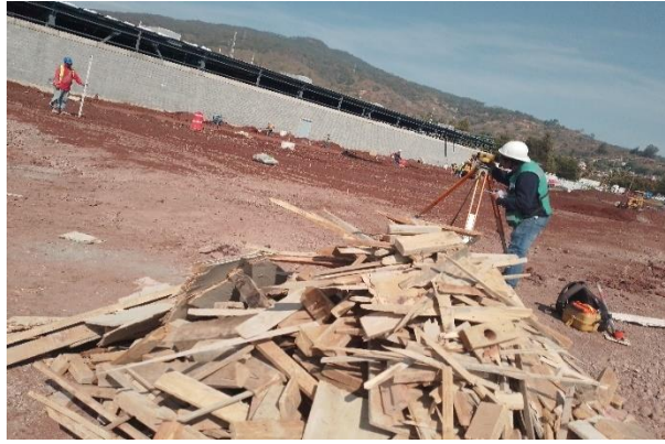
Ilustración 129 nivelación de muro. Fuente propia
