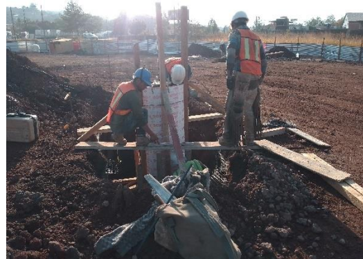
Ilustración 125 Cimbra en poste. Fuente propia
