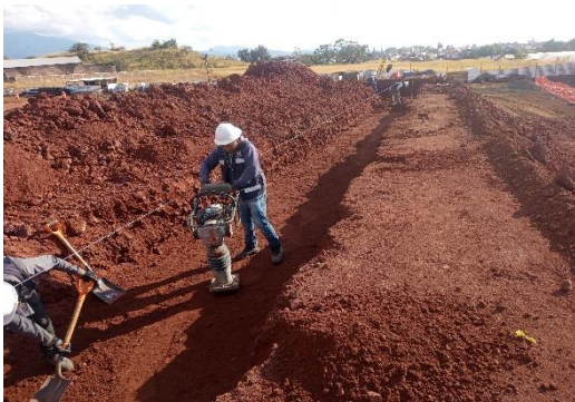
Ilustración 13 Afine en cepa. Fuente propia
