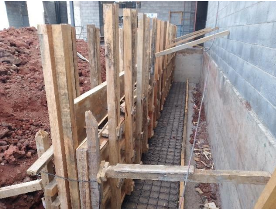
Ilustración 130 Cimbra en muro. Fuente propia
