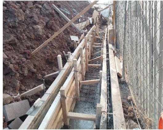
Ilustración 121 Canal 2. Fuente propia
