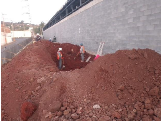
Ilustración 138 Excavación en cárcamo. Fuente propia
