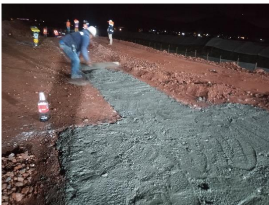
Ilustración 15 Colado de plantilla. Fuente propia
