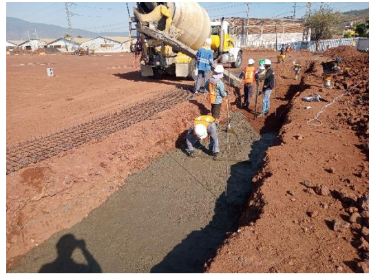
Ilustración 42 Colado de plantilla. Fuente propia
