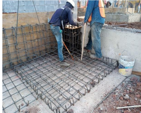
Ilustración 60 nivelación de anclas. Fuente propia
