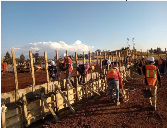
Ilustración 43 Colocación de cimbra. Fuente propia
