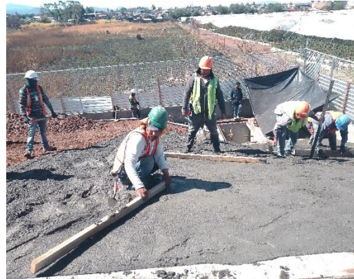
Ilustración 135 colocación de concreto. Fuente propia
