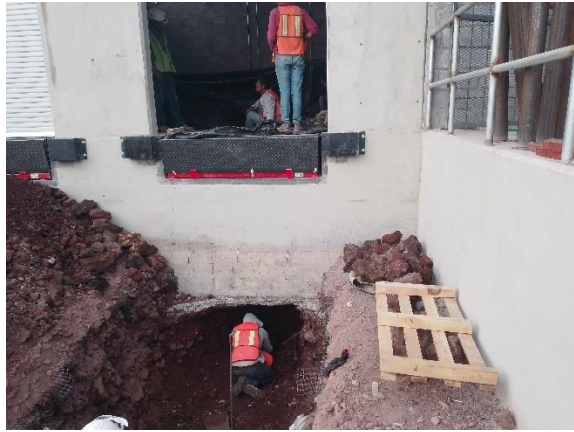
Ilustración 119 Excavación en túnel. Fuente propia
