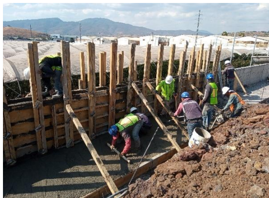
Ilustración 107 Colado de muro. Fuente propia
