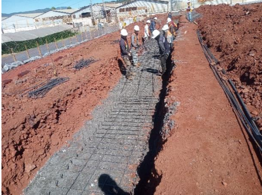
Ilustración 17 Habilitado de acero. Fuente propia
