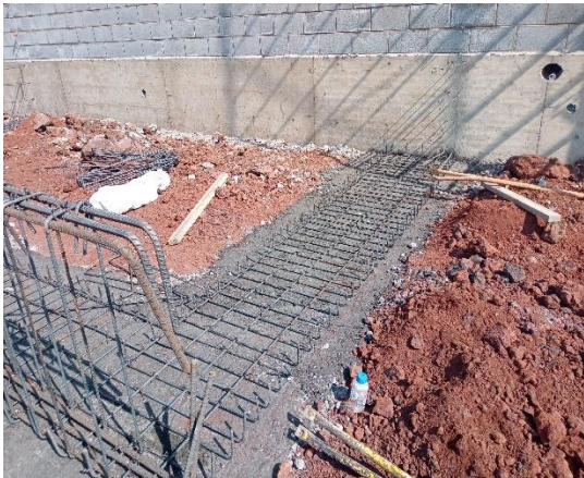
Ilustración 55 Habilitado de acero. Fuente propia
