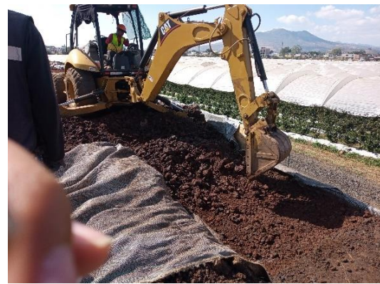
Ilustración 105 Excavación a máquina. Fuente propia
