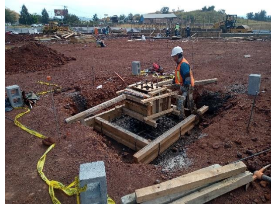
Ilustración 40 Cimbra de zapata y dado. Fuente propia
