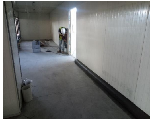
Ilustración 115 Detallado de sardinel. Fuente propia
