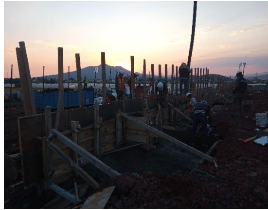
Ilustración 38 Colado de zapata corrida. Fuente propia
