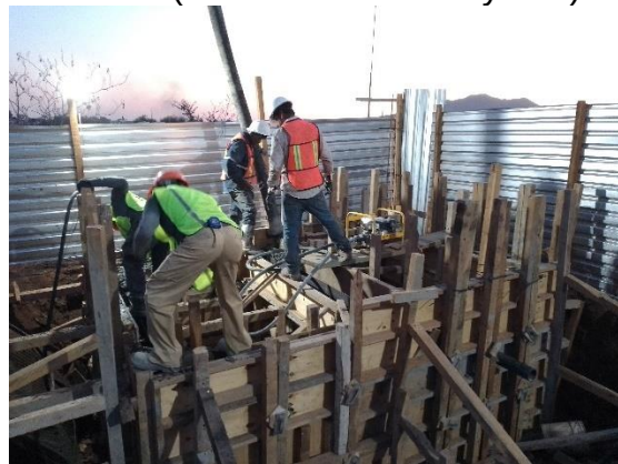
Ilustración 128 Colado de cárcamo. Fuente propia
