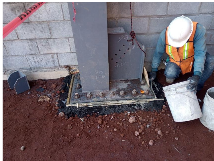
Ilustración 75 Limpieza de placa
