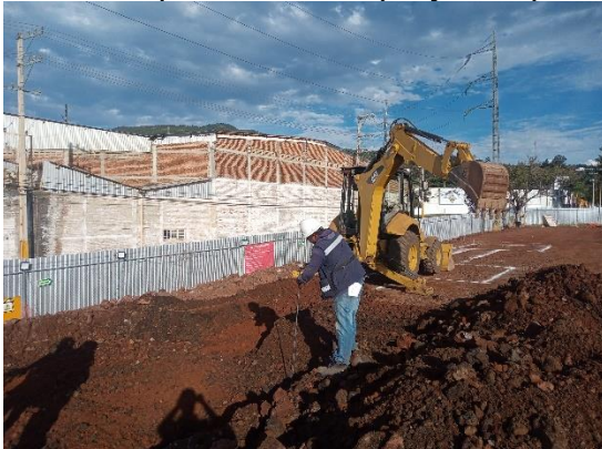
Ilustración 25 nivelación de cepa. Fuente propia
