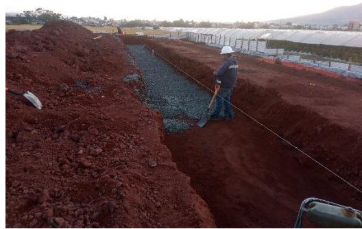
Ilustración 14 Colado de plantilla. Fuente propia
