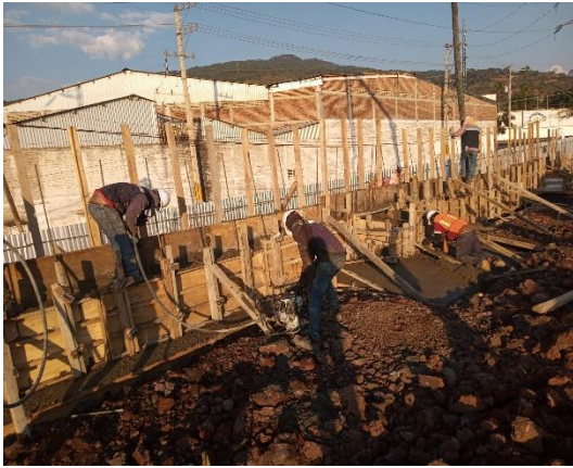
Ilustración 37 Pulido de colado. Fuente propia
