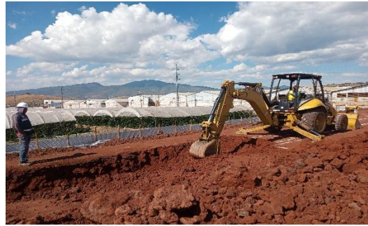
Ilustración 12 Excavación. Fuente propia
