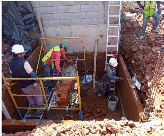
Ilustración 93 colocación de tabique. Fuente propia
