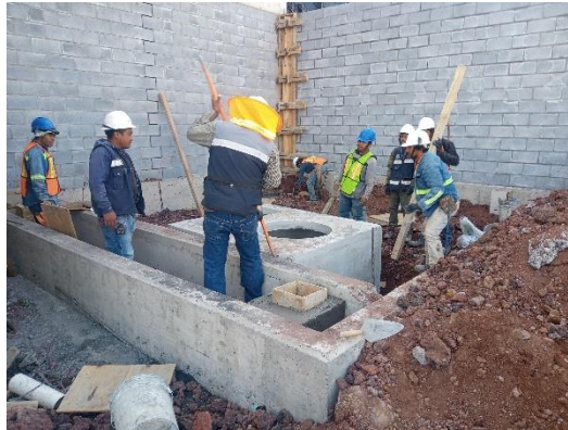
Ilustración 92 colocación de registro. Fuente propia
