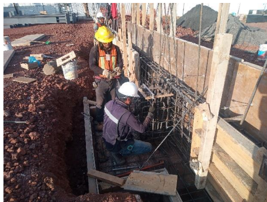
Ilustración 45 colocación de ancla. Fuente propia
