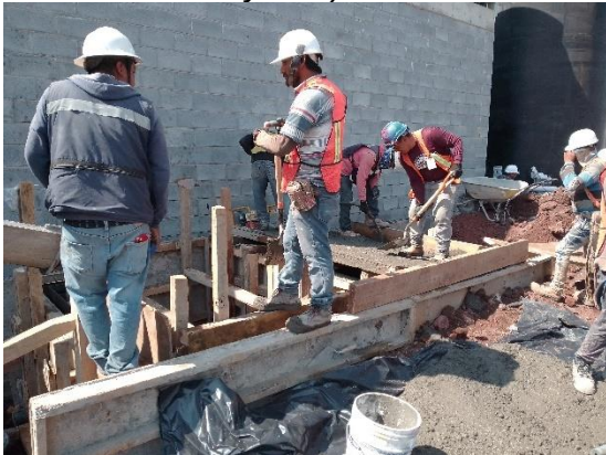
Ilustración 140 Colado de cárcamo. Fuente propia
