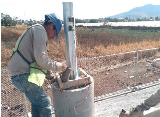
Ilustración 124 colocación de grout. Fuente propia
