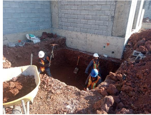
Ilustración 81 Excavación. Fuente propia
