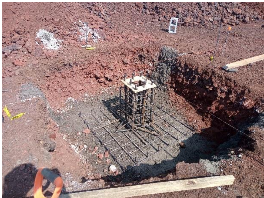
Ilustración 39 Habilitado de zapata. Fuente propia
