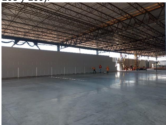
Ilustración 108 Lavado de piso. Fuente propia
