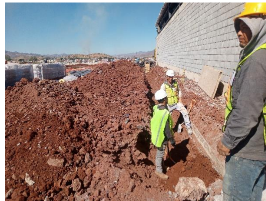
Ilustración 97 Afine de sepa. Fuente propia
