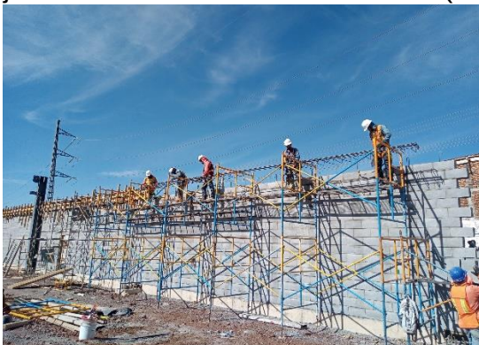
Ilustración 50 Habilidado de dala. Fuente propia
