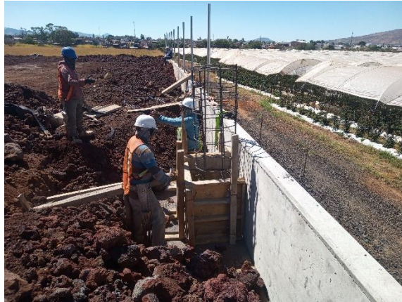
Ilustración 98 Colocación de cimbra. Fuente propia
