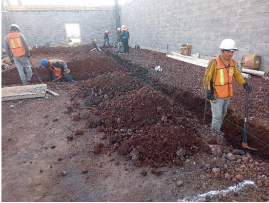
Ilustración 52 Excavación de cepa. Fuente propia
