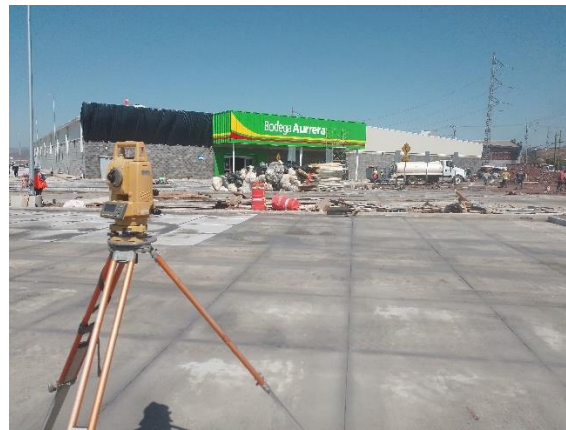
Ilustración 143 nivelación de estacionamiento. Fuente propia
