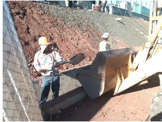
Ilustración 123 Retiro de material. Fuente propia
