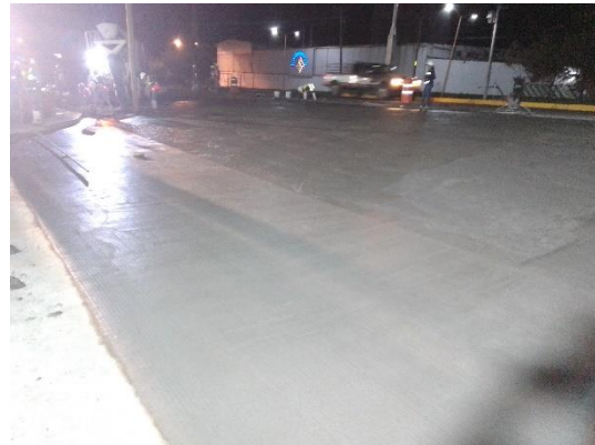
Ilustración 150 Colado de piso. Fuente propia
