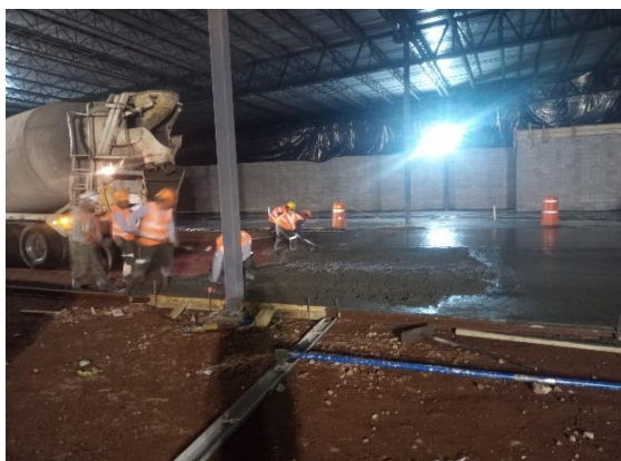
Ilustración 76 Tendido de concreto. Fuente propia
