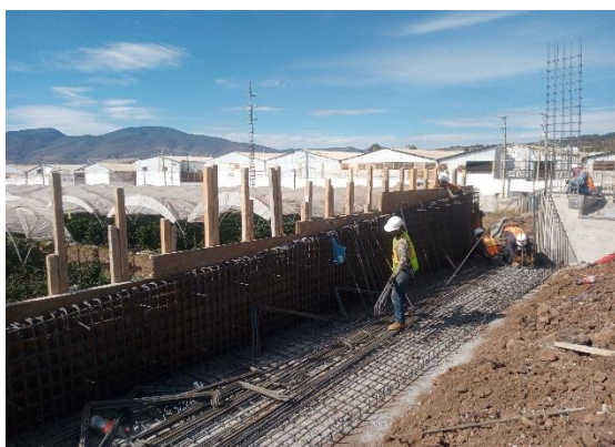
Ilustración 78 Habilitado de acero. Fuente propia
