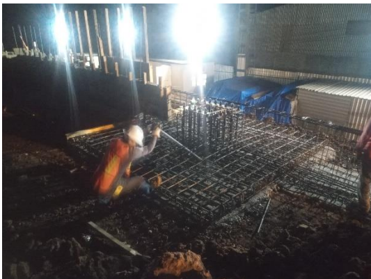
Ilustración 33 Anclas en zapata. Fuente propia
