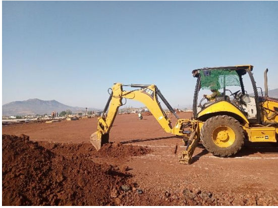
Ilustración 41 Excavación de cepa. Fuente propia.
