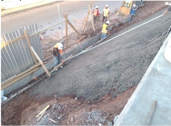
Ilustración 122 Concreto lanzado. Fuente propia
