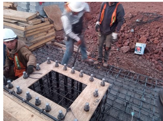
Ilustración 34 nivelación de anclas, Fuente propia
