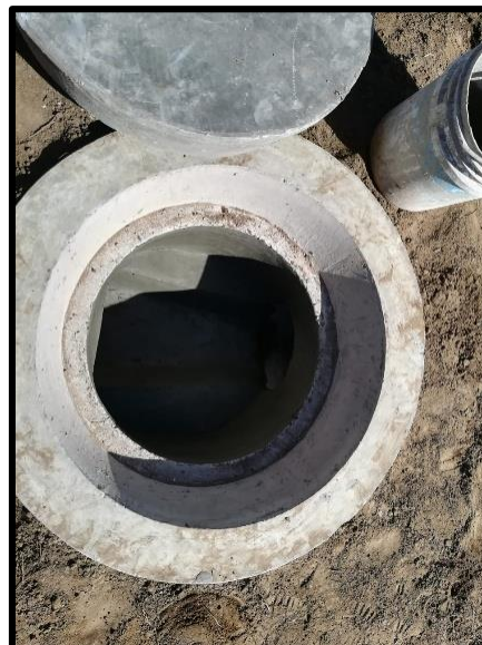
IMAGEN 14: REALIZACIÓN DE POZOS DE VISITA CON SU MEDIA CAÑA. CON DIMENSIONES CON UN DIÁMETRO INICIAL DE 1.20CM Y FINAL DE 60 CM PARA SU COLOCACIÓN DEL BROCAL. FUENTE: PROPIA
