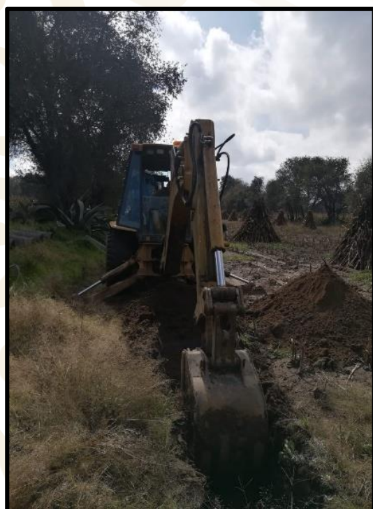
IMAGEN 11 TRABAJOS DE EXCAVACIÓN A UNA PROFUNDIDAD DE 1.80M BASADO A LOS NIVELES
