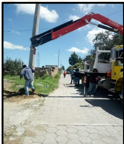
IMAGEN 17: INSTALACIÓN DE POSTES FUENTE: PROPIA
