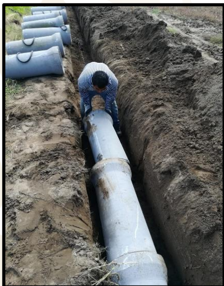
IMAGEN 13: CONTINUACIÓN DE TENDIDO DE TUBERÍA CON SU CAMA DE ARENA DE CON UN ESPESOR DE 5 CM FUENTE PROPIA
