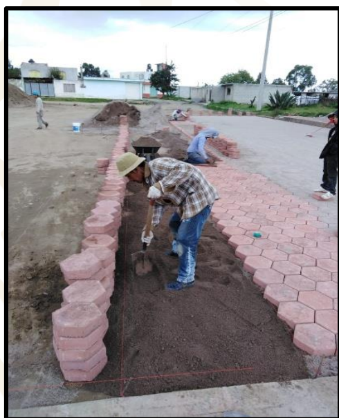
IMAGEN 9 COLOCACIÓN DE ADOQUÍN
