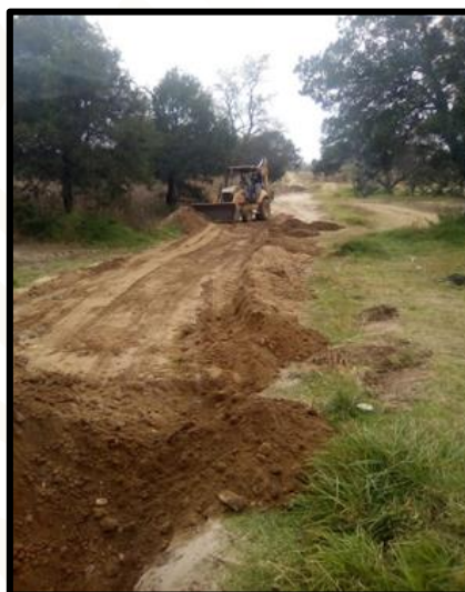
IMAGEN 15: RELLENO DE CEPA, CON PRODUCTO DE LA MISMA EXCAVACIÓN FUENTE: PROPIA
