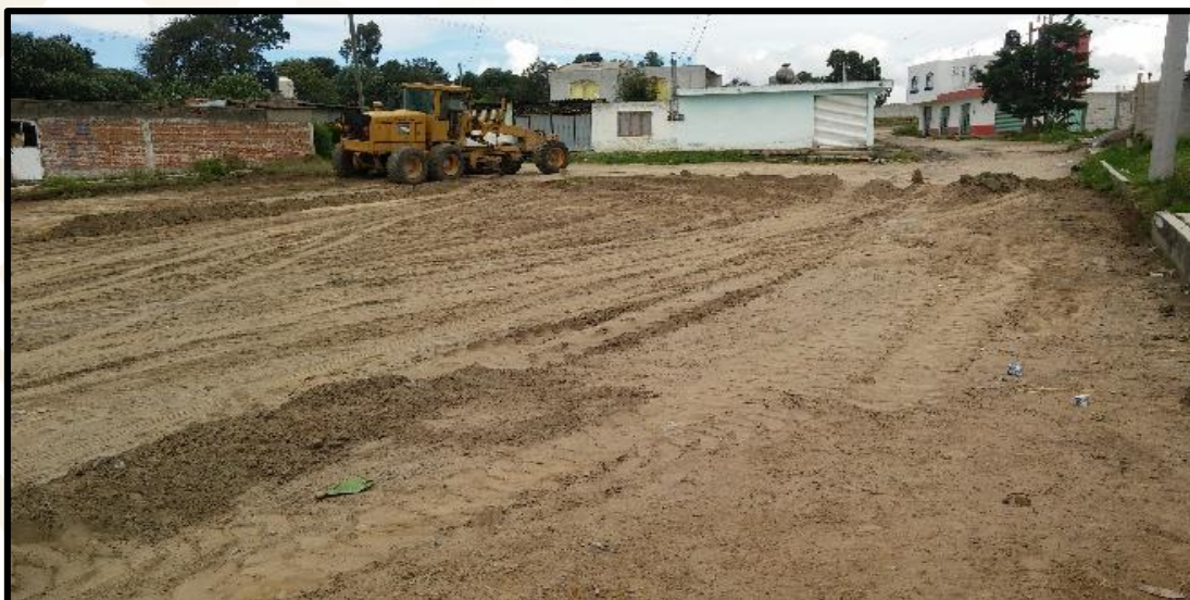
IMAGEN 7 NIVELACIÓN DE TERRAPLÉN EN EL SITIO DE LA OBRA DENOMINADA CONSTRUCCIÓN DE ADOQUÍN
