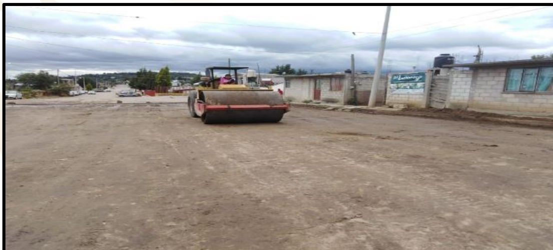
IMAGEN 8 COMPACTACIÓN DE BASE HIDRÁULICA EN SITIO DE LA OBRA DENOMINADA CONSTRUCCIÓN DE ADOQUÍN
