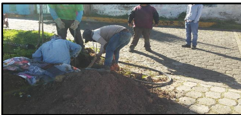
IMAGEN 16: EXCAVACIÓN DE CEPAS PARA EL PARADO DE POSTES DE UNA ALTURA DE 13 METRO. PARA POSTERIORMENTE HACER EL TENDIDO DE CABLE.
