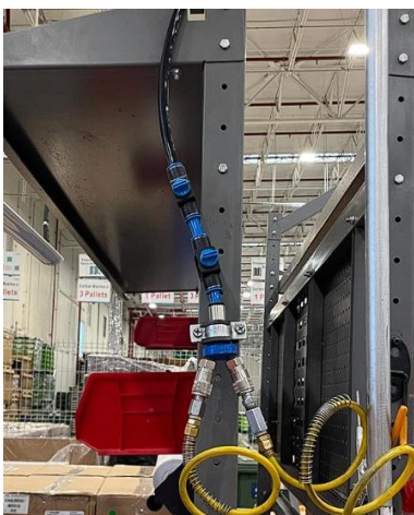
Ilustración 26 Tubería poliflo.
