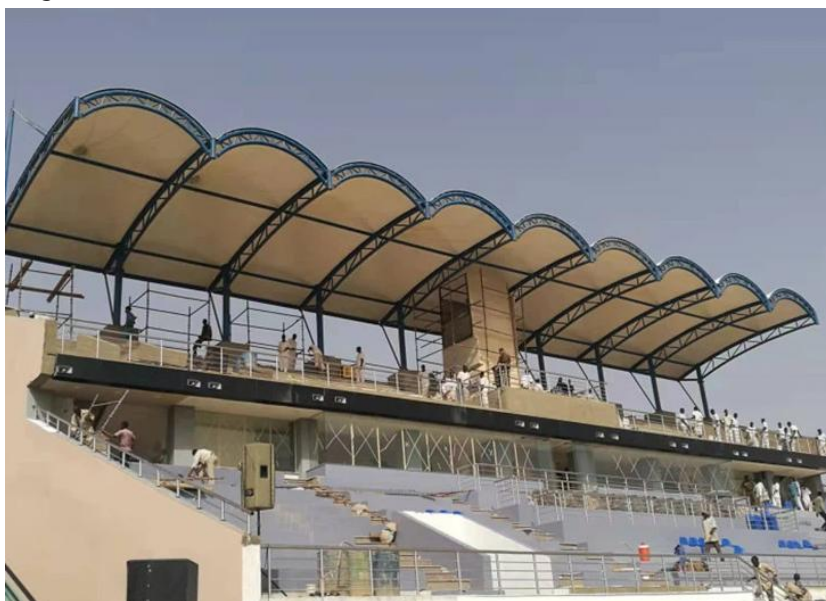
Figura 44 Cubierta de acero en arcos.
