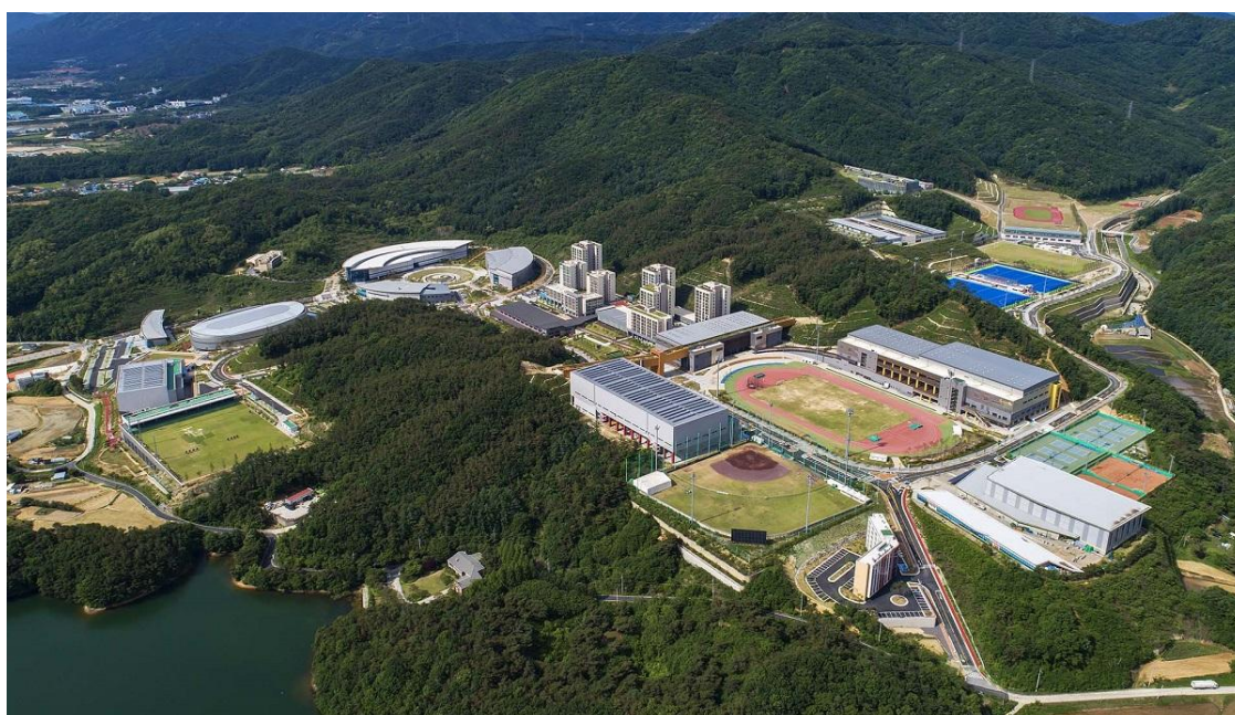
Figura 4 Vista aérea del Centro de Entrenamiento Nacional de Jincheon
