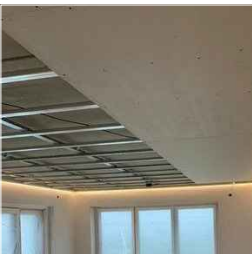
PLAFON DE TABLAROCA DE YESO
