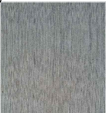
CONCRETO CON TEXTURIZADO ESCOBILLADO
