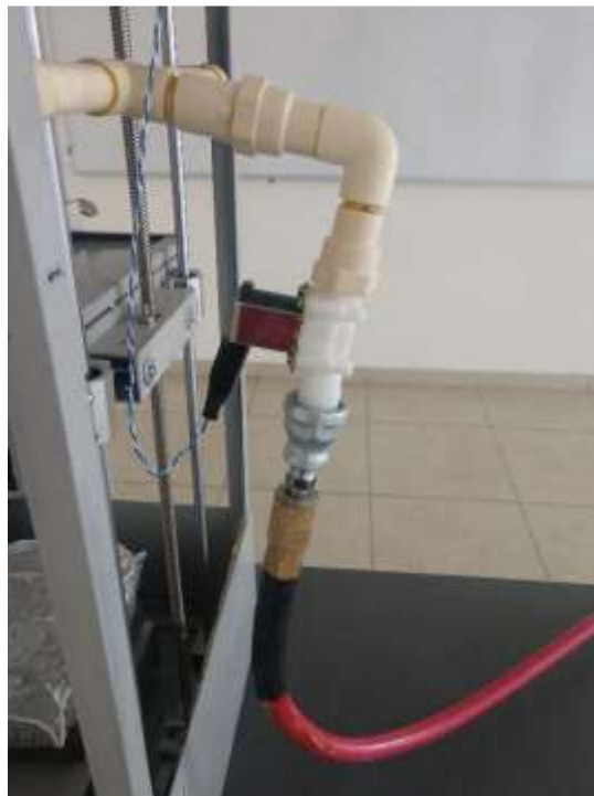
Figura 68. Válvula de control automatizado de enfriamiento.
