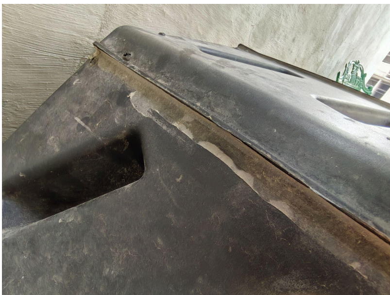
Fig. 19. Sello de silicona antihongos aplicado entre las capas que conforman la estructura del compostador.
