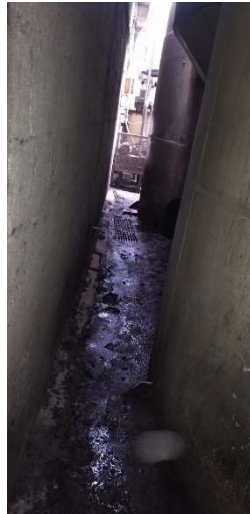
Ilustración 45 Zona de silos del 1 al 3
