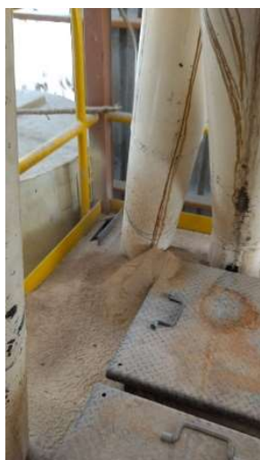
Ilustración 23 Piso del pasillo
