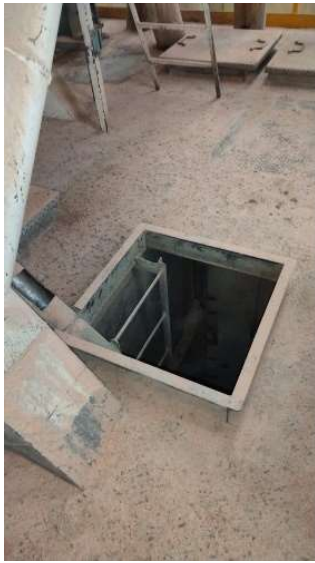
Ilustración 26 Piso del pasillo al harnero
