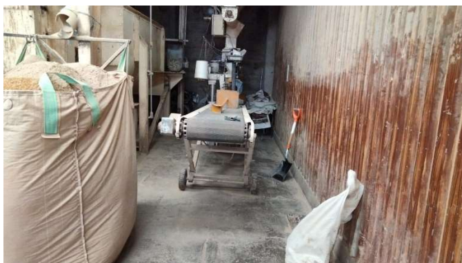
Ilustración 60 Mejora de línea tres.
